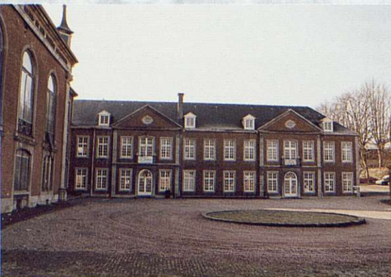
Aile moderne en retour d'équerre (6). Mur-pignon septentrional (7).
