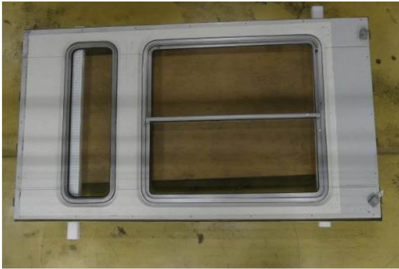
Panneau CIMT, menuiseries en aluminium de Jean Prouvé, CNAM (ANR Archipal)
