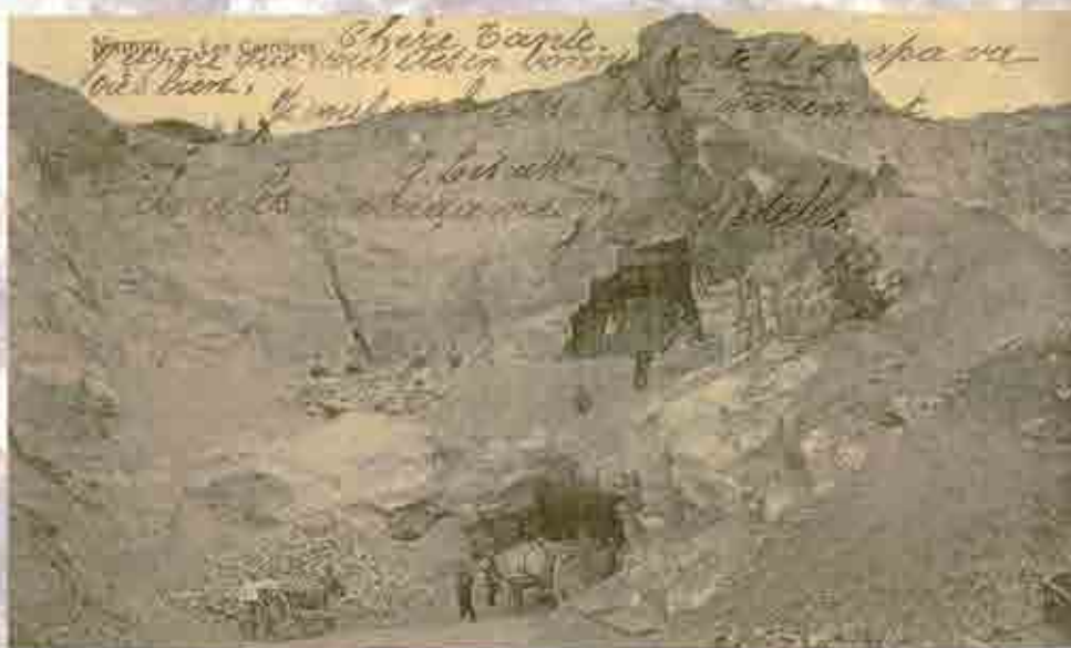
9. Exploitation en souterrain d'un gisement sub-horizontale : le marbre noir de Golzinne en 1929 : après le dégagement des strates supérieures par minage, sur la plus faible hauteur possible, les ouvriers doivent se glisser dans l'espace réduit pour extraire les premiers blocs rentables. Archives de la société Merbes-Sprimont.
