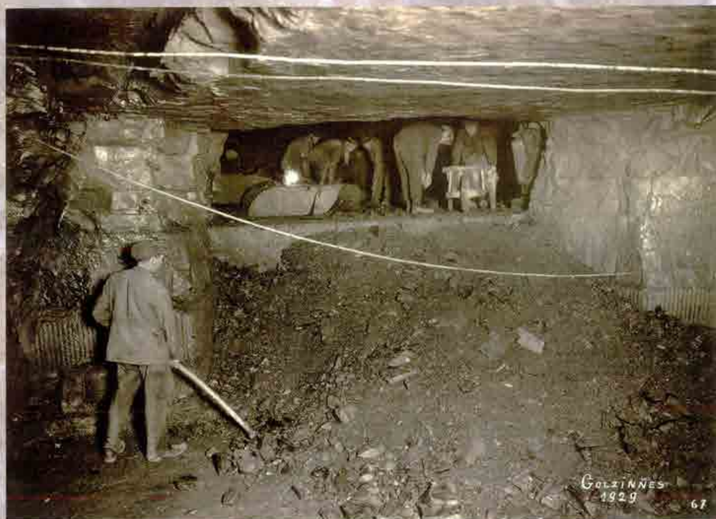
9. Exploitation en souterrain d'un gisement sub-horizontale : le marbre noir de Golzinne en 1929 : après le dégagement des strates supérieures par minage, sur la plus faible hauteur possible, les ouvriers doivent se glisser dans l'espace réduit pour extraire les premiers blocs rentables. Archives de la société Merbes-Sprimont.
