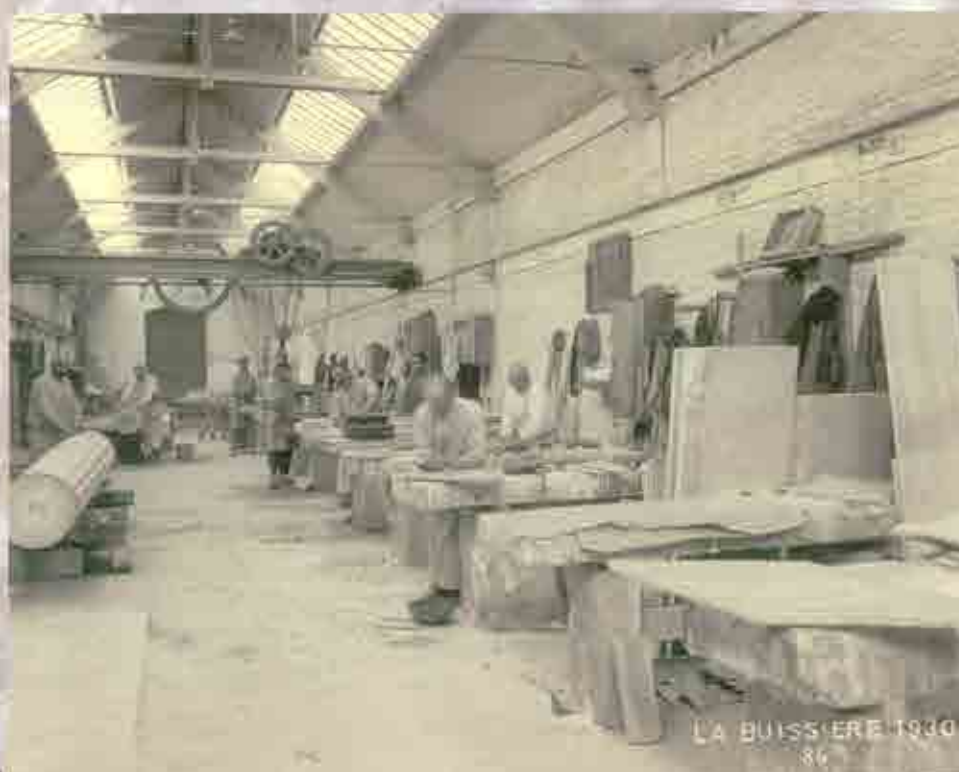
20. Le tour à colonne à la marbrerie de La Buisserie en 1930, l'ouvrier guidant l'outil sur le bloc en cours de tournage. Archives de la société Merbes-Sprimont.
