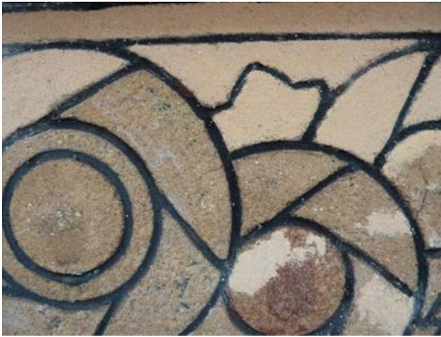
Fig. 35.- Rue de Chestret n° 20. Opération de bouchage : les lacunes dans l'enduit sont comblées.
