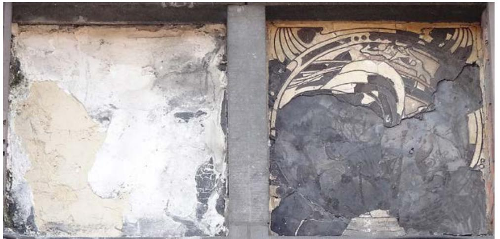
Fig. 66.- Rue du Laveu n° 28. La dégradation des panneaux s'est encore accentuée.
