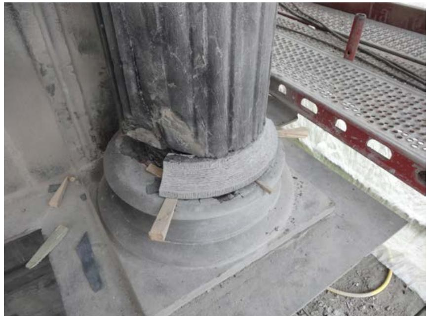
Fig. 11.- Le maintien de la substance historique est privilégié. Le remplacement d'une pierre est réalisé lorsqu'il n'est pas possible de la brocher ou d'effectuer un greffon.
