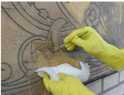
Fig. 32.- Rue de Chestret n° 20. Opération d'enlèvement du surpeint des années 1990 sur un des panneaux supérieurs.
