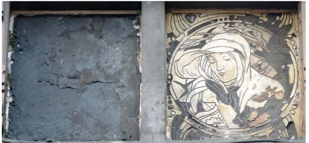
Fig. 65.- Rue du Laveu n° 28. La comparaison avec la photo précédente montre la dégradation du panneau de gauche suite à une infiltration d'eau.
