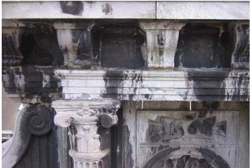
Fig. 6-7.- Infiltrations d'eau dans la maçonnerie.
