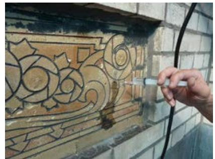
Fig. 34.- Rue de Chestret n° 20. Injection d'un produit entre les couches d'enduit pour les recoller.
