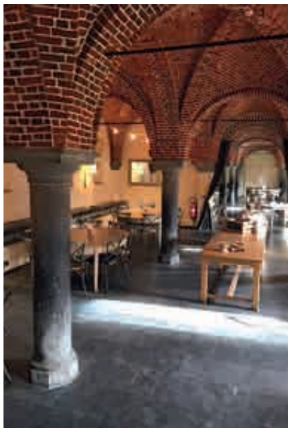
Fig. 20.- Idem, étables orientales, voûtes du rez-de-chaussée © Fanny Bosson.
