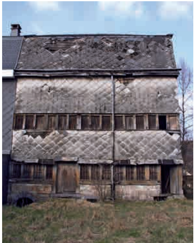
Fig. 22.- Idem, façade arrière. © Alissa Diffels, 2018.
