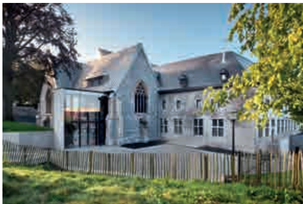
Fig. 10.- Eupen, couvent Heidberg, façade nord, entrée du centre de séminaire.
