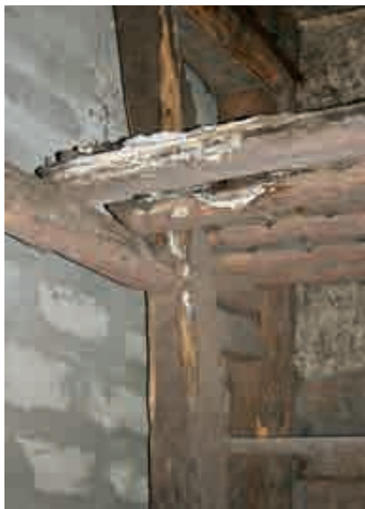
Fig. 28.- Idem, mérulle attaquant les bois de la structure porteuse.
