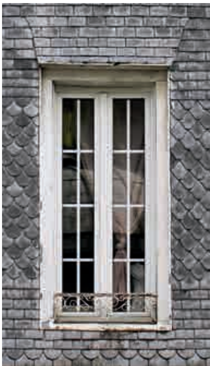
Fig. 21.- Malmedy, place du Pont Neuf n° 15, fenêtre.
