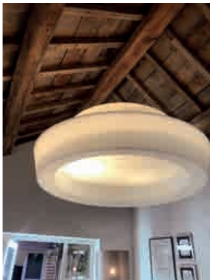
Fig. 30.- Namur, hôtel NE5T, charpente constituée de poutres de récupération. © Fanny Bosson.
