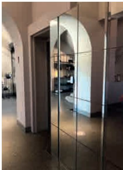
Fig. 34.- Maasmechelen, hôtel Terhills, ascenseur central, porte automatique coupe-feu camouflée par des miroirs. © Fanny Bosson.
