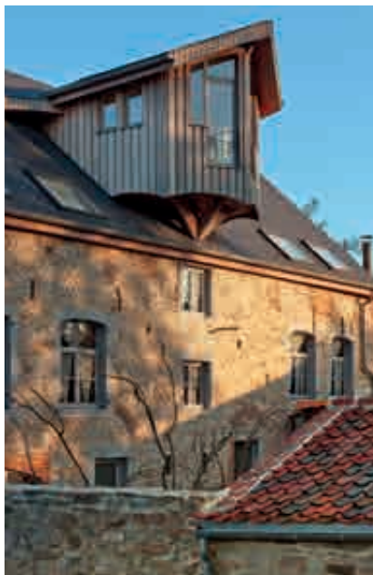
Fig. 18.- Namur, hôtel NE5T, façade arrière, détail. © Hôtel NE5T.
