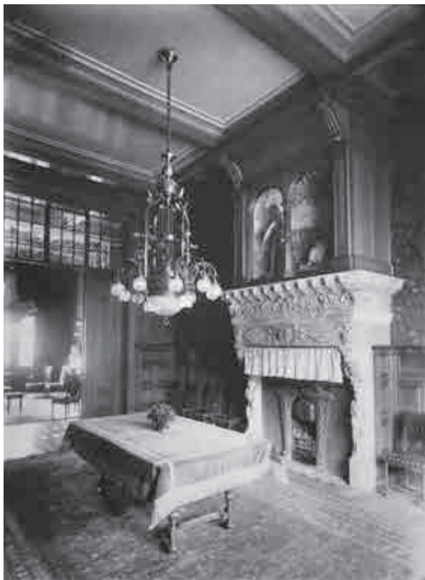
Fig. 38.- Liège, hôtel Braconnier : cheminée de la salle à manger, photographie non datée.
