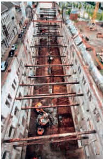
Fig. 16.- Verviers, hôtel Van der Valk, chantier de destruction et reconstruction de la structure intérieure.
