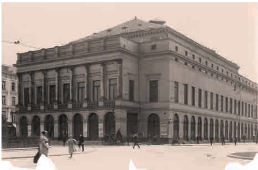
Fig. 16.- Cette photographie (sans indication, 138 x 90 mm) se distingue de la vue précédente par ses châssis foncés et par le changement de toutes les menuiseries du rez-de-chaussée ; le grand appareil des pierres bleues transparaît sous le badigeon du rez-de-chaussée ; on notera le réseau arachnéen des câbles, qui viennent s'ancrer dans les façades. Collections a.s.b.l. « Pierres et Marbres de Wallonie ».
