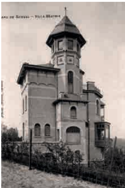
Fig.27.- Genval-les-Eaux, Villa Béatrix, façade orientale. Carte postale ancienne. Collection Francis Broche. D'après Rétro Rixensart (URL : https://www.retrorixensart.com [dernière consultation le 09/10/2018]).
