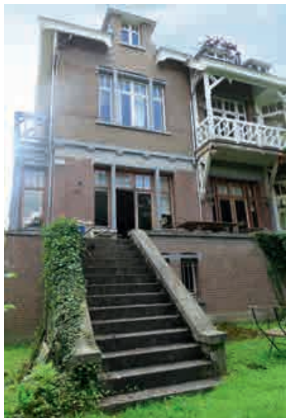
Fig. 40.- Genval-les-Eaux, Villa les Violettes, façade côté jardin. © Lise De Ganck, 2016.
