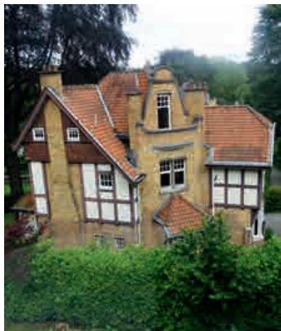
Fig. 44.- Genvall-les-Eaux, Villa Numéro Quinze, façade occidentale. © Lise De Ganck, 2016.
