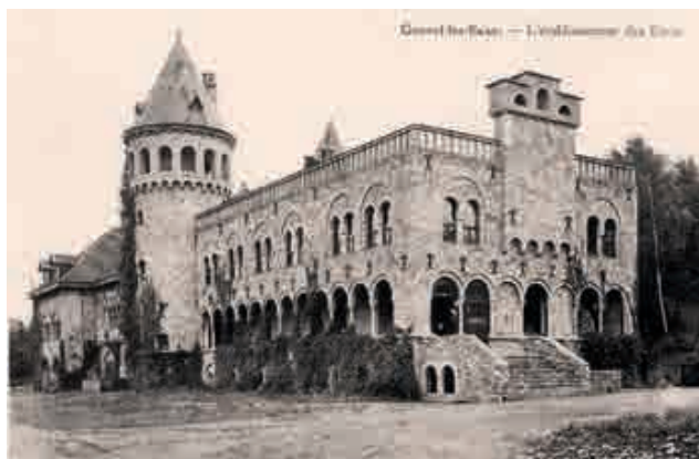
Fig. 11.- Genval-les-Eaux, Établissement des Eaux. Carte postale ancienne. Collection Philippe Godin. D'après Rétro Rixensart (URL : https://www.retrorixensart.com [dernière consultation le 09/10/2018]).
