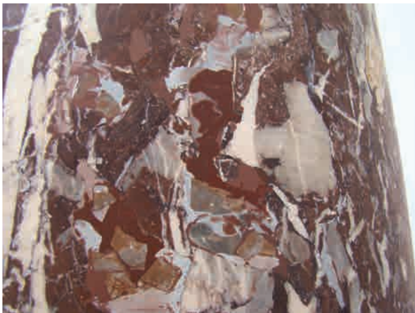
Fig. 19.- Détail d'une colonne en cours de traitement, dont les plages de mortiers de ragréage ont été remplacées par des colmatages en résine colorée chargée de morceaux de marbre de teinte approchant l'originale ; l'aspect naturellement chamarré de la matière et la variété originale de textures estompent la visibilité de ces interventions.
