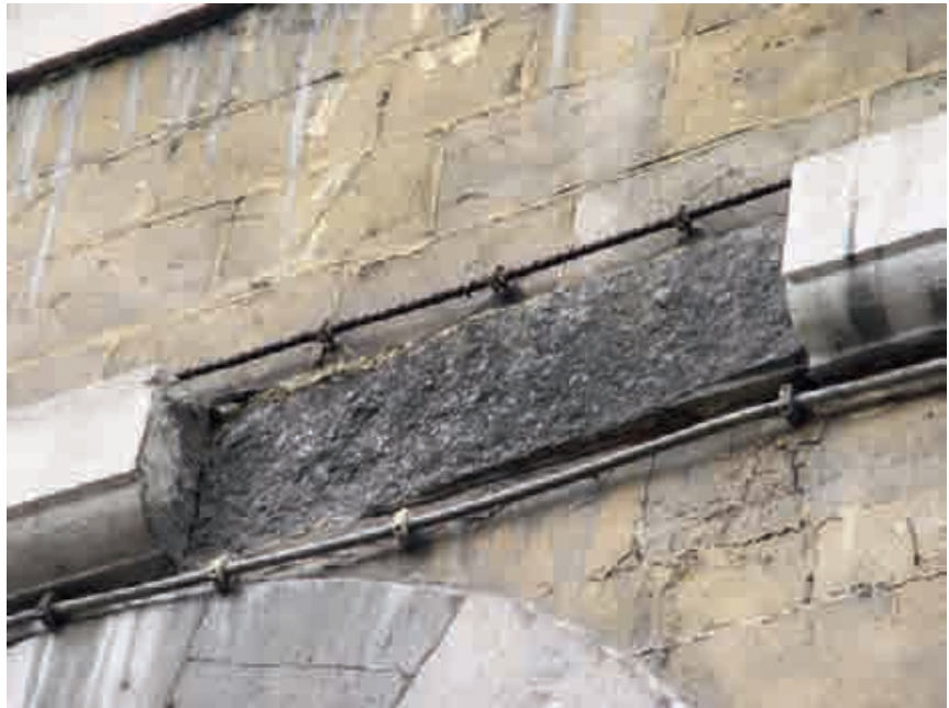
Fig. 11.- Un élément de bandeau mouluré, posé en délit, s'est rompu selon une « terrasse » (ou joint stylolithique), laissant une surface noirâtre irrégulière ; les tuffeaux présentent un aspect déplorable, chancreux ou pulvérulent, avec des joints différents, souvent plus résistants que les pierres voisines.
