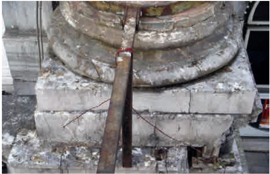
Fig. 8.- Détail d'une base de colonne avant intervention ; le marbre noir est fracturé en tous sens sous les restes de dorure ; on notera les réparations de fortune avec cales de bois et les éléments métalliques très présents.
