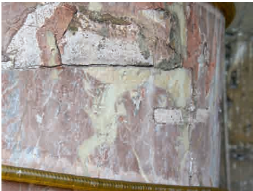
Fig. 12.- Détail du marbre rouge des colonnes, terni et sali, grossièrement ragréé avec des mortiers inadéquats, masquant (à droite) une agrafe destinée à affermir un greffon ; on notera en bas la trace laissée par la guirlande en plastique. © Francis Tourneur, avril 2006.
