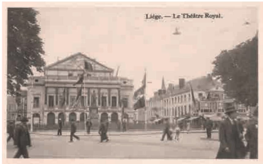
Fig. 5.- Le chantier d'installation du fronton définitif est en cours sur cette carte postale (envoyée en 1934), il est difficile de préciser si les façades sont décapées. Collections a.s.b.l. « Pierres et Marbres de Wallonie ».
