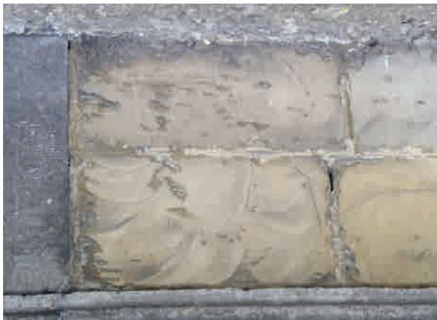
Fig. 14.- Détail de tuffeaux entre éléments saillants de pierres bleues, montrant les traces circulaires du meulage destiné à les décaper et à les ravalier. © Francis Tourneur, avril 2006.
