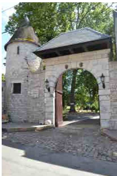
Fig. 32.- « Château Terwagne », portail d'entrée après transformations. © Julien de Leval.
