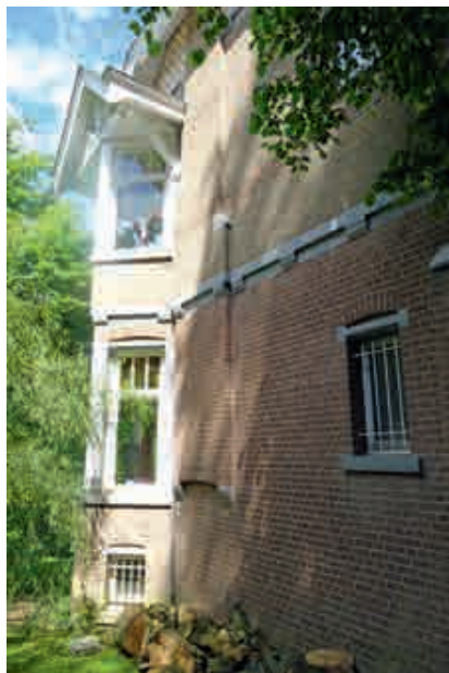
Fig. 41.- Genval-les-Eaux, Villa Les Violettes, façade occidentale. © Lise De Ganck, 2016.
