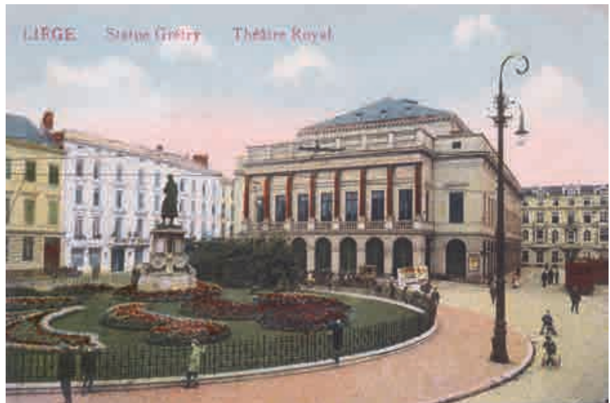
Fig. 18.- Cette carte postale (envoyée en 1919 mais sur un cliché d'avant-guerre) montre un état comparable à celui de la figure précédente mais la colorisation met en évidence les colonnes rouges et différencie légèrement le rez-de-chaussée (en pierres bleues) par une teinte grisâtre. Collections a.s.b.l. « Pierres et Marbres de Wallonie ».
