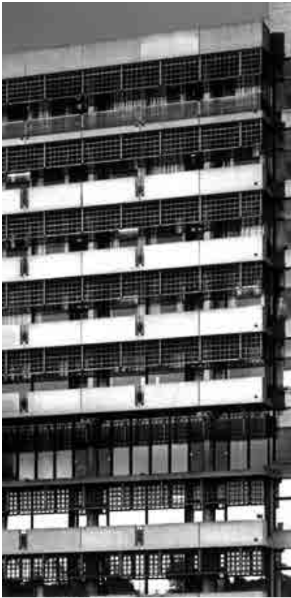
Fig. 48.- Liège, façade d'une tour d'hospitalisation du CHU. © François Hers.
