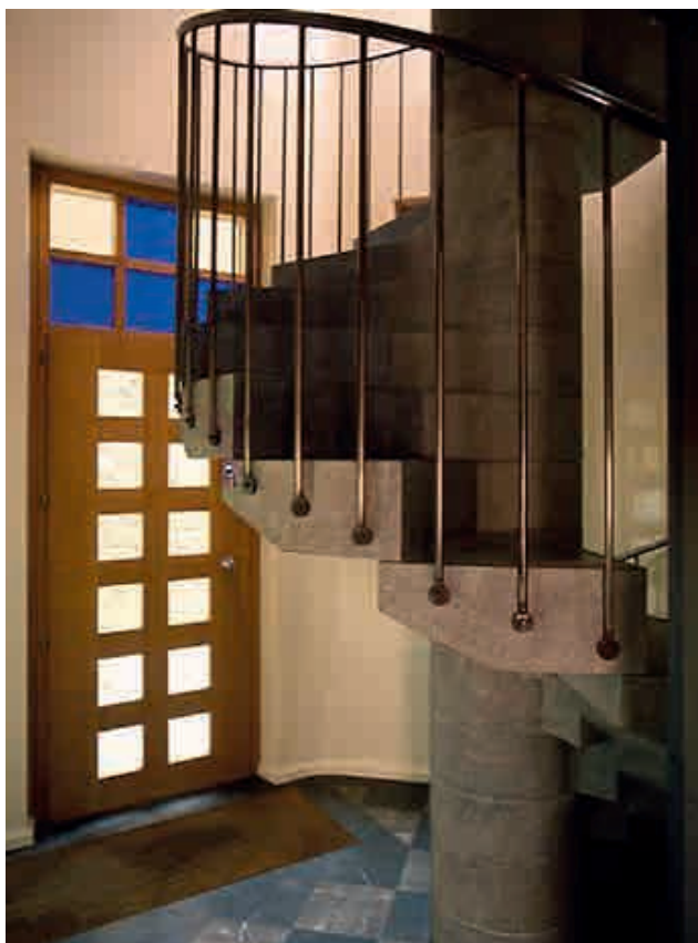
Fig. 70.- Liège, escalier hélicoïdal en pierre de la tour de l'hôtel Torrentius. © Charles Vandenhove.
