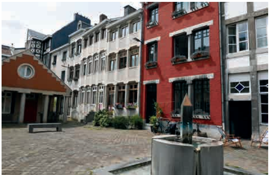
Fig. 72.- Liège, façades arrières des immeubles rue Hors-Château, place Tikal et fontaine. © Jacques Barlet.
