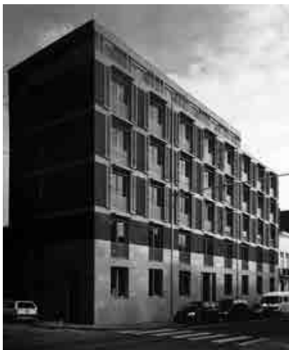
Fig. 48.- Bruxelles, façade de la Maison d'accueil du C.P.A.S.
