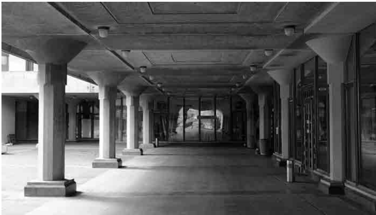
Fig. 40.- Liège, préau extérieur supporté par une série de colonnes type du système constructif principal du CHU. © Maxime Coq.
