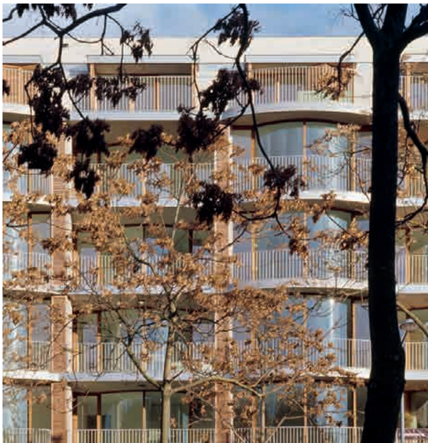
Fig. 17.- Maastricht, Maison Céramique, 33 logements. © Philippe Vander Maren.
