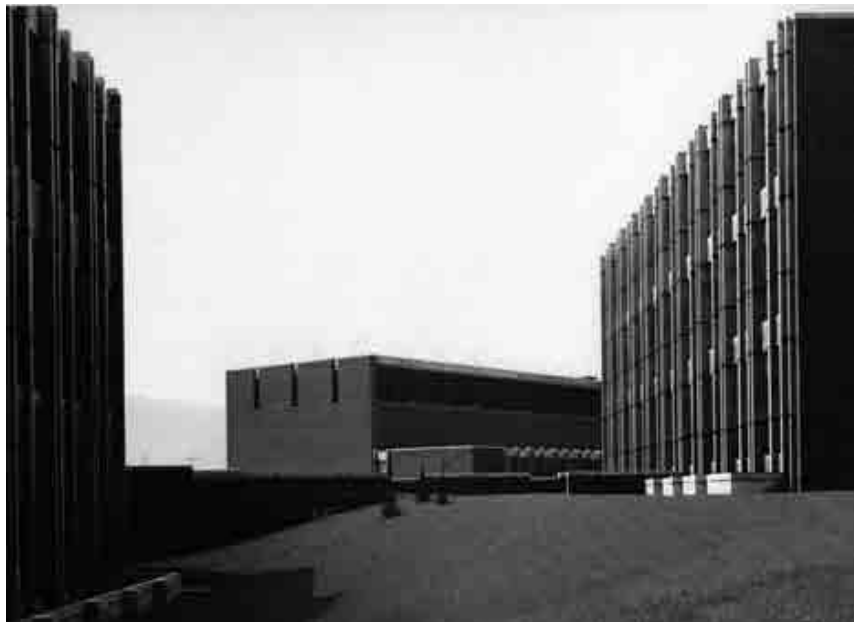
Fig. 24.- Liège, laboratoires, halle d'essais et atelier, bâtiment administratif de l'ISSeP (de gauche à droite). © Hubert Grooteclaes.
