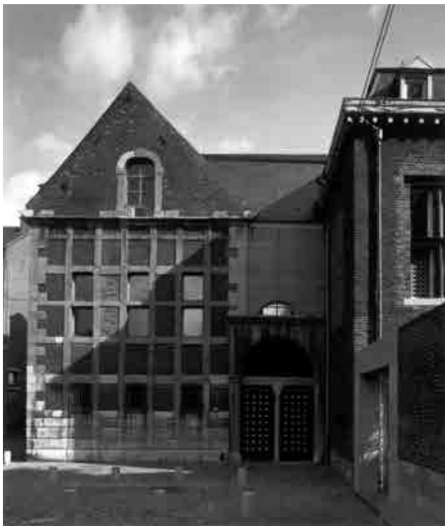
Fig. 80.- Liège, pignon classé et entrée contemporaine du Balloir, place Sainte-Barbe. © Kim Zwarts.
