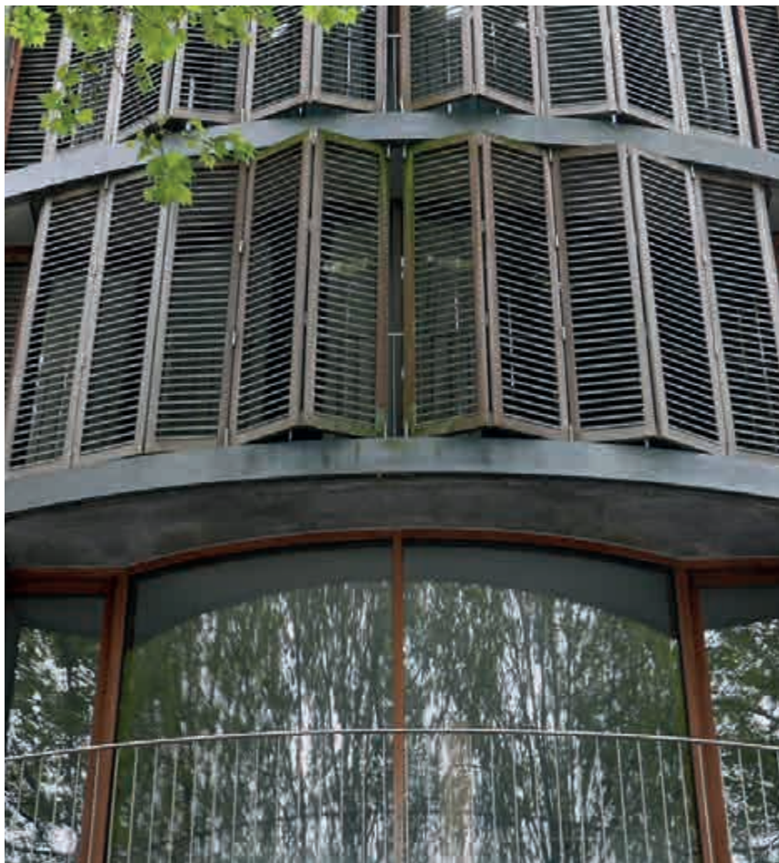
Fig. 64.- Liège, détail de la façade sur quai de la maison Esther © Jacques Barlet.
