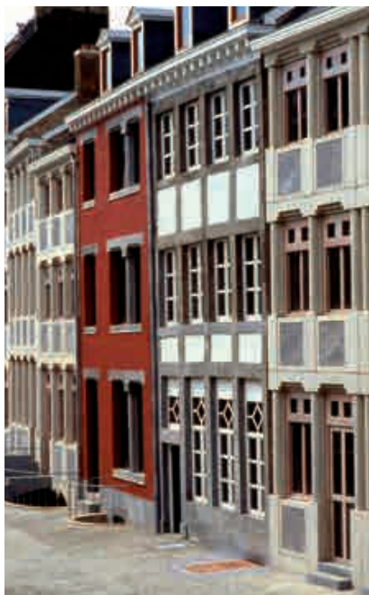
Fig. 75.- Liège, façades arrières des immeubles rue Hors-Château. © Charles Vandenhove.
