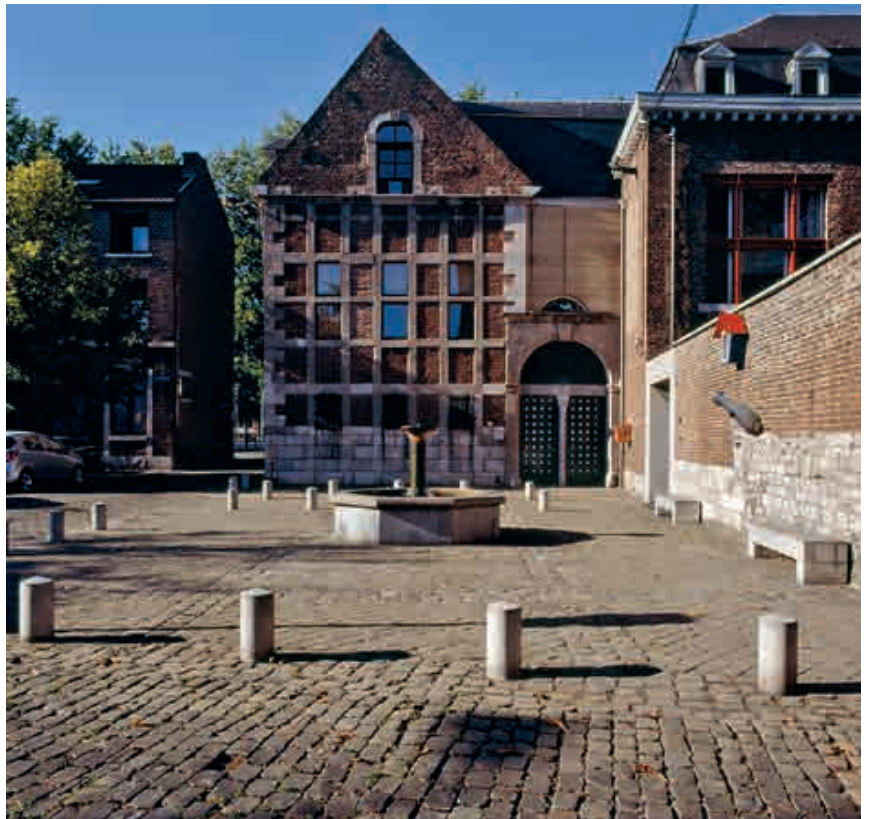
Fig. 31.- Liège, entrée du Balloir : fontaine dessinée par Charles Vandenhove. © Philippe Vander Maren.
