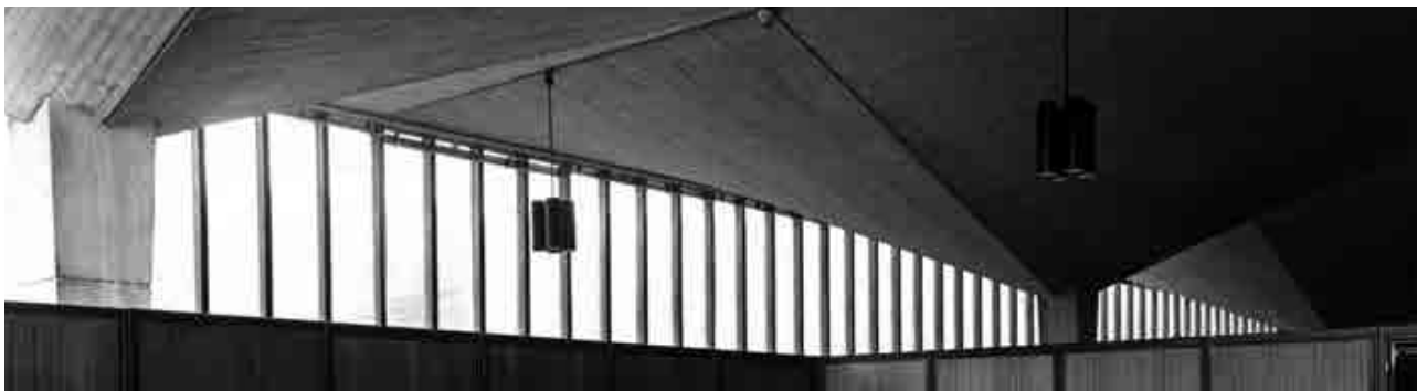
Fig. 20.- Liège, structure portante de la bibliothèque et du magasin à livres. © Hubert Grooteclaes.
