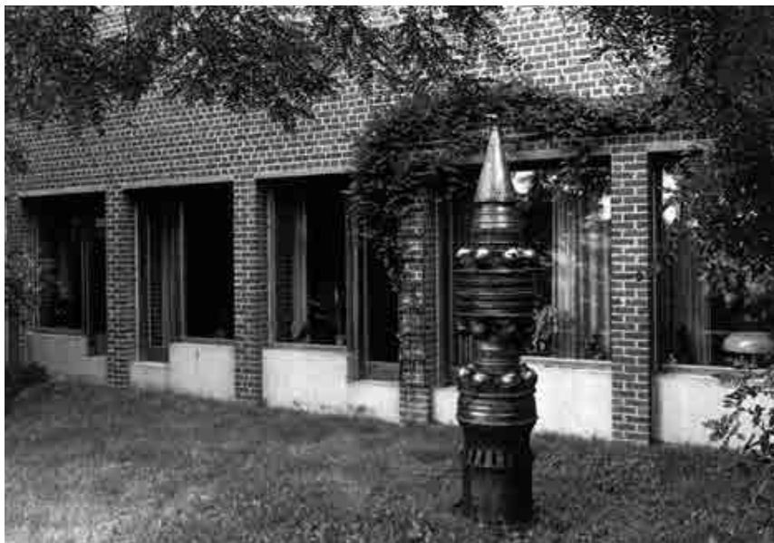
Fig. 52.- Liège, façade sur jardin de l'habitation personnelle de Charles Vandenhove. © François Hers.
