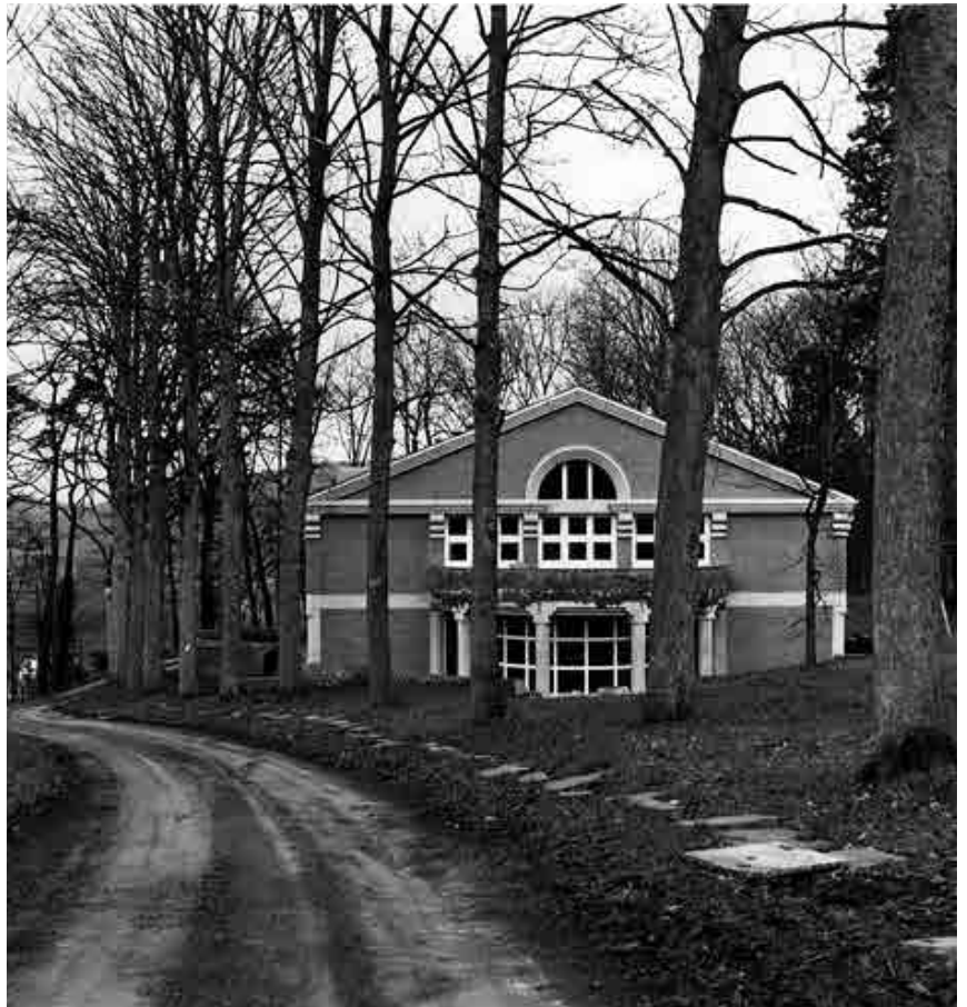
Fig. 5.- Esneux, centre d'accueil de la Maison blanche.
