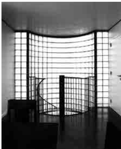
Fig. 65.- Liège, escalier et paroi de briques de verre à l'arrière de la maison Esther. © Philippe Vander Maren.
