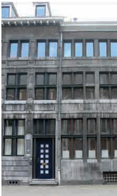
Fig. 74.- Liège, façades classées rue Hors-Château avec menuiseries à croisées en bronze. © Jacques Barlet.
