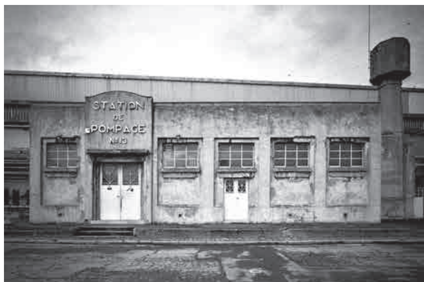
Fig. 20.- Station de pompage Sclessin n° 13, 1935 (première période constructive).
