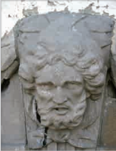
Fig. 3.- Clé de la deuxième fenêtre haute à partir du nord, en façade occidentale. Calcaire de Meuse, caractérisé par des colonies de coraux ( Tabulés ), dont la présence perturbe la qualité de la sculpture.
