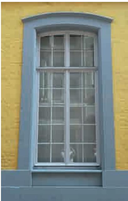
Fig. 86.- Idem, état en 2020 après restauration. © Francis Tourneur.
