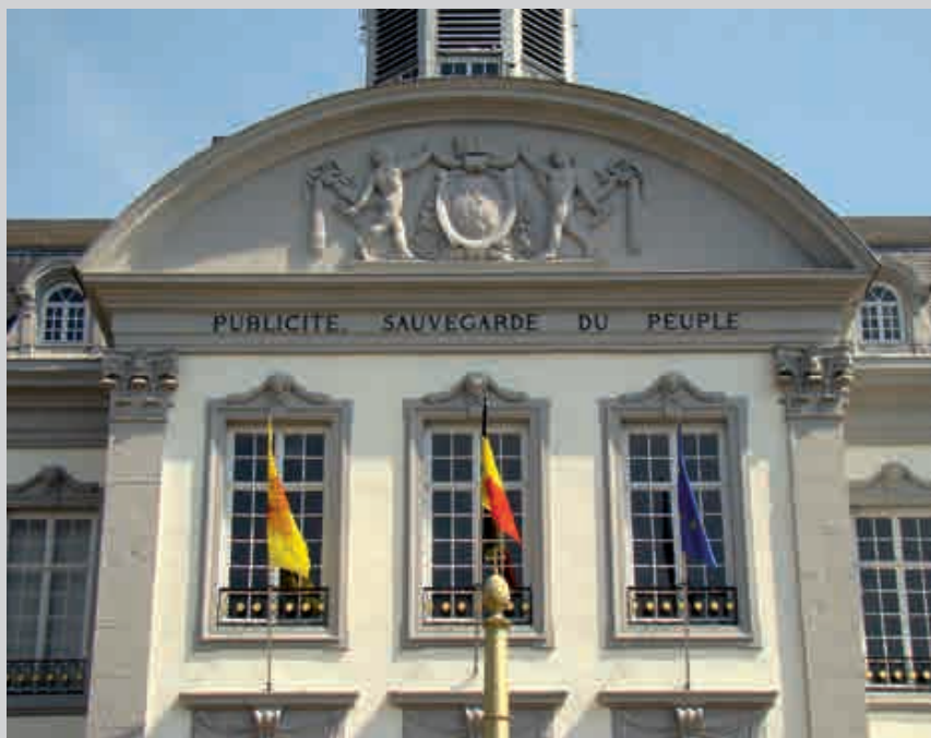
Fig. 11.- Idem, frontispice de la façade avant, état en 2013 après restauration. © Francis Tourneur.
