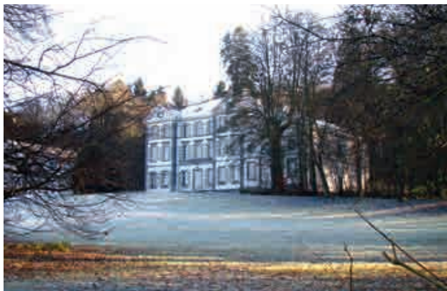
Fig. 81.- Idem, état en 2013 après restauration. © Francis Tourneur.
