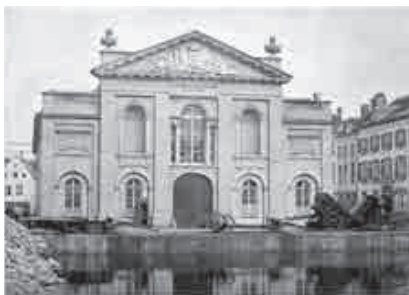
Fig. 55.- Bruxelles, ancien entrepôt, état vers 1863.
