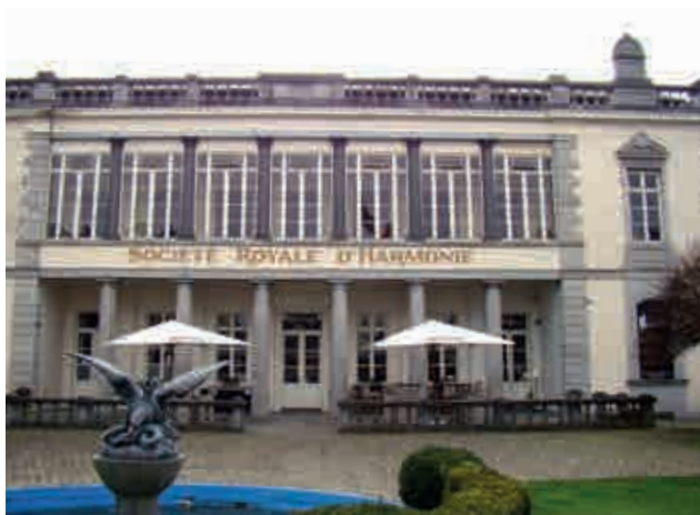
Fig. 34.- Idem, état en 2019 après restauration. © Francis Tourneur.
