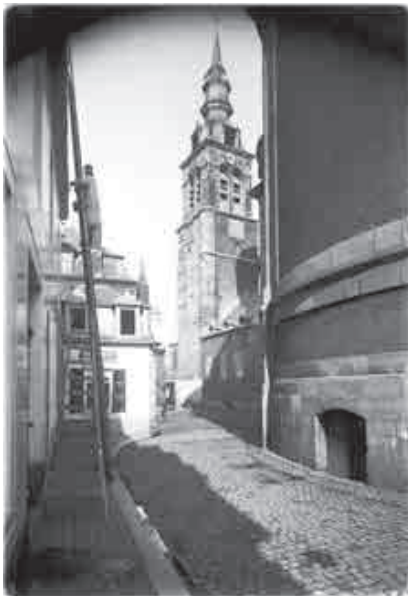
Fig. 74.- Namur, travaux à côté de la cathédrale, en 1890. © IRPA-KIK, Bruxelles.
