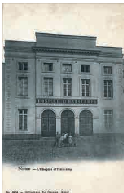
Fig. 64.- Namur, hospice d'Harscamp, façade, état au début du XX e siècle. Carte postale ancienne. Collection P.M.W.
