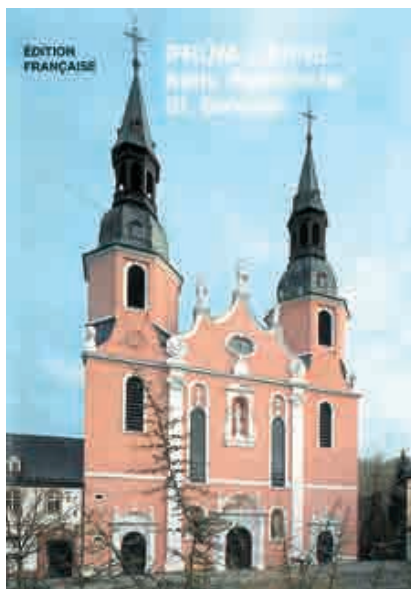
Fig. 66.- Prüm, basilique Saint-Sauveur, état à la fin du XX e siècle. D'après FAAS Franz Josef, 1998, couverture.
