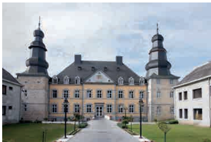
Fig. 79.- Idem, après restauration et décapages partiels. Photo Guy Focant © SPW-AWaP.
