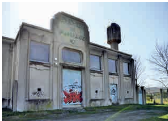
Fig. 8.- Façade nord de la S1. © Eduarda Lopes.
