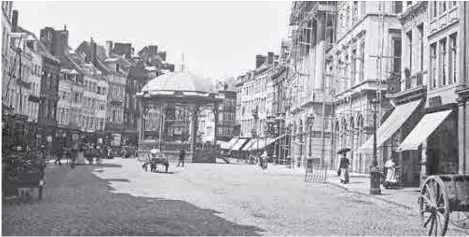
Fig. 59.- Idem, travaux à la fin du XIX e siècle.
