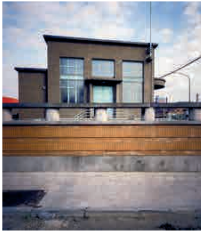
Fig. 21.- Station de pompage Sclessin n° 16, 1950 (deuxième période constructive). © OliGraph.com.
