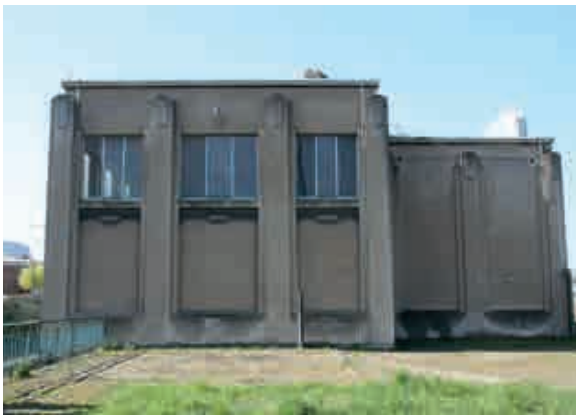
Fig. 12.- Façade est de la S1. © Eduarda Lopes.
