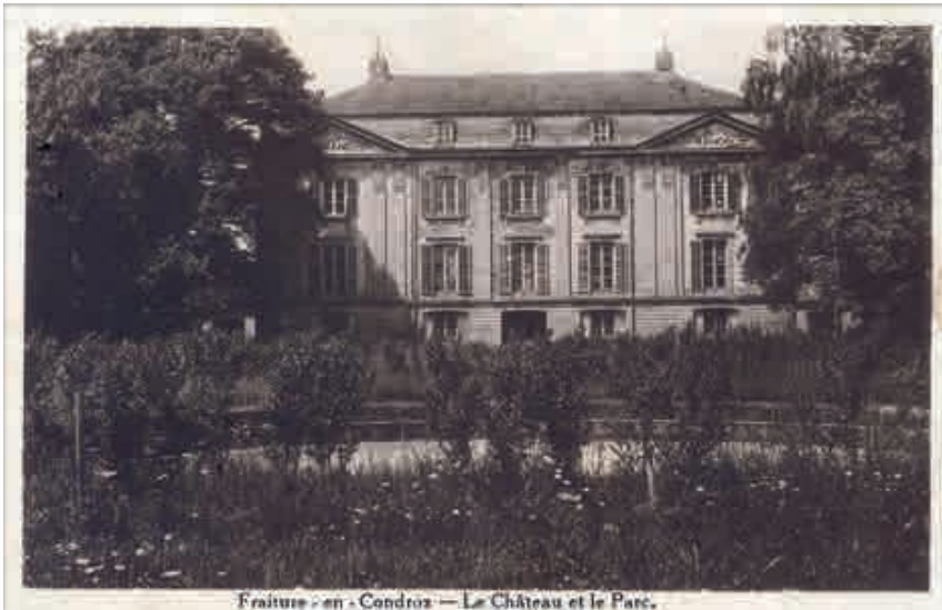
Fig. 19.- Fraiture, château, état au milieu du XX e siècle.
