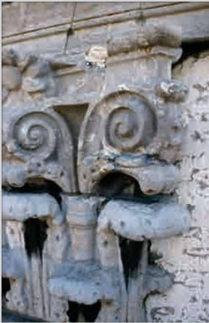
Fig. 1.- Chapiteau en façade orientale, angle nord du frontispice. Calcaire de Vesdre, de médiocre qualité et d'aspect varié, localement riche en fossiles (les grandes coquilles sont caractéristiques de l'étage stratigraphique givétien). © Francis Tourneur (2001).
