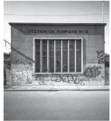
Fig. 22.- Station de pompage Angleur n° 12, 1966 (troisième période constructive). © OliGraph.com.
