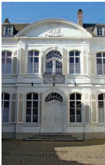
Fig. 41.- Idem, état en 2012 après restauration. © Francis Tourneur.
