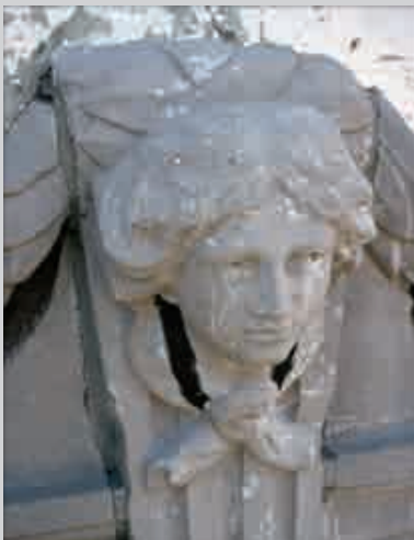
Fig. 4.- Clé de fenêtre haute du frontispice, en façade occidentale. Calcaire de Meuse, constellé de nombreux fossiles (coralliens et coquilliers), qui troublent la perception de cette délicate physionomie.
