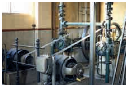
Fig. 28.- Machines à vide de la S1. © Eduarda Lopes.
