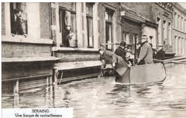
Fig. 6. - Rez-de-chaussée sous eau à Seraing, en 1925-1926. Carte postale ancienne. Collection personnelle de l'auteur.
