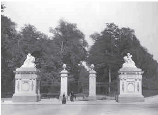
Fig. 51.- Bruxelles, aubettes de l'angle sud-est du Parc royal, état au début du XX e siècle. © IRPA-KIK, Bruxelles.
