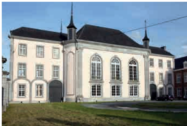
Fig. 11.- Idem, après restauration et badigeon rose sur les briques. Photo Guy Focant © SPW-AWaP.
