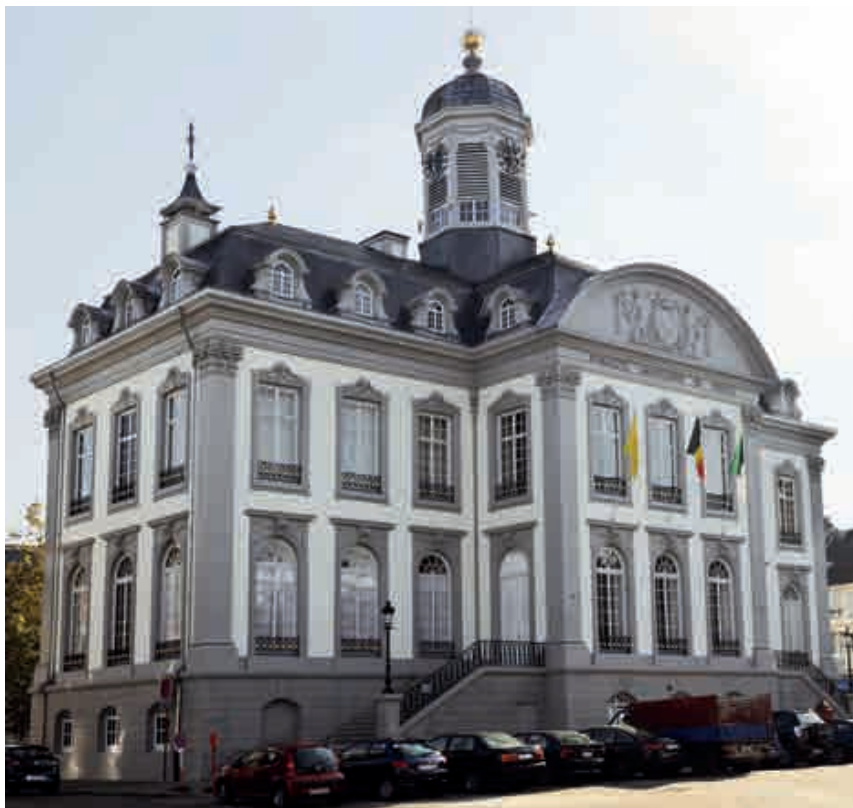
Fig. 1.- Verviers, hôtel de ville, état après restauration. Photo Guy Focant © SPW-AWaP.
