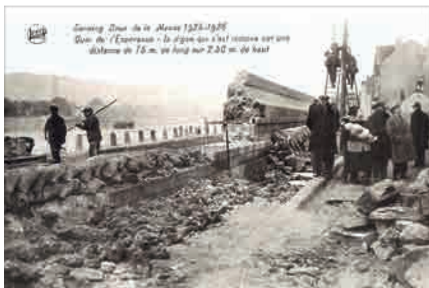
Fig. 5. - Rupture de la digue dans le bas de Seraing, en 1925-1926. Carte postale ancienne. Collection personnelle de l'auteur.
