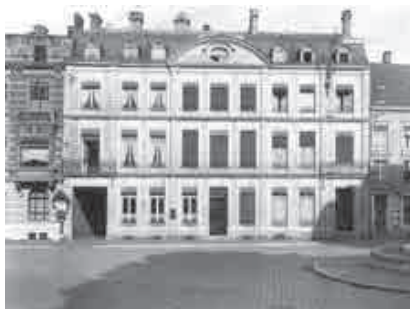
Fig. 26.- Verviers, hôtel Simonis (démoli), état en 1943. © IRPA-KIK, Bruxelles.
