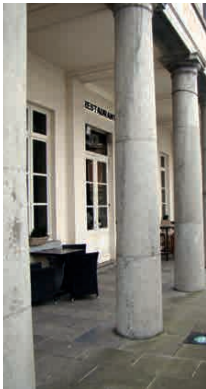
Fig. 35.- Idem, colonnes, état en 2019 après restauration. © Francis Tourneur.
