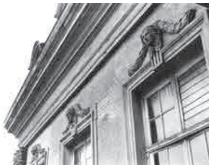
Fig. 4.- Idem, clés du troisième niveau, état en 1943.
