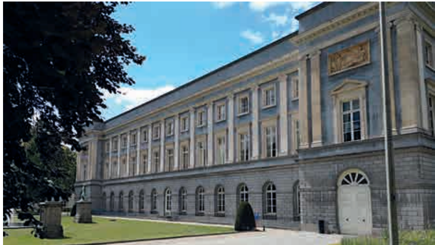
Fig. 44.- Idem, façade orientale, état en 2020. © Francis Tourneur.
