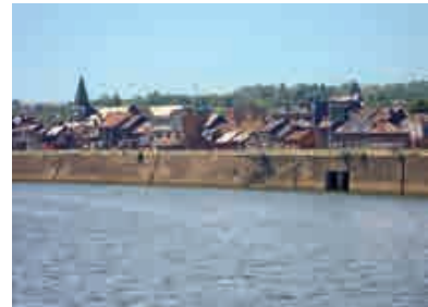
Fig. 12.- Vue actuelle de la digue de Jemeppe. © Romain Redeker.
