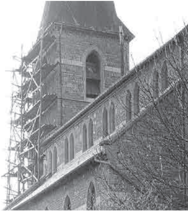
Fig. 34.- Restauration de la tour de l'église Notre-Dame à Fontenelle, vers 1892. © IRPA-KIK, Bruxelles.
