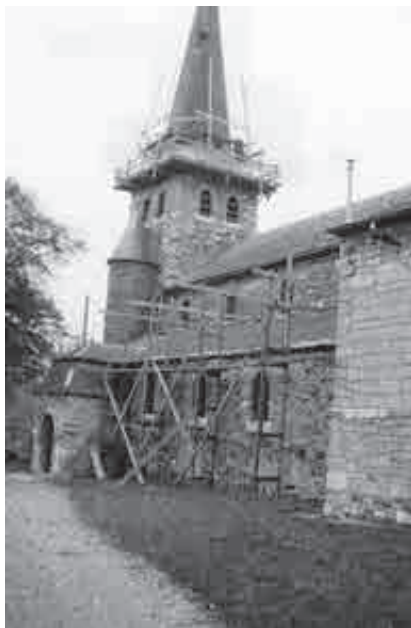
Fig. 27.- Restauration de l'église de Papeleux, 1969. © Province de Liège – Musée de la Vie wallonne, MVW 1101198-001-01.
