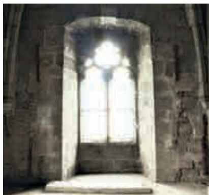
Fig. 17.- Vestiges de l'échafaudage érigé contre la façade de l'église Notre-Dame à Dinant entre 1863 et 1871 : des ancrs boulonnées dans les étages des tours. © Antoine Baudry.
