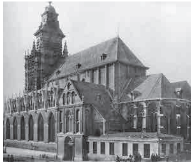
Fig. 40.- La restauration de l'église Notre-Dame-de-la-Chapelle à Bruxelles, vers 1865 ? © IRPA-KIK, Bruxelles.
