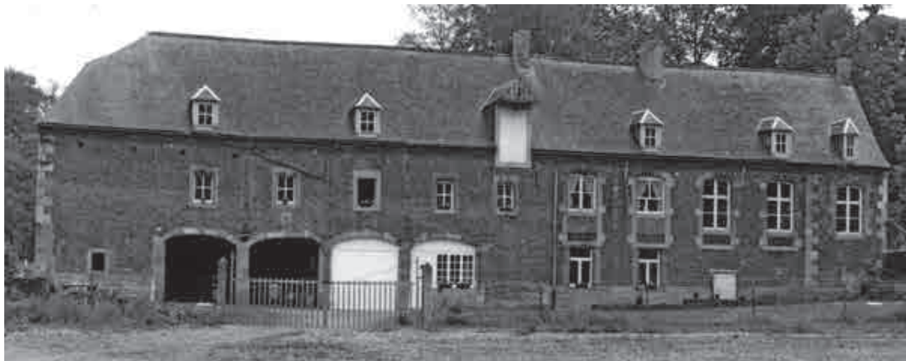
Fig. 33.- Idem, façade nord de l'aile sud-est de la basse-cour munie d'une fenêtre tire-sac, XIX e siècle (?). © SPW-AWaP - Inventaire du patrimoine immobilier culturel, 1987.
