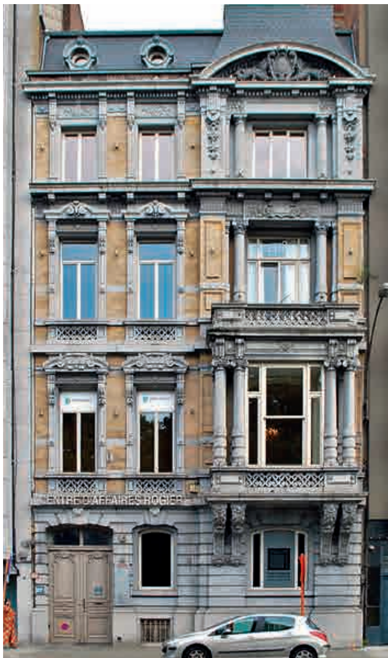
Fig. 37.- Avenue Rogier n°27 : façade avant. © Nicolas Sougnez, 2019.
