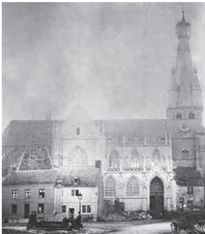
Fig. 8.- Restauration du transept nord de l'église Notre-Dame à Walcourt, dernier quart du XIX e siècle (vers 1889 ?). © IRPA-KIK, Bruxelles.
