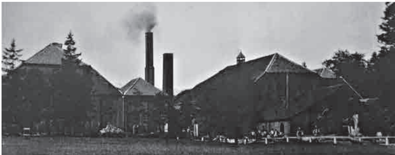
Fig. 40.- Ancienne abbaye de Moulins, Usines à cuivre de Moulins, entrée nord de l'usine primitive avant la construction des bureaux et de la conciergerie, la fonderie ne dispose pas encore d'un clocheton, c. 1900. Photographie ancienne. Collection privée.
