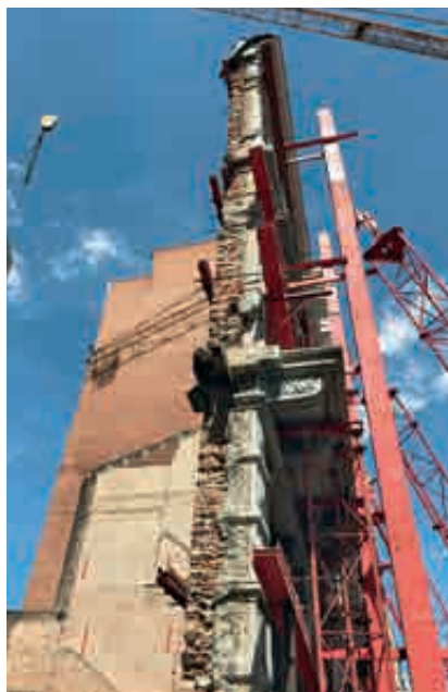
Fig. 59-60.- Boulevard Frère-Orban n° 45, 46 et 47 : chantier de démolition partielle. © Diade, 2018. © Imorban, 2018.
