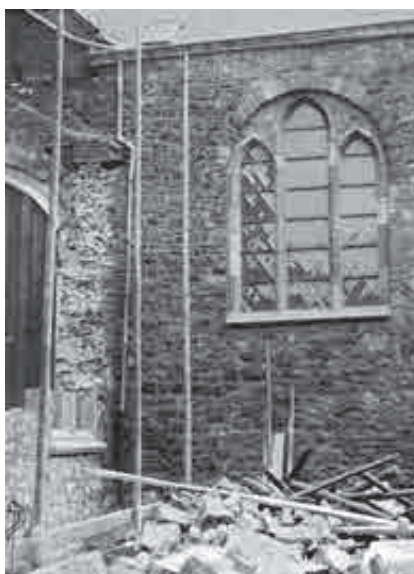
Fig. 31.- Vestiges de l'échafaudage ayant servi à démolir le mur-gouttereau du collatéral sud de la nef de l'église Saint-Christophe à Liège, vers 1875-1876. © Liège, Centre d'Archives et de Documentation de la C.R.M.S.F., fonds de la C.R.M.S.F., dossier « Liège 1.18 ».
