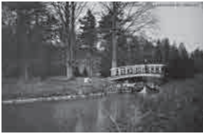
Fig. 15.- Idem, passerelle du parc du château, XIX e siècle.
