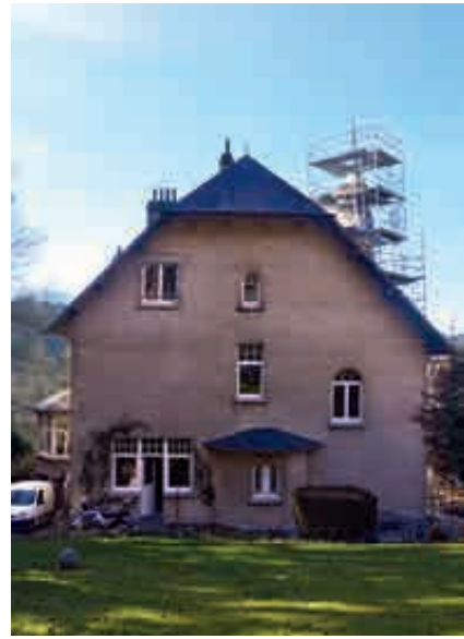
Fig. 12.- Idem : façade arrière. © Mathilde Badoux, 2019.
