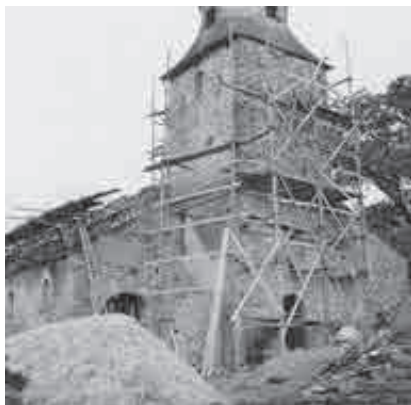
Fig. 30.- Restauration de l'église Saint-Vincent à Cherain, vers 1954. © IRPA-KIK, Bruxelles.
