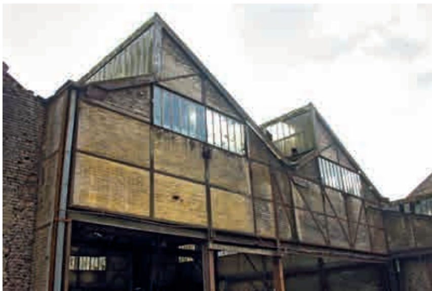
Fig. 47.- Ancienne abbaye de Moulins, Usines à cuivre de Moulins, façade occidentale du laminoir à laiton avec toiture en sheds, c. 1893.
