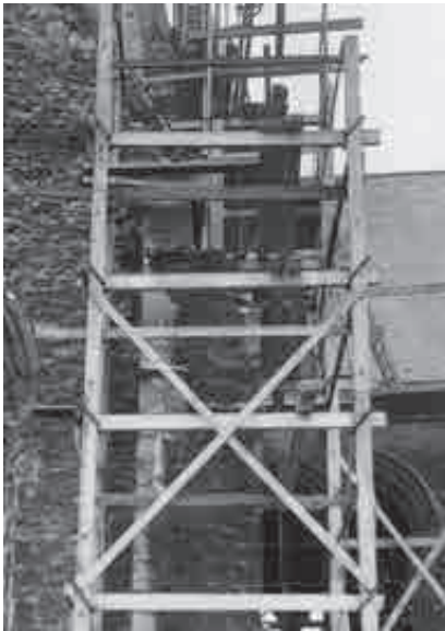
Fig. 33.- Restauration de l'église Sainte-Marie-Madeleine à Tournai durant l'entre-deux-guerres.
