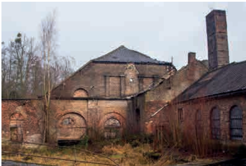
Fig. 43.- Idem, façade sud du laminoir avec décor serlien et châssis métalliques en combinaison d'ogives, 1831-1837. © Mathilde Macaux, 2021.
