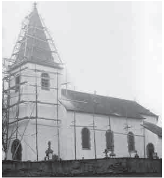
Fig. 35.- L'église Saint-Lambert à Beho, restauration du XX e siècle. © IRPA-KIK, Bruxelles.
