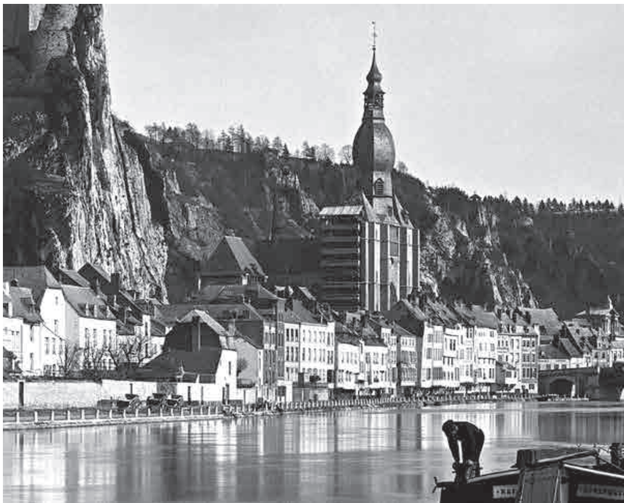
Fig. 20.- Restauration du flanc nord de la tour nord de l'église Notre-Dame à Dinant, dernière quinzaine du XIX e siècle. Photographie Ferdinand Massange de Louvrex. © Province de Liège – Musée de la Vie wallonne, MVW 1025836-2024.
