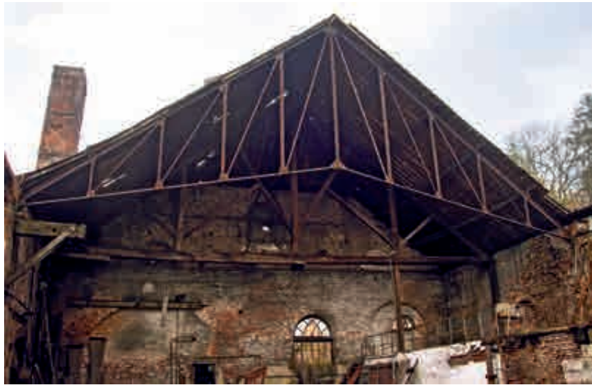
Fig. 42.- Idem, ferme métallique en treillis « à l'anglaise » du laminoir, 1831-1837. © Mathilde Macaux, 2021.
