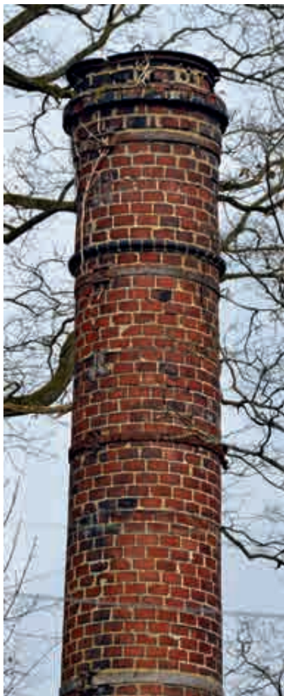
Fig. 51.- Idem, cheminée cylindrique en brique, c. 1922.
