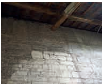
Fig. 23.- Idem, façade nord de l'aile septentrionale de la petite ferme, traces des encadrements en pierre des fenêtres hautes du chœur de l'église abbatiale, première moitié du XVIII e siècle. © Mathilde Macaux, 2019.
