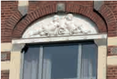
Fig. 30.- Villa Maurice à Yvoir : décor en stuc ornant l'imposte d'une baie. © Mathilde Badoux, 2017.
