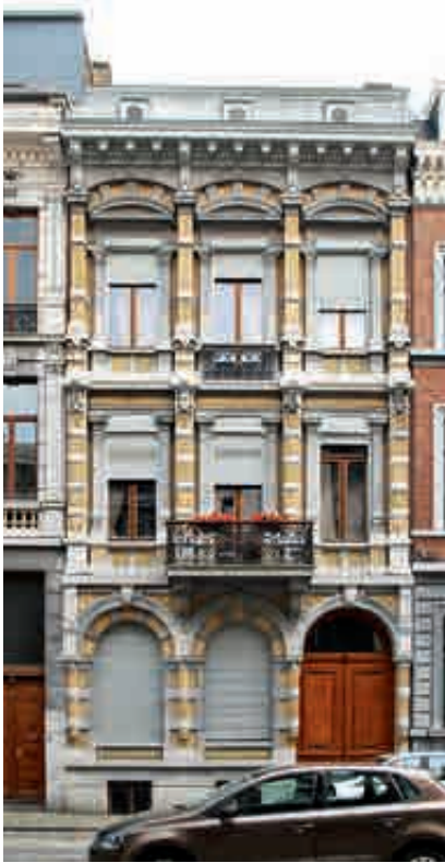
Fig. 19.- Rue Forgeur n°13 : façade avant. © Nicolas Sougnez, 2019.
