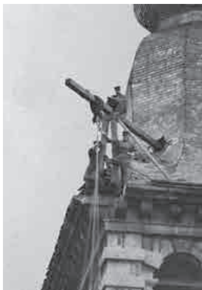
Fig. 23.- Système de levage installé dans l'angle nord-ouest de la tour de l'église Saint-Jean-Baptiste à Namur, probablement vers 1891.
