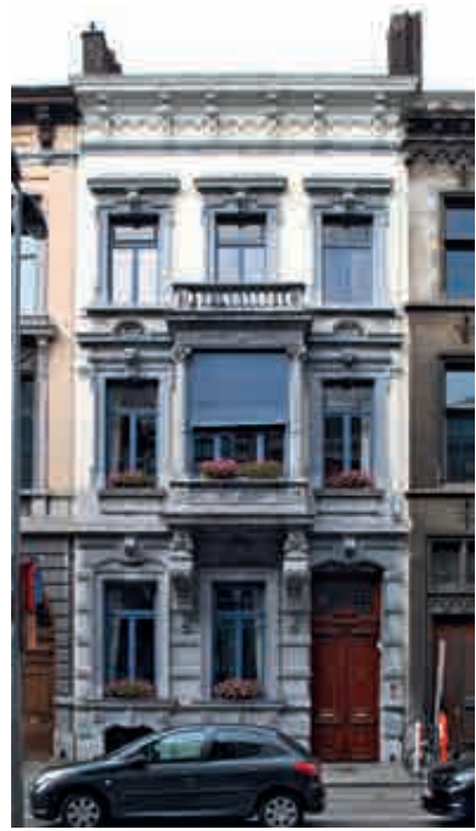
Fig. 25.- Rue Forgeur n°20: façade avant. © Nicolas Sougnez, 2019.
