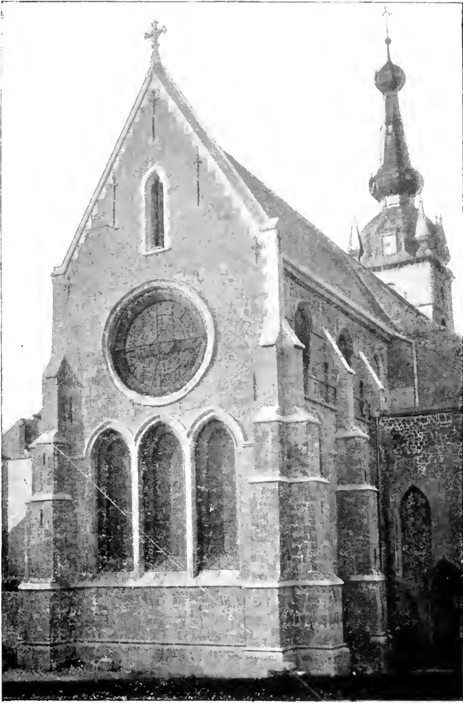
CHŒUR DE LA COLLÉGIALE DE CHIMAI RESTAURÉ.
