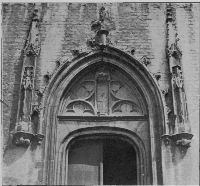
Fig. 1. — Saint-Gommaire, Lierre. Porte du transept méridional.
