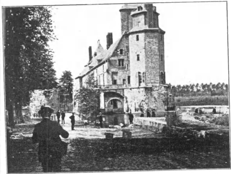
4bis. CHATEAU D'HAVRÉ. — Premier aspect des travaux de restauration.
