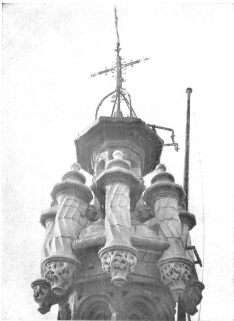
Fig. IV. — Zicht van het bovendee! der bekroning genomen na uitvoeren der herstellingswerken.
