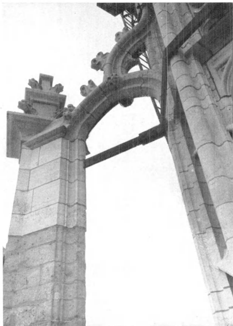
Fig. XIII. — Zicht van steenbogen en pijlers boven de 3 e gaanderij, genomen na de herstelling.
