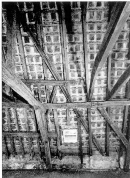
troffen (afb. 32). Het betreft hier een eenvoudige overkapping boven een vlakke houten zoldering. De kepen van de ribben, die deze zoldering droegen, zijn nog in de trek balken zichtbaar.
