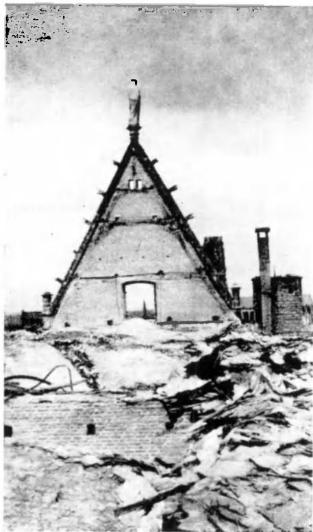
FIG. 102. Piment intérieur du pignon nord du transept. Photo de l'auteur, 24 avril 1944. A remarquer la trace d'une ferme, imprimée par l'incendie de la charpente.
