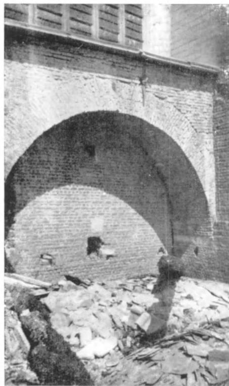
FIG. 125. Arc de soutien de la courrière extérieure du pan coupé sud du chevet.
