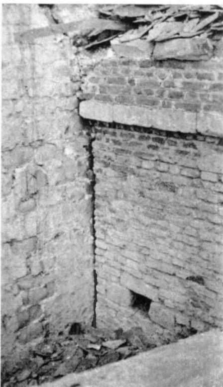
FIG. 16. Jonction du mur goutterot nord de la nef (en briques) avec le mur est de la tour (en pierre). Photo de l'auteur, 8 mai 1944.
