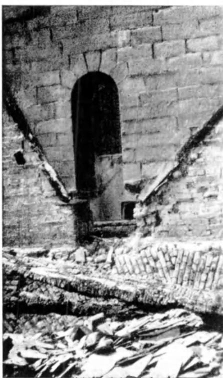
FIG. 103. Passage réservé dans les contreforts de la partie absidiale. A remarquer la différence des matériaux de part et d'autre des solins. Photo de l'auteur, 24 avril 1944.
