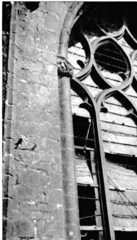
FIG. 118. Fenêtre du transept sud contigué à la nef. À remarquer le chapiteau et les profils différents de l'arc et du pied-droit qu'il prolonge, manquant ainsi deux campagnes de construction.
