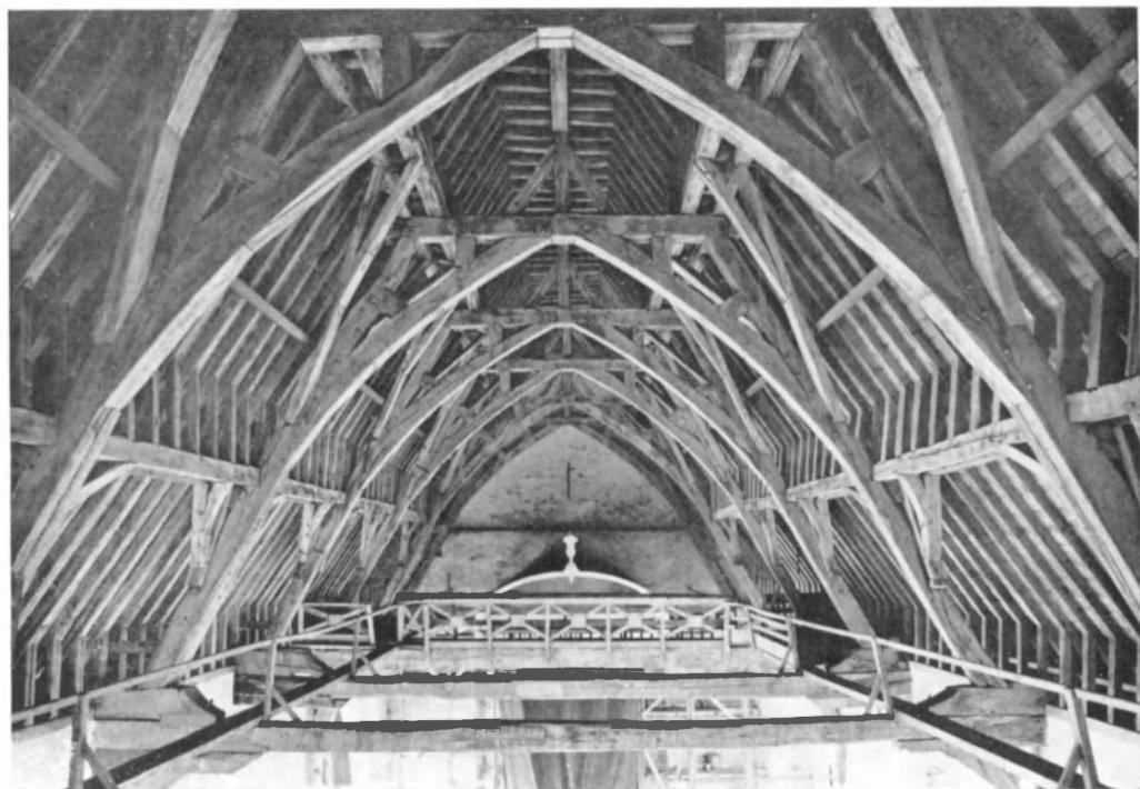
AFB. 88. — Brouwershaven, kap van het middenschip, oorspronkelijk geplaatst op een eenbeukig schip van ± 1325. Trekbalken aangebracht bij de herplaatsing in het begin der 16de eeuw.
