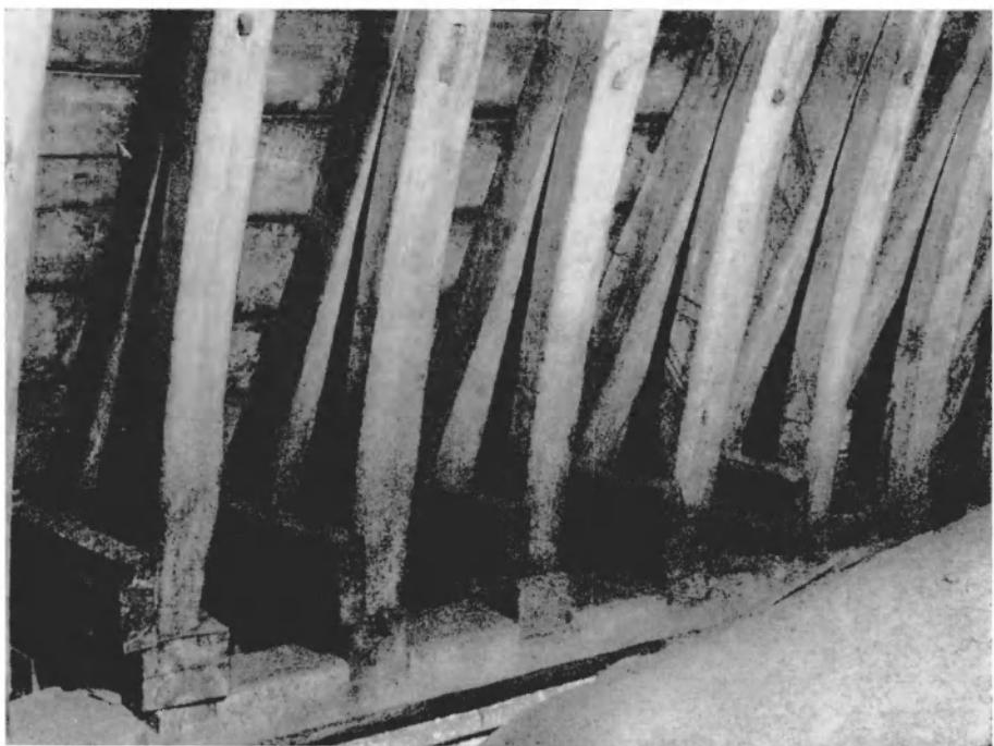
AFB. 34. — Brugge, St.-Jakobskerk, Kepers en standzonen rusten op blokken die ingesloten zijn op muurplaten. Telmerken.
