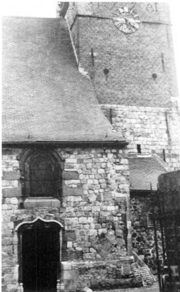
Fig. 2. QUEVY-LE-GRAND, église Saint-Pierre, tour et baies aménagées dans le collatéral nord, vers \pm 1600.
