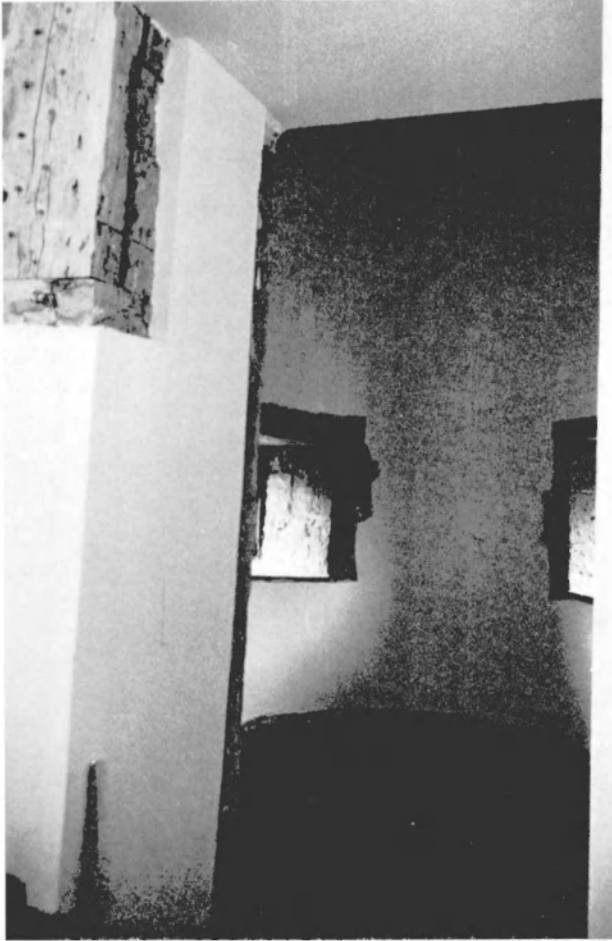
Fig. 9. Maison-forte d'Huissignies. Vue intérieure de la tour appliquée au pignon sud. Dans le coin gauche en haut, on voit la rainure d'un volet. Le colombage a été scié pour ménager l'accès à la tour. Auparavant, il y avait là une fenêtre.
