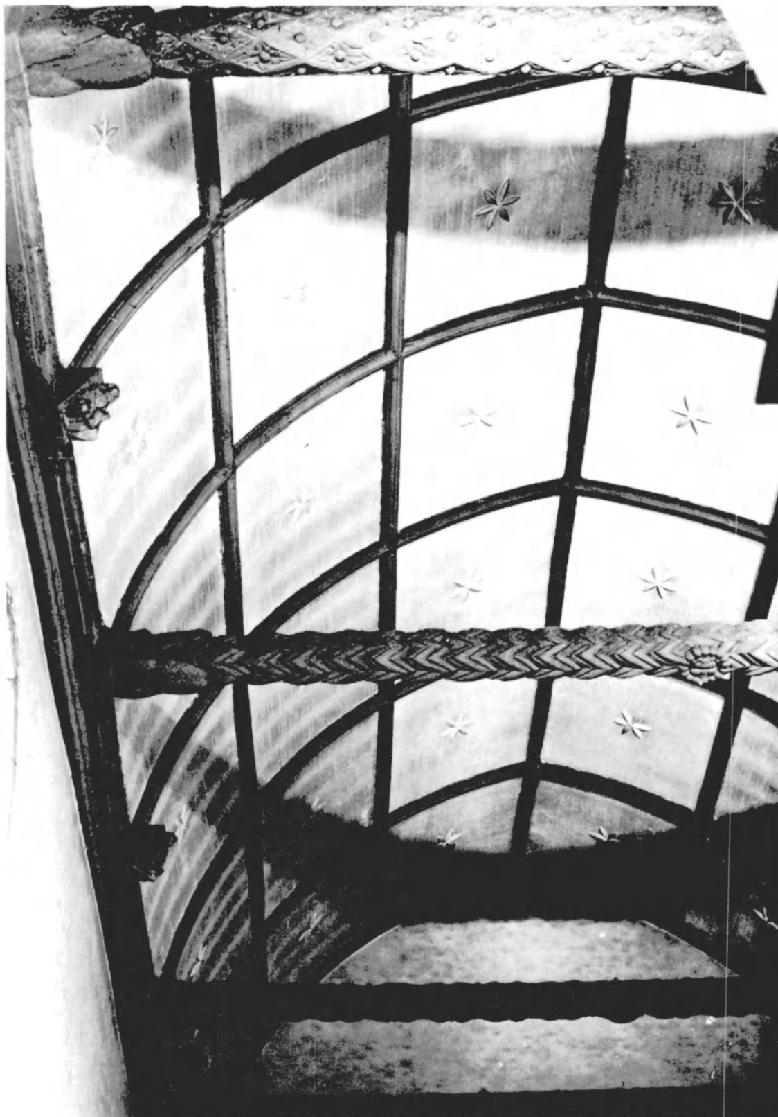
Fig. 2. COUSOLRE, église Saint-Martin, charpente de la nef.
