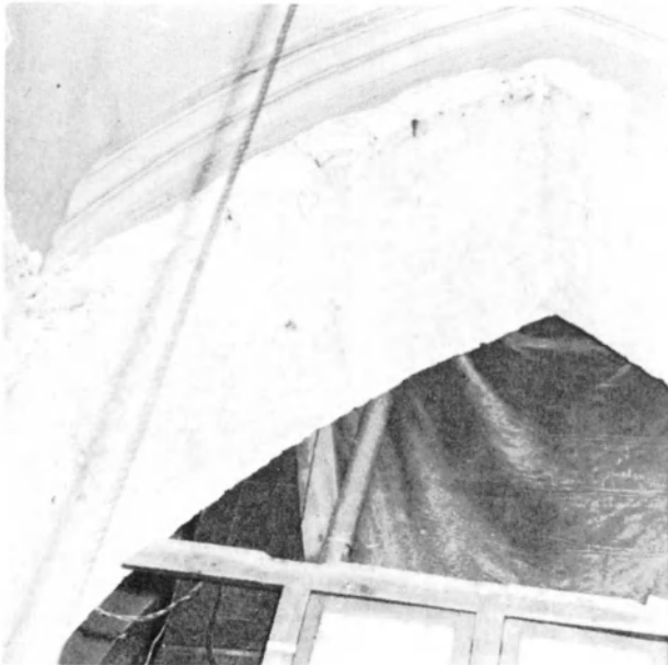
Fig. 2. BLAUGIES, église Saint-Aubin, mur de l'ancienne tour: formeret conservé au rez-de-chaussée, au-dessus de l'arcade tour-nef. (Photo Dr Watteyne.)
