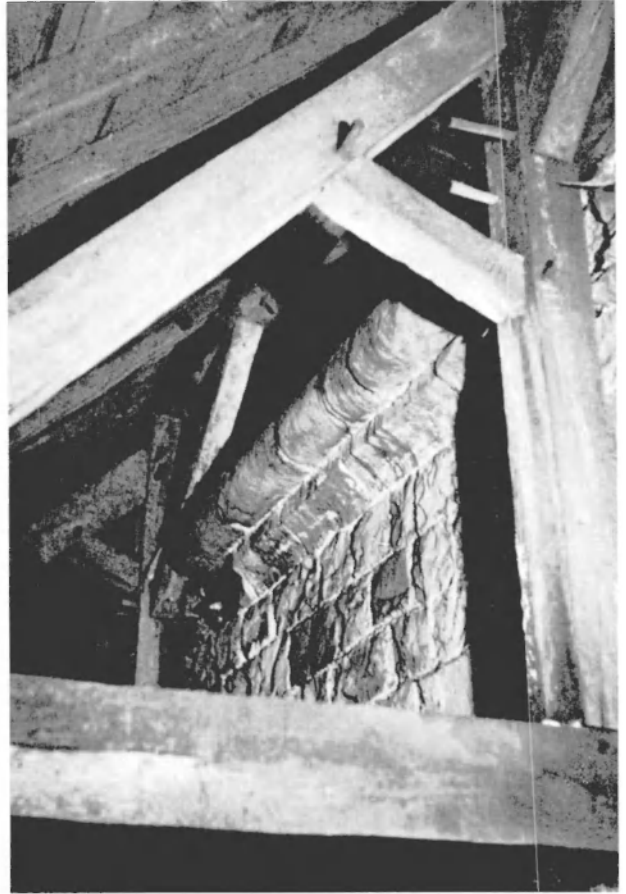
Fig. 11. BLAUGIES, église Saint-Aubin, goutterot méridional, maçonnerie appareillée et corniche. (Photo abbé P. Le-fèvre.)
