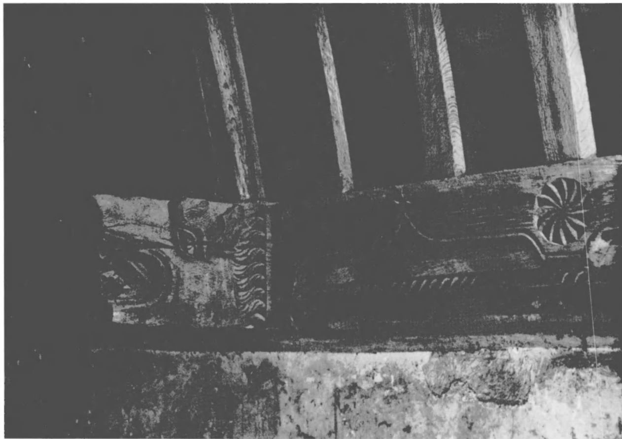
Fig. 14. BLAUGIES, église Saint-Aubin, engoulant et sablière de la voûte lambrissée. (Photo abbé P. Lefèbvre.)
