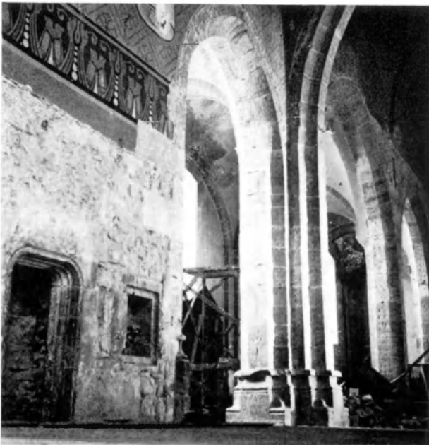
Fig. 7. BLAUGIES, église Saint-Aubin, mur oriental du chœur et supports de la nef en cours de décapage (1966). (Photo abbé P. Lefèbvre.)
