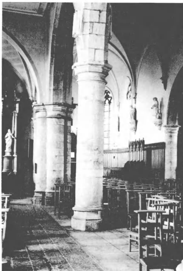
Fig. 4. SOLRE-SUR-SAMBRE, église Saint-Médard; vue du collatéral, pilier tréflé du transept et colonne de la nef avec départ d'un arc diaphragme.
