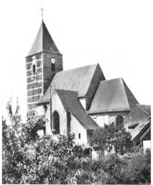
Fig. 8. COUSOLRE, église Saint-Martin, ensemble de la façade méridionale et une face reconstruite de la tour.
