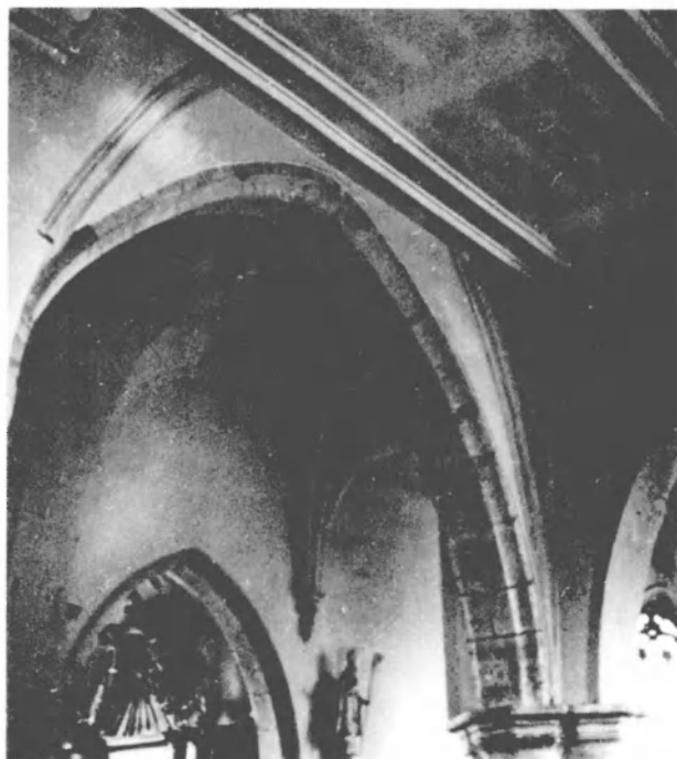
Fig. 5. SOLRE-SUR-SAMBRE, église Saint-Médard, formeret de la voûte d'une chapelle méridionale disparue.
