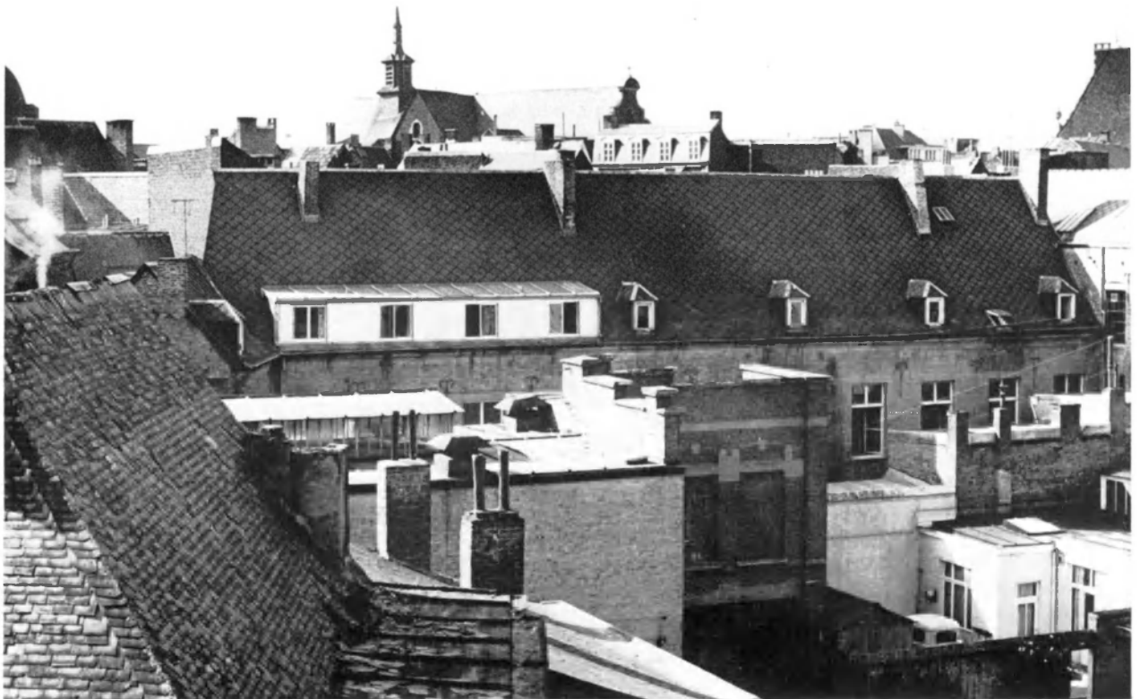
Fig. 18. Intérieur de l'îlot vu de l'hôtel d'Harscamp, vers l'aile de l'ancien couvent des Ursulines, rue E. Cuvelier, 45, dont le volume limite un espace encombré aujourd'hui de constructions hétéroclites. A l'arrière-plan, l'église Saint-Joseph, du XVII e s., rue de Fer.
