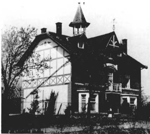
Fig. 1. Architecture « rustique » du début du siècle : faux colombages, toits surplombants, jeux de matériaux, complication.
