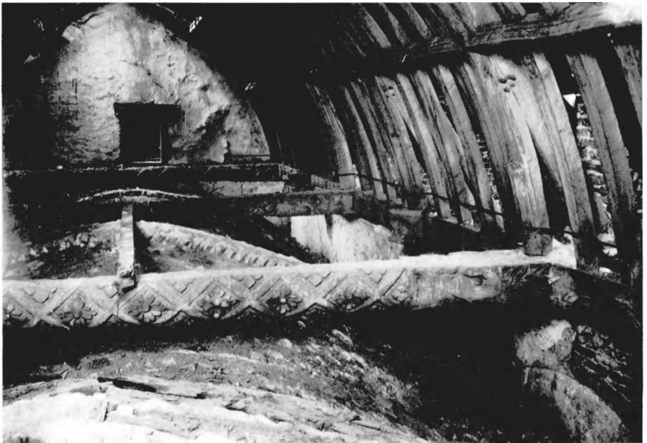
Fig. 9. BLAREGNIES, église Saint-Géry, voûte en berceau lambrissé. (Copyright A.C.L.)
