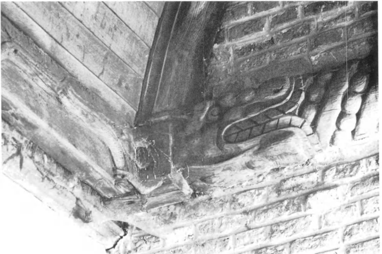
Fig. 4. BINCHE, chapelle Saint-André, entrant engoulé de la voûte en bardeaux du porche. (Photo S. Glotz.)
