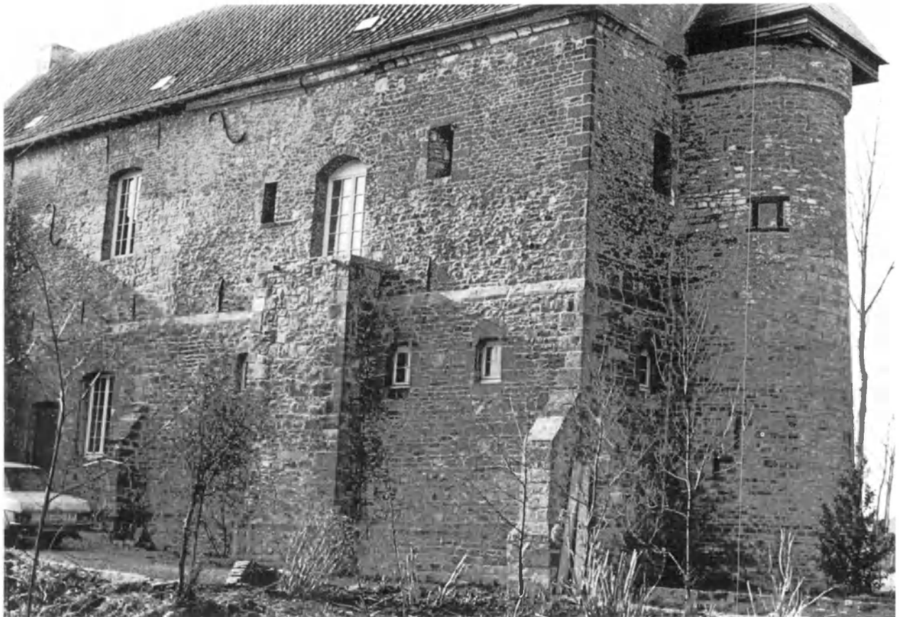
Fig. 1. Façade ouest de la maison-forte d'Huissignies. Le différence d'appareillage se remarque à partir du seuil de la fenêtre de l'étage. Les trois contreforts et l'interruption de la moulure au sommet des murs indiquent les dimensions de la façade originale.
