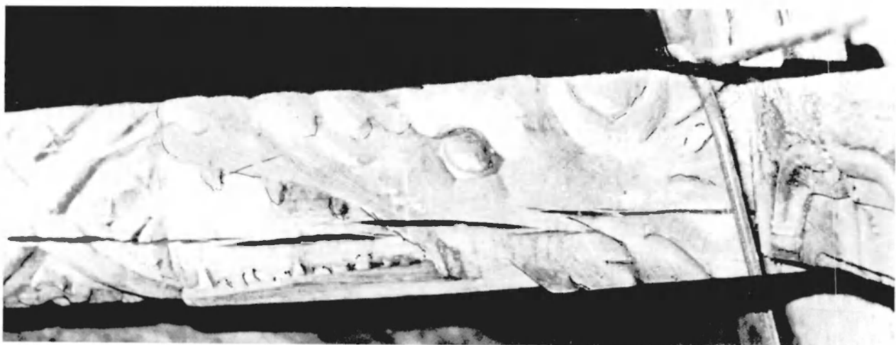
Fig. 11. BLAREGNIES, église Saint-Géry, engoulants des entrails.
