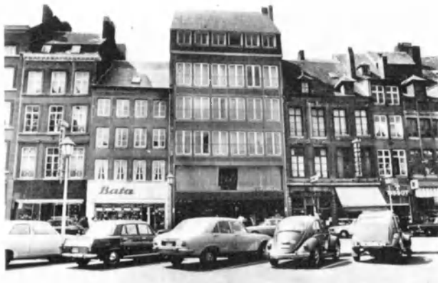
Fig. 20. Immeuble récent, rue de l'Ange. Désaccord dans les vides et les pleins de la façade et surtout élévation écrasante pour le voisinage, malgré le subterfuge de la fausse toiture à la Mansard.
