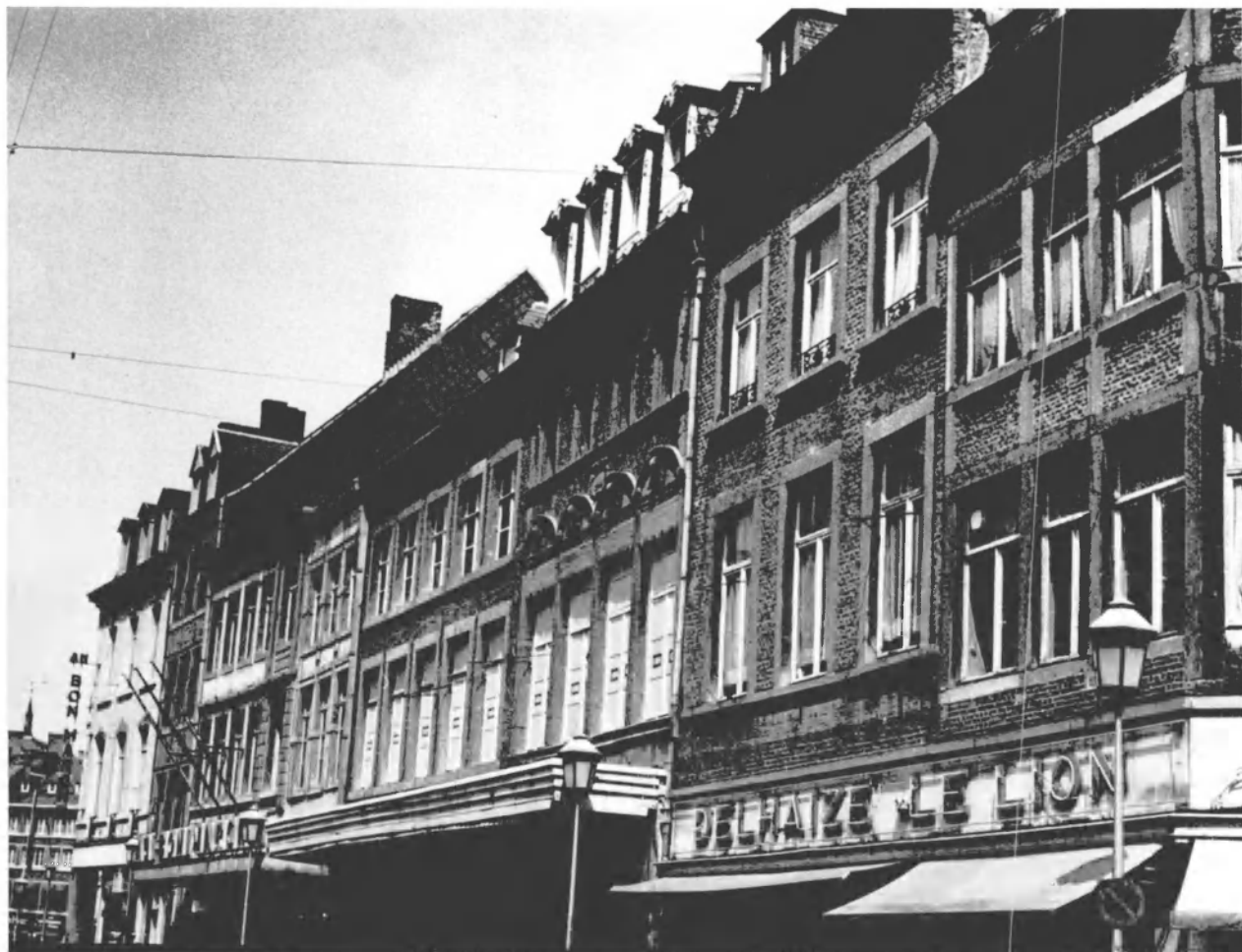
Fig. 17. Ensemble d'immeubles rue de l'Ange, 10-30. A remarquer le rythme serré des façades et des percements ainsi que la rupture introduite par les rez-de-chaussée et leurs auvents.
