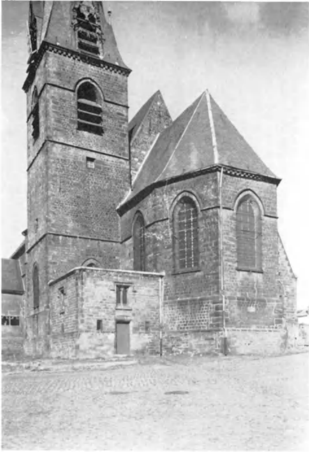
Fig. 16. BAUDOUR, église Saint-Géry, vue de la tour et du chevet. (Copyright A.C.L.)
