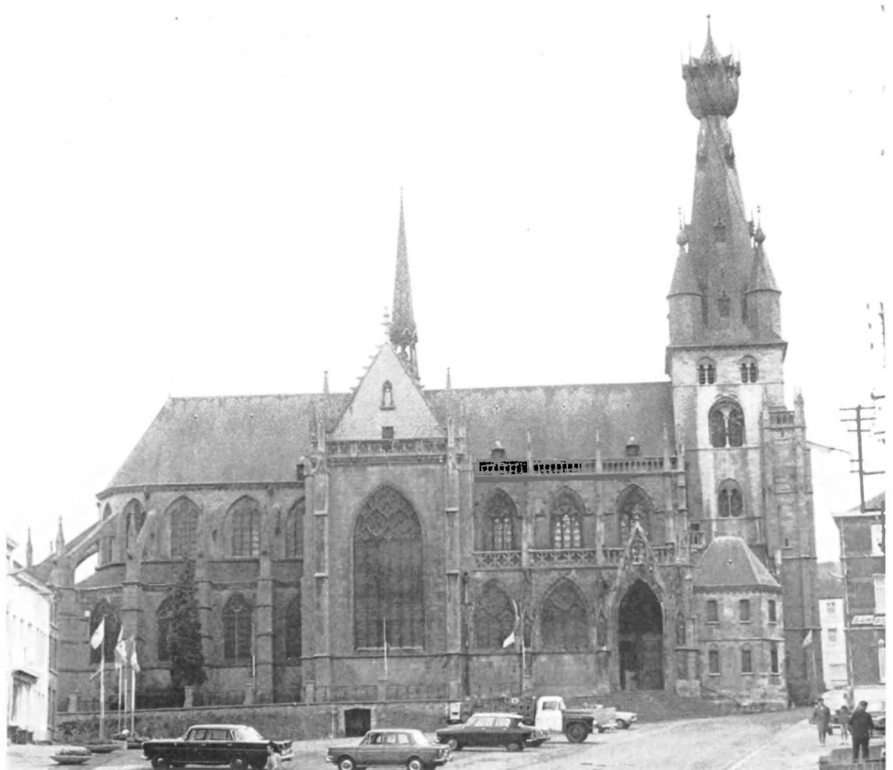
Fig. 4. Vue d'ensemble de la basilique.
