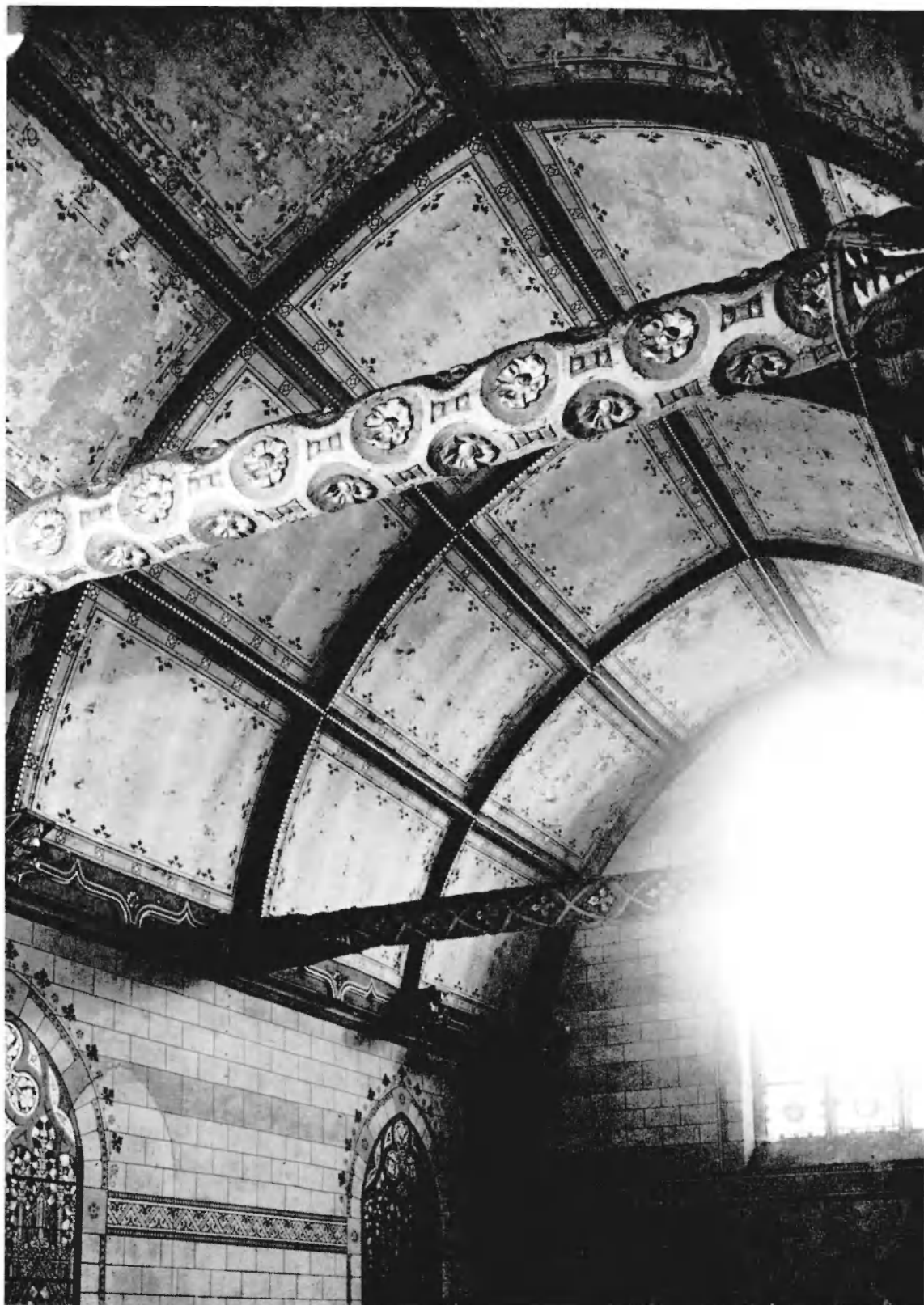
Fig. 4. GIVRY, église Saint-Martin, charpente lambrissée de la nef et traces d'une fenêtre haute. (Copy. A.C.L.)
