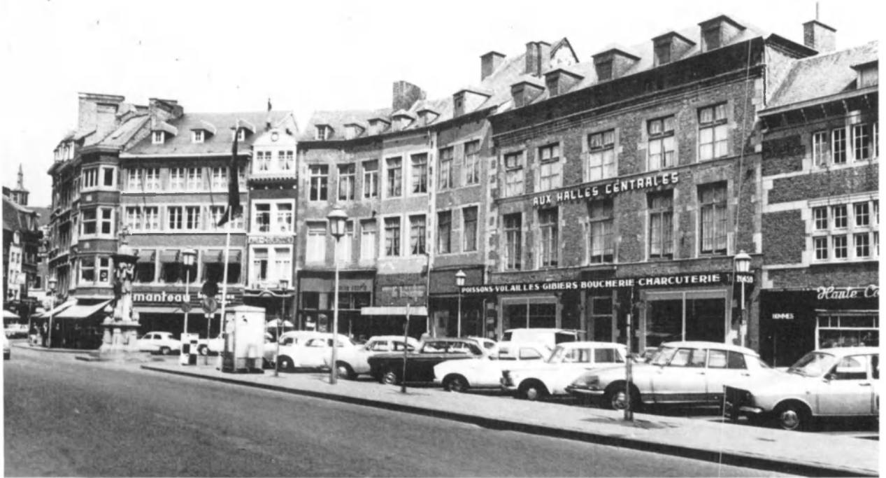
Fig. 19. Ensemble rue de l'Ange, 48-70. La rue s'est élargie depuis la suppression d'un bloc d'immeubles, bordé à droite par la rue de la Cloche.
