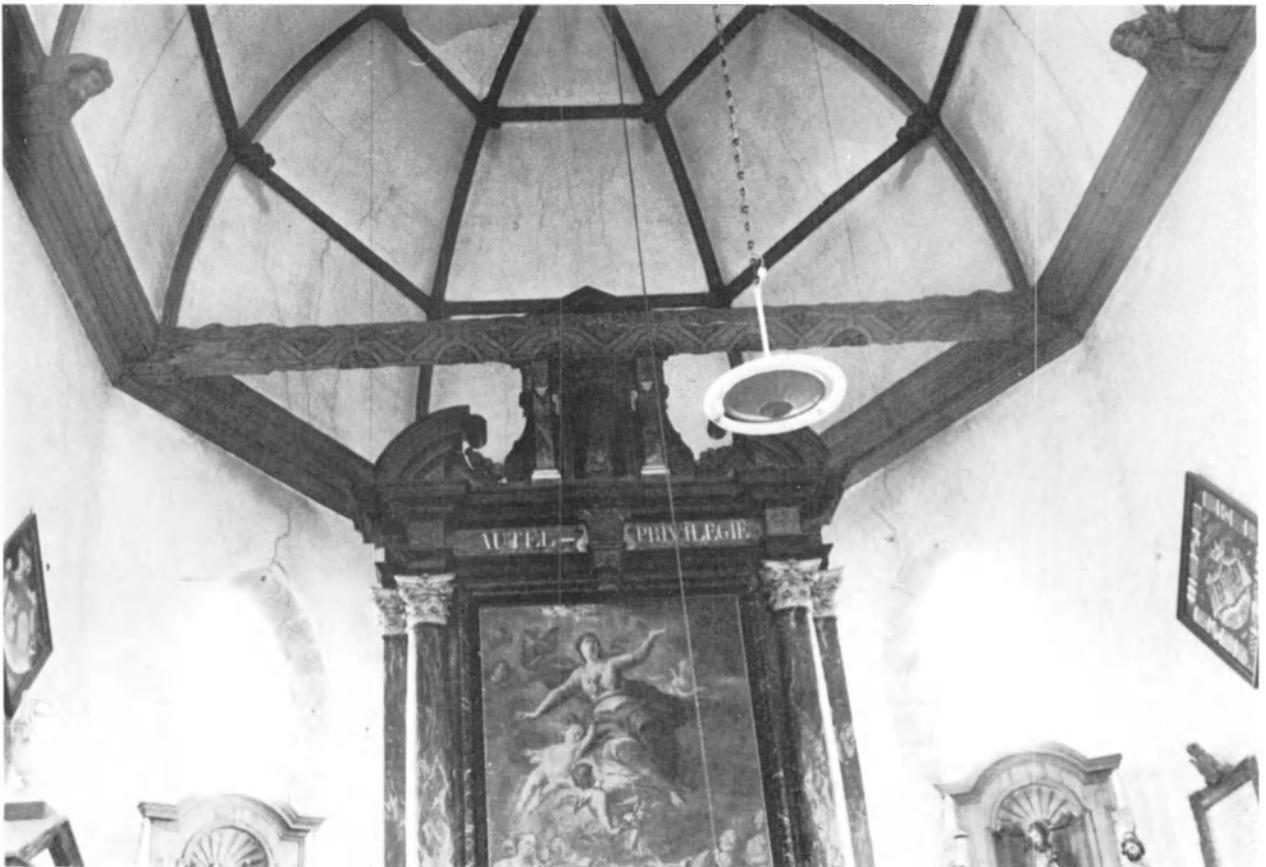
Fig. 2. HAVRE, chapelle N.-D. de Bon Vouloir, charpente lambrissée. (Photo abbé Huvelle.)
