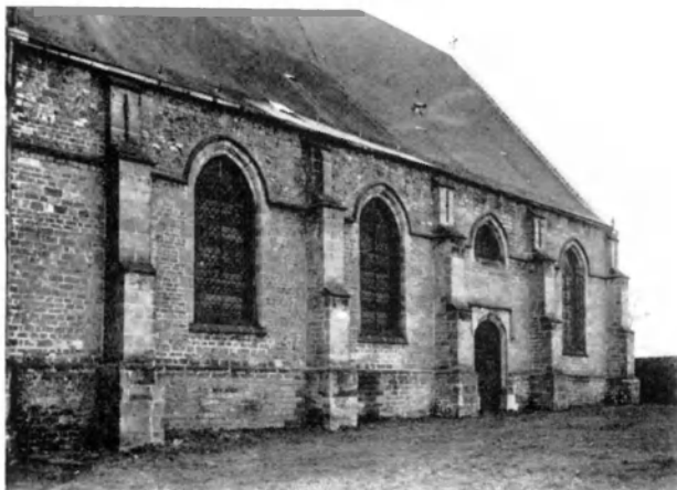
Fig. 10. BAUDOUR, église Saint-Géry, façade méridionale; au-dessus du larmier, une différence d'appareil marque les creux entre les pignons primitifs. (Copyright A.C.L.)
