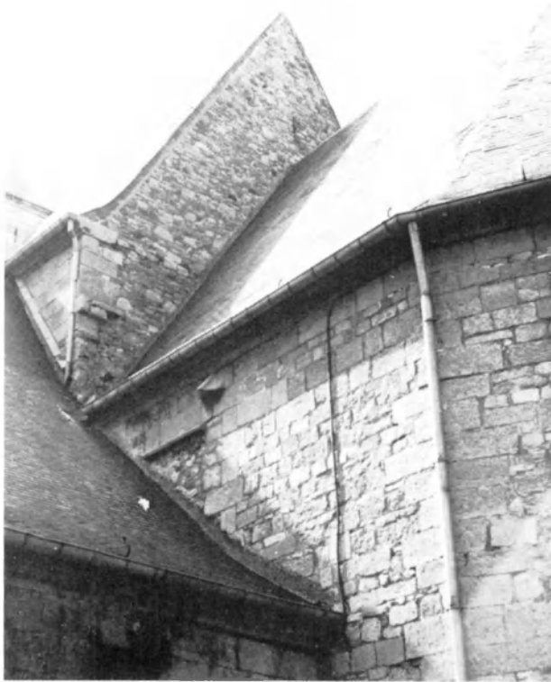
Fig. 7. COUSOLRE, église Saint-Martin, mur méridional du chœur avec reste de solive et de rampant.
