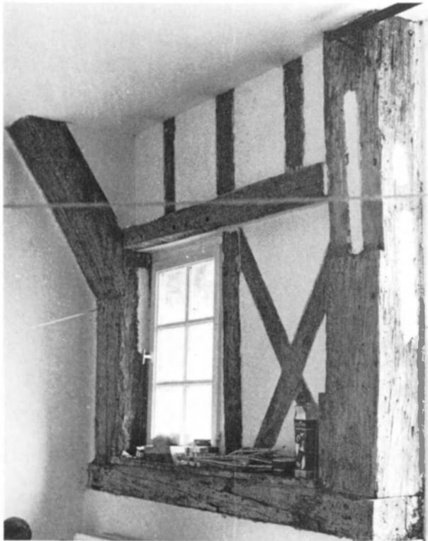
Fig. 7. Maison-forte d'Huissignies. Vue intérieure sur le colombage. La charpente a été sciée, à droite, pour faire place à une grande baie. Les mortaises d'assemblages ont été comblées avec du mortier.
