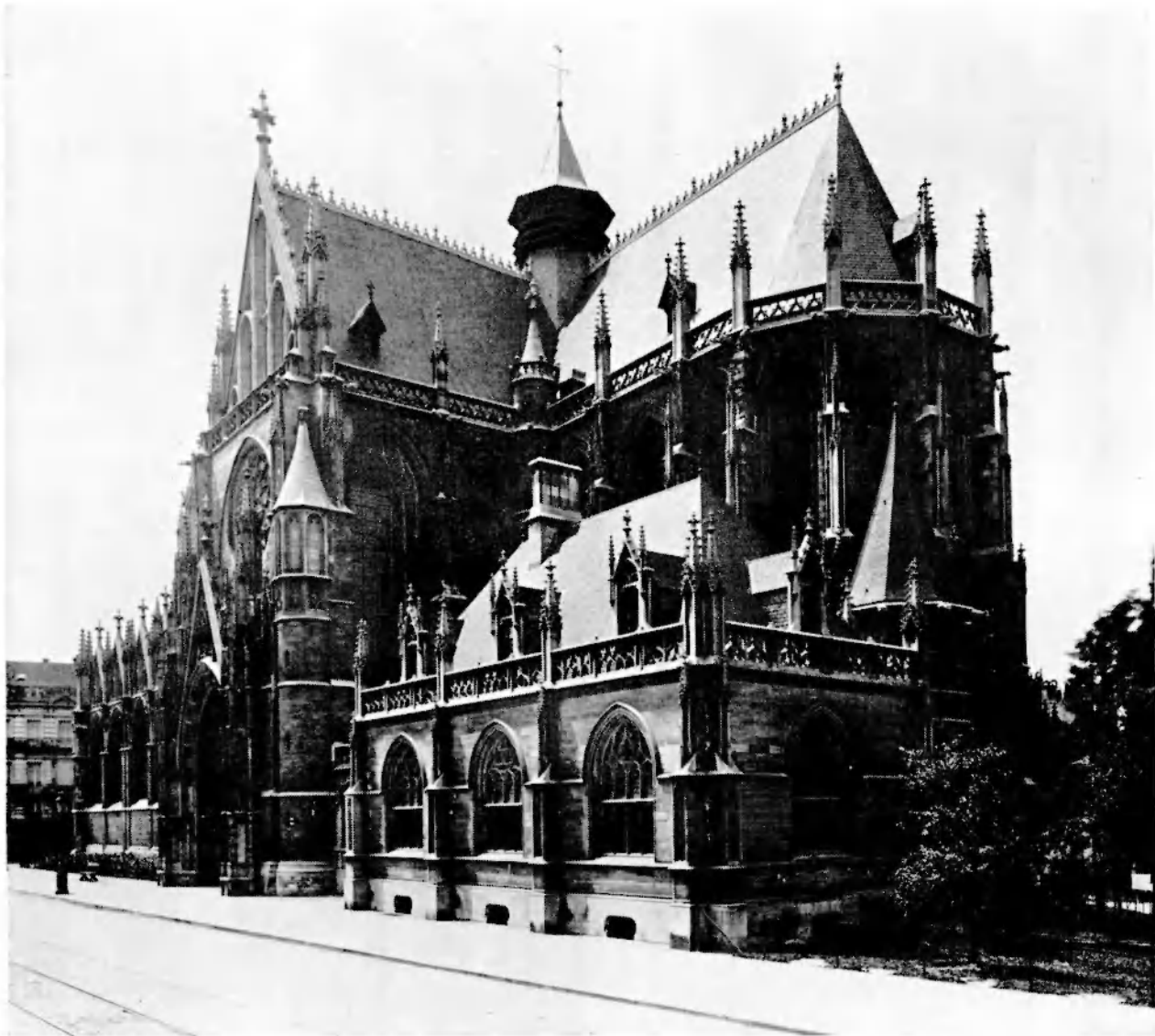
Fig. 23. Façades sud et est de l'église Notre-Dame du Sablon et de la sacristie, état actuel. Doc. I.R.P.A. B 137735.
