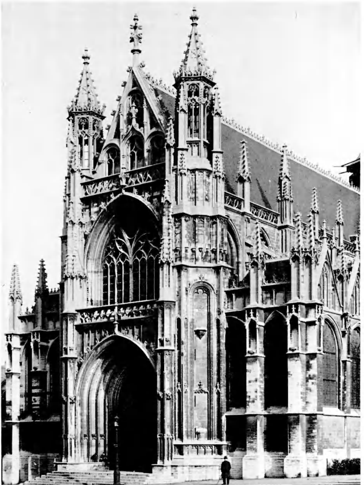
Fig. 20. Façade occidentale de l'église Notre-Dame du Sablon après sa restauration par J.-J. VAN YSENDIJCK, vers 1905. Doc. I.R.P.A. B. 17460.
