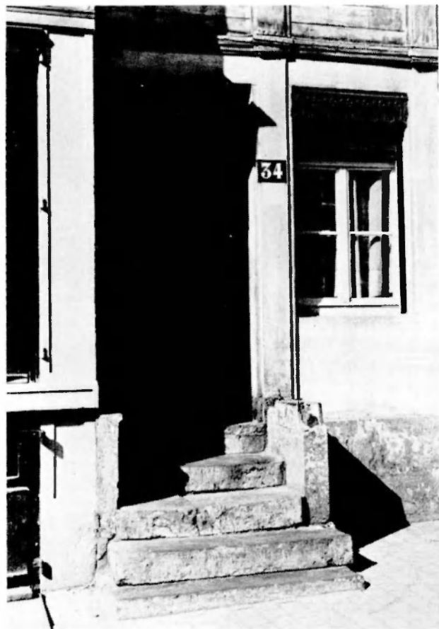
Fig. 15. N° 34. Détail du perron.
