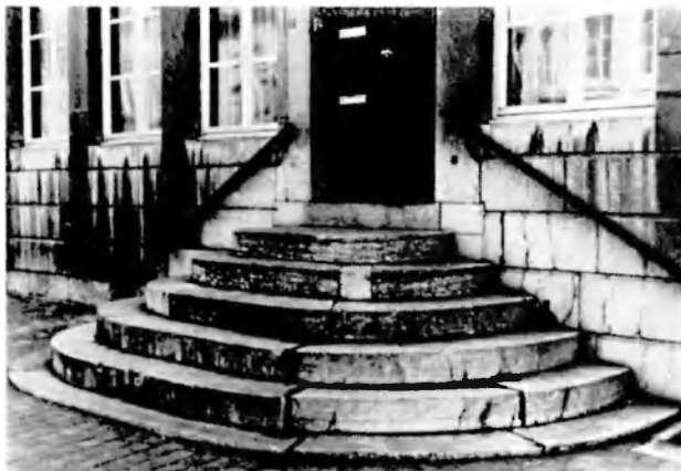
Fig. 30. N° 17. Maison Vivroux, détail du perron.
