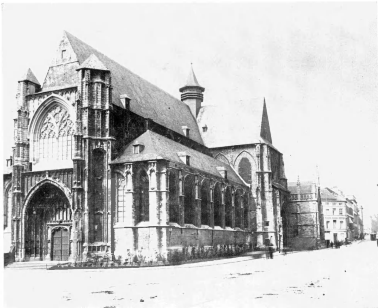
Fig. 13. Façades sud et ouest de l'église Notre-Dame du Sablon vers 1890-1893. Doc. I.R.P.A. B 194 842.
