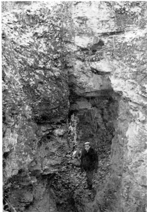
Une cheminée d'effondrement vertical de 10 m de hauteur.
