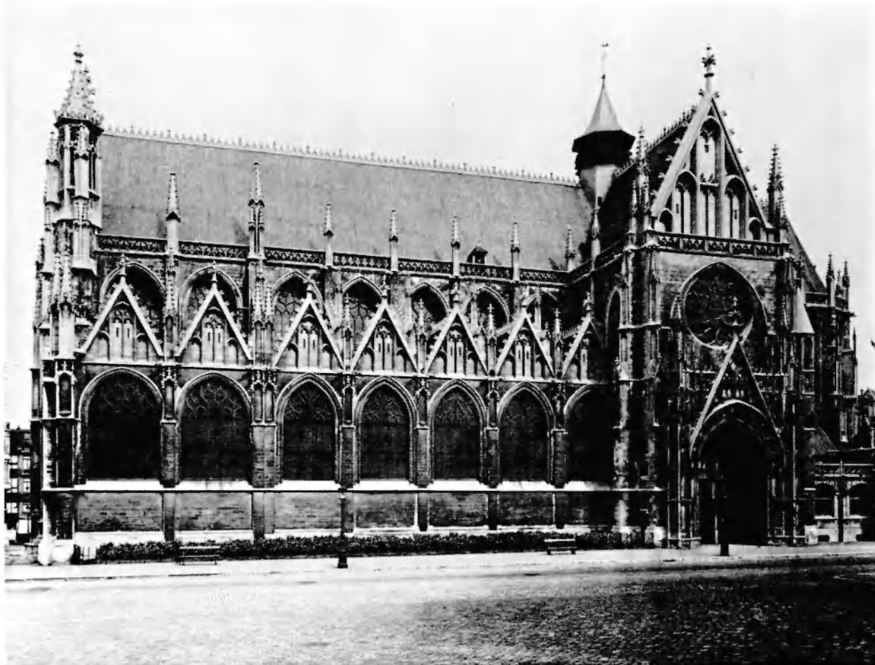
Fig. 22. Façade sud de l'église Notre-Dame du Sablon vers 1930. Doc. I.R.P.A. B 137 734.
