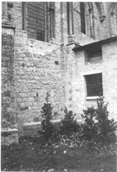
Fig. 22. Mur Est de la sacristie Nord (dans le parement du chœur, traces de l'ancienne sacristie). Photo de l'auteur.
