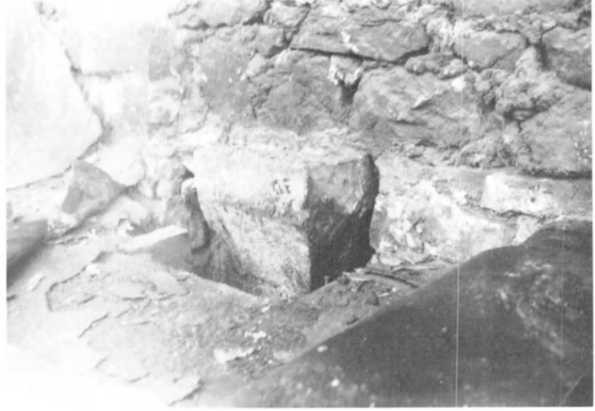
Fig. 5. Saint-Martin. Base du pilier ouest.
