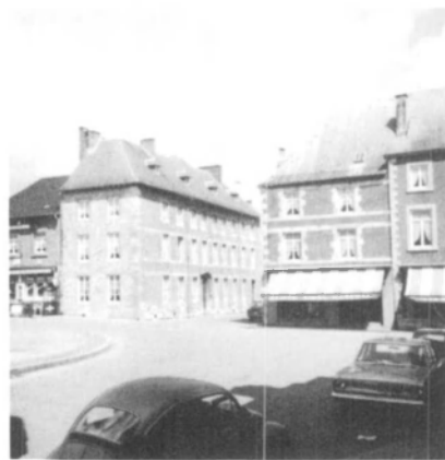
Fig. 35. Maisons des XVIII e et XIX e siècles au côté Est de la place d'armes. (Photo 1971.)
