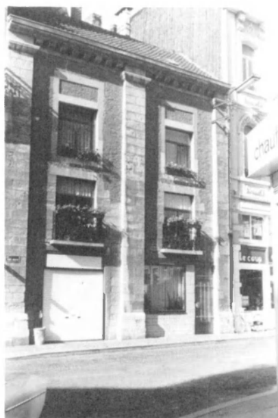
Fig. 13. La façade du n° 4, rue Saint-Martin (vue prise du sud).
