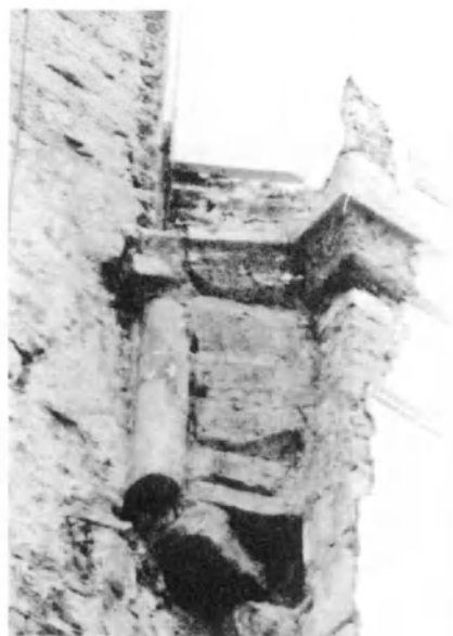
Fig. 7. Partie haute des supports du chœur: trace du chapiteau - fragment d'arc formeret. Photo: R. Vandendael.
