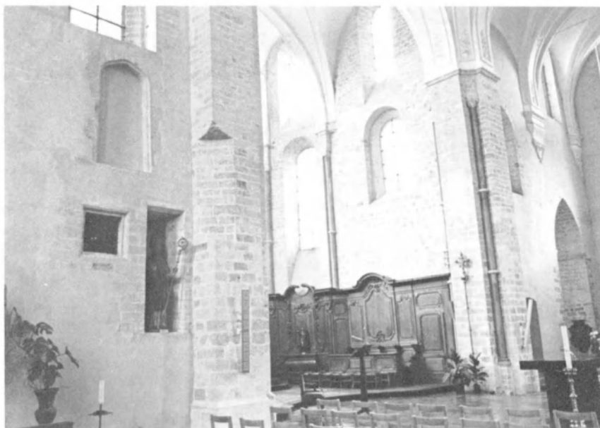
Fig. 16. Vue du mur Est du croisillon Nord. Les niches et les traces d'un passage vers l'ancien jubé. Photo de l'auteur.
