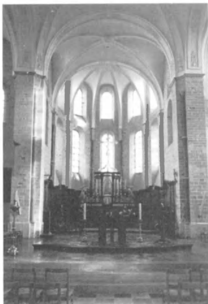
Fig. 4. Le chœur. Etat actuel. Photo de l'auteur.
