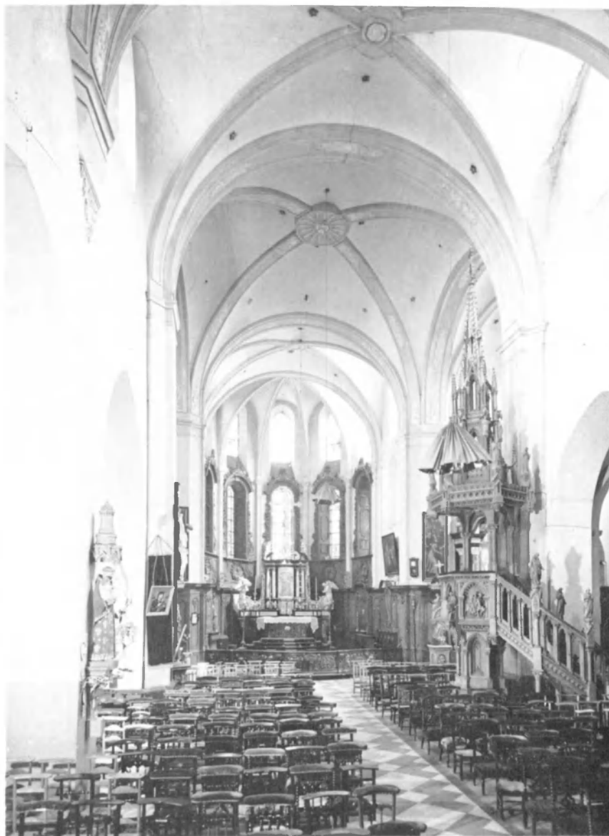
Fig. 3. Le chœur — avant restauration. Cliché A.C.L. n° 82.669 B.
