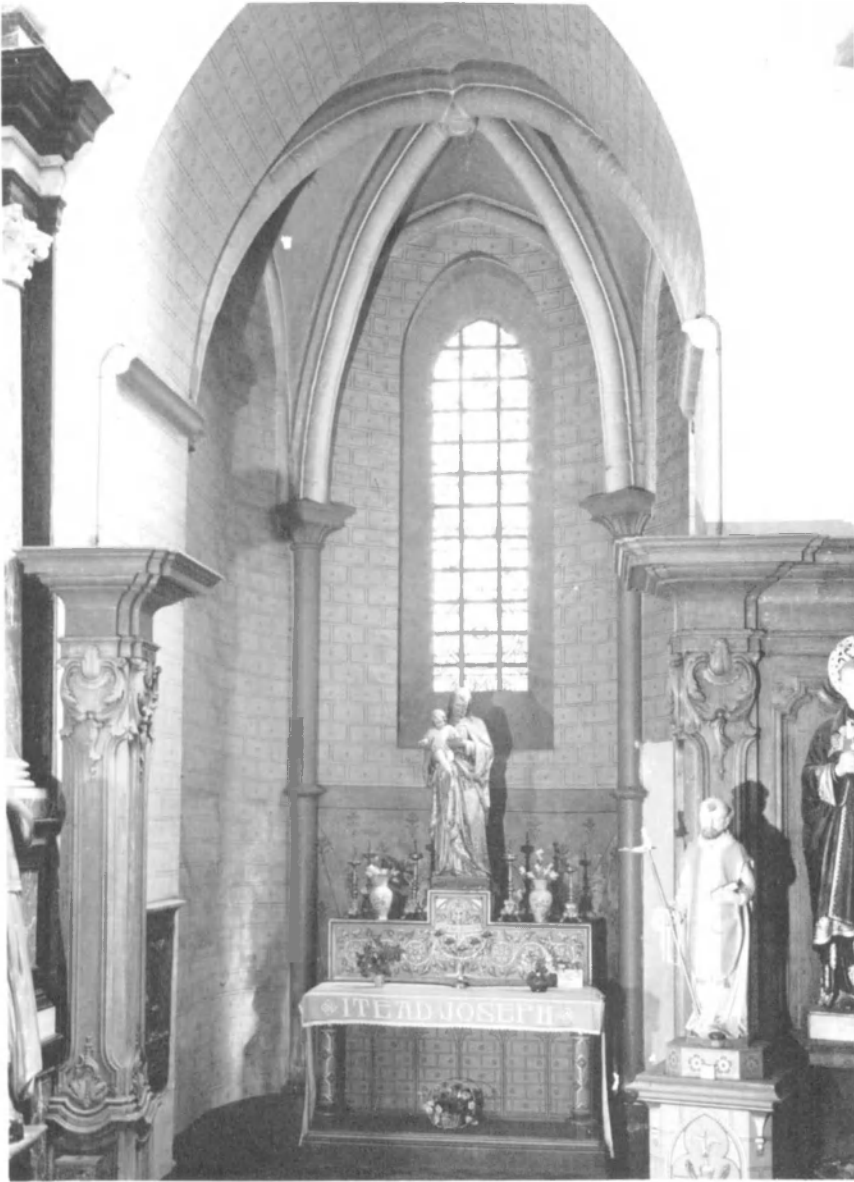
Fig. 10. Absidiole sud - avant restauration. Photo A.C.L. n° 82.688 B.
