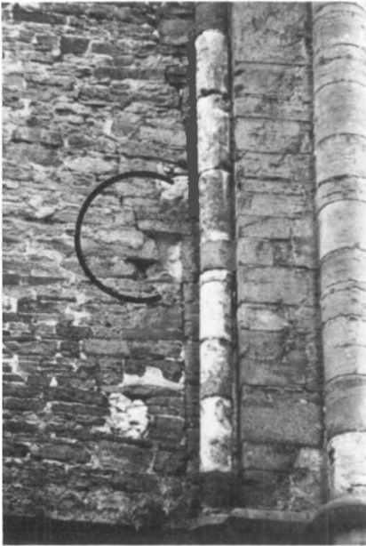
Fig. 13. Angle sud-est du croisillon nord: chapiteau et couture verticale du 2 e niveau.
