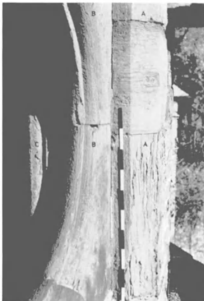
Fig. 14. Deuxième niveau de l'abside: exemples de pose en délit; a) montants extérieurs, b) oculus, c) colonnette intérieure.
