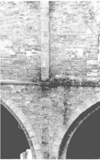
Fig. 7. Face est du croisillon nord : colonnette ancrée de façon continue.
