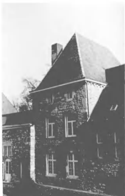
Fig. 8. Façade arrière. (Photo J. Culot).
