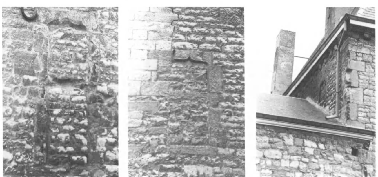
ig. 4-5-6. Détails des fenêtres gothiques murées de la façade latérale droite : au rez-de-chaussée (fig. 4), au premier étage (fig. 5), et au deuxième étage (fig. 6). (Photos J. Culot).
