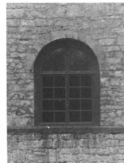
Fig. 9. Spontin. La face nord conserve un exemple encore évocateur d'une fenêtre jadis à meneau : couverture, piédroits et meneau, disparus, sont suggérés par le châssis du XIX e s. Les crochets du mantelet subsistent à la base de l'arc de décharge.
