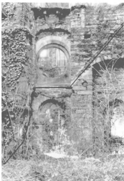
Fig. 15. Deuxième niveau du chœur: solins au revers de la face nord; a) premier contrefort de l'abside, b) accès à la coursive, c) corbeaux pour faitière.
