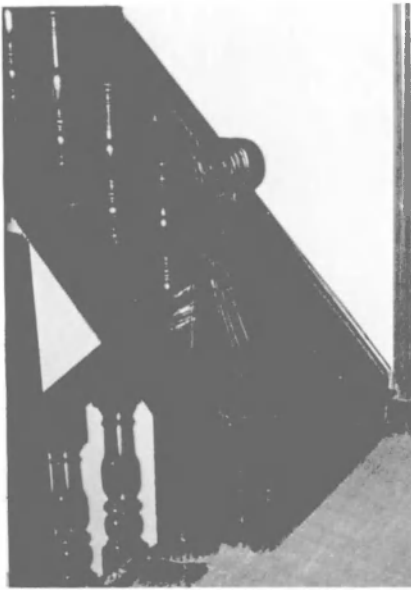
Fig. 18. Partie de l'escalier, à l'étage. (Photo J. Culot).
