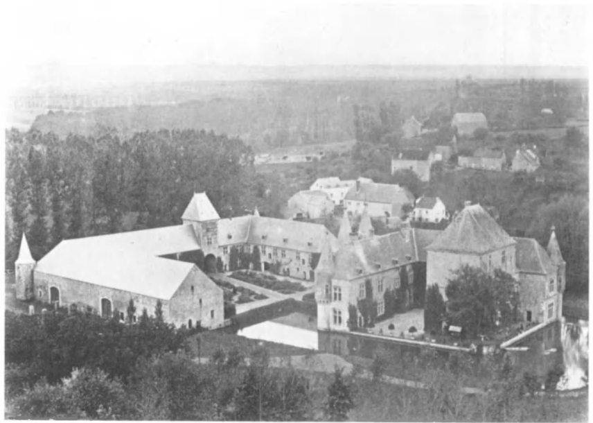
Fig. 3. Spontin. Le château et sa ferme depuis le nord-ouest. Etat en 1943 (?) (photo ACL).
