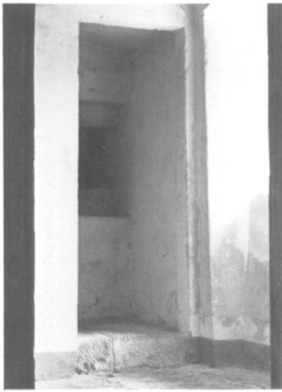
Fig. 17. Spontin. Palier et latrine du deuxième étage; au fond, la prise de lumière occultée.
