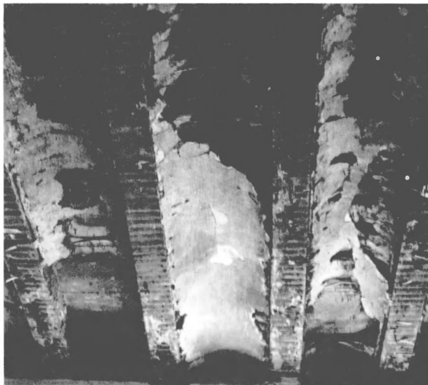
3. Voussettes en pisé sur baguettes arquées, dans le logis.
