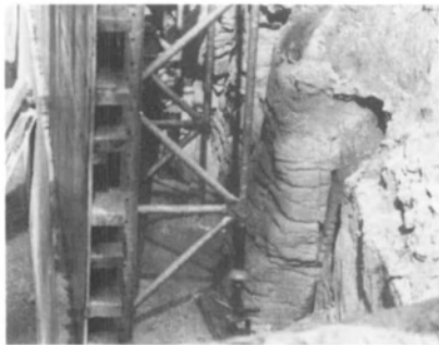
Fig. 6. Des travaux entrepris en 1972 ont mis à découvert, pour quelques heures, l'une des falaises de la Dendre Occidentale. Les affouillements provoqués par le courant s'aperçoivent derrière les échafaudages métalliques. Photo Marg. Sansen.
