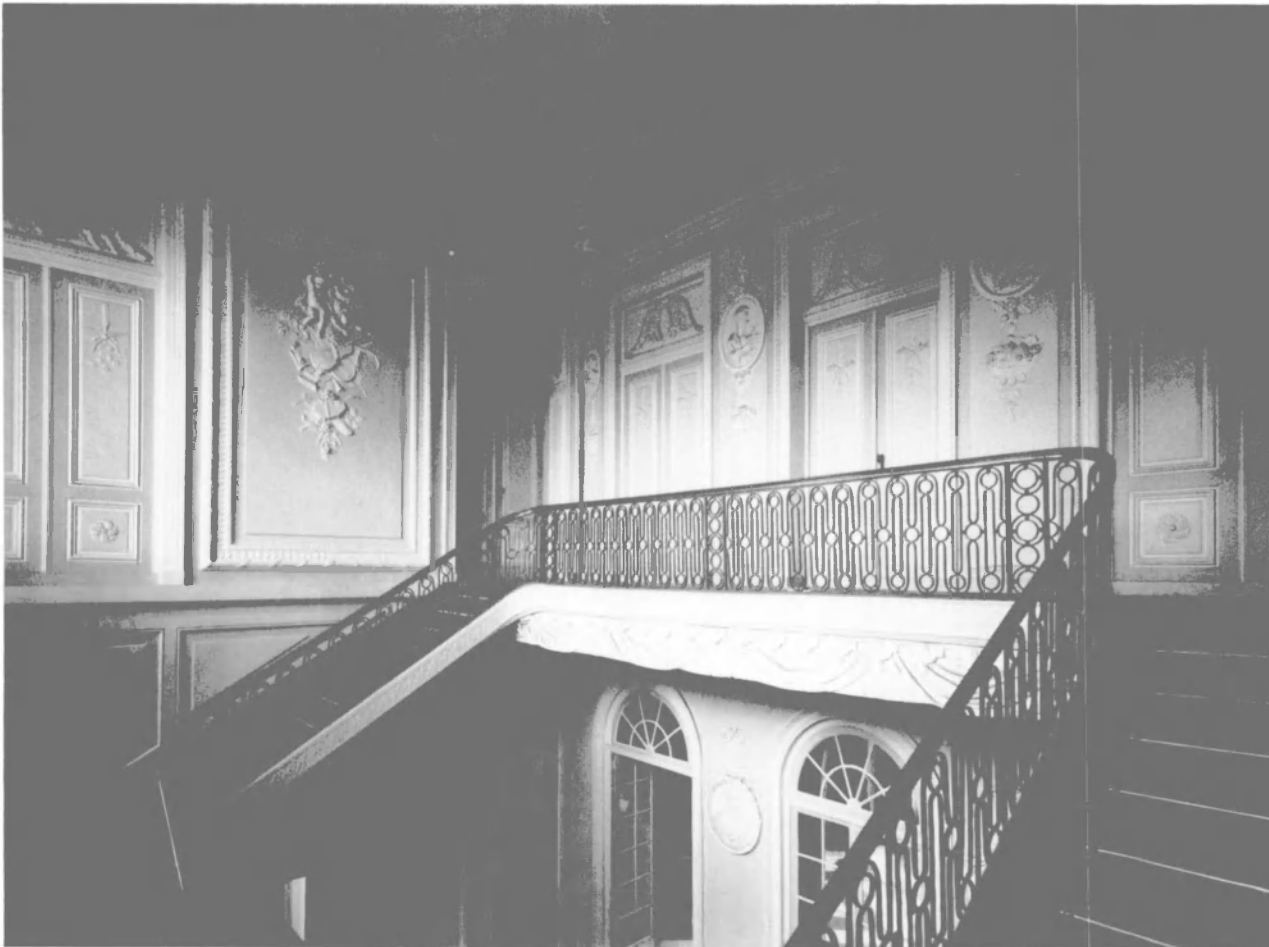
Fig. 10. Rampe néo-classique en fer, forgée par Toussain Closon, 1780 (Copyright ACL Bruxelles, 1942).
