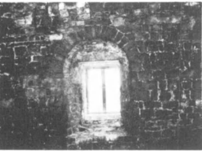
Fig. 53. Fenêtre au second étage dans la face ouest du donjon. C'est dans l'arcade d'embrasure qu'était logé l'oratoire du hâtelain. L'aire disponible mesurait 3 mètres sur 1 mètre 75. La croix percée au ravers de la muraille faisait office de retable. Le personnel du châtelain pouvait vivre la messe à partir de la cour. Photo Marg. Sansen.
