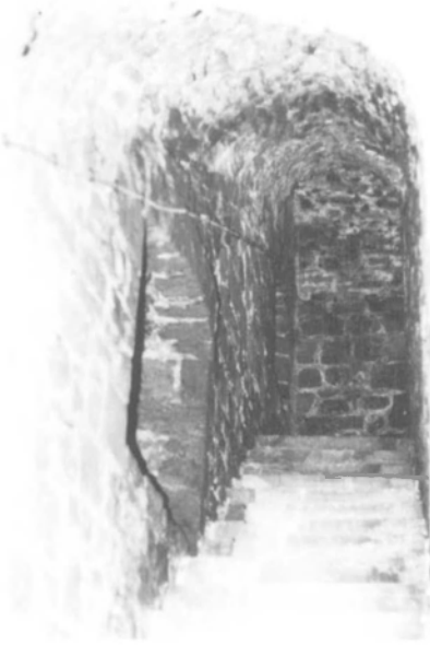
Fig. 59. La première volée d'escaliers vers les combles du donjon. Photo Marg. Sansen.
