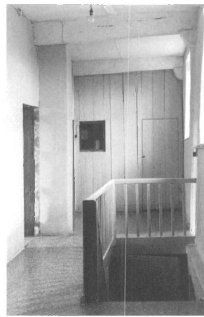
27. Couloir longitudinal de l'étage, éliminé depuis, vu vers le sud.
