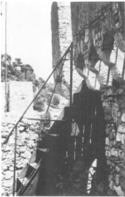
Fig. 74. Le donjon de Roquebrunes, X e s., à Cap-Martin dans les Alpes Maritimes. Escalier métallique donnant accès à la porte surélevée du donjon. Photo Marg. Sansen.
