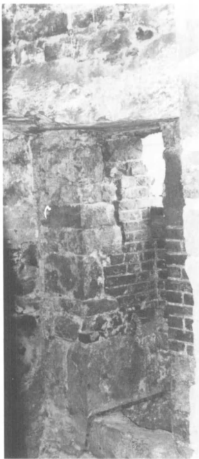
Fig. 44. La latrine de la salle des gardes, en saillie sur la face est du donjon. Une gaine de pierre en assure l'évacuation. Photo Marg. Sansen.
