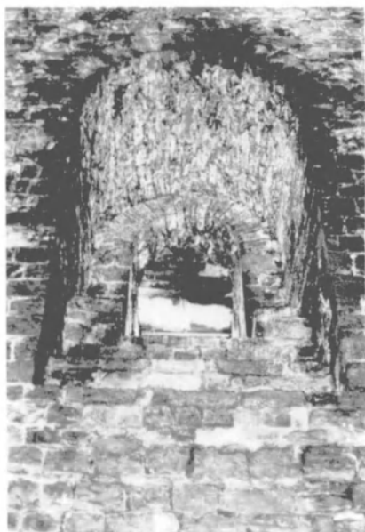
Fig. 51. La fenêtre du second étage, dans la face sud, est la seule à avoir gardé intactes ses arcades d'embrasures. Photo Marg. Sansen.
