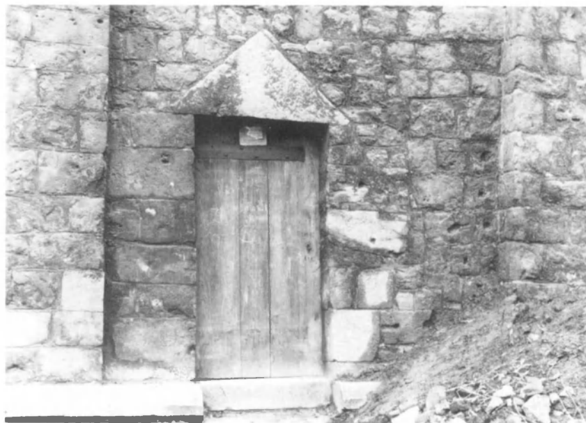
Fig. 15. Une porte vers les prisons du donjon a été percée au travers des quatre mètres de maçonnerie qui forment la base des murs de la tour. Les traces de l'arrachement provoqué par la percée sont visibles autour de la porte. Photo A.C.L.
