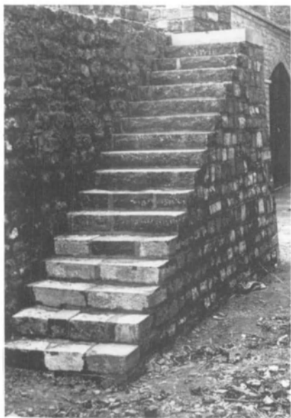
Fig. 87. Montée de pierre vers les aloirs. Cette montée a été reconstruite sur la base d'une ancienne montée retrouvée au cours des fouilles de 1942-1944. Photo Marg. Sansen.
