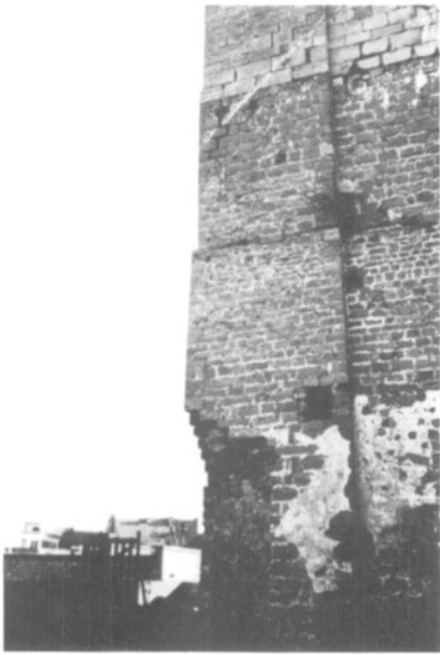
Fig. 14. L'angle nord-est de la tour a été écorné pour donner le passage à un couloir conduisant à des constructions qui avaient envahi le donjon sur deux de ses faces. Il est à remarquer que la maçonnerie, en suspension au-dessus du coin manquant, à parfaitement tenu depuis les cinq siècles où elle est dans cet état. Toute la maçonnerie de la partie supérieure de la tour a cependant subi une importante restauration au XIV e siècle. C'est l'exposition des alloirs aux intempéries qui avait provoqué les dégâts. C'est ce qui nous vaut la décapitation de la plupart des donjons. Le remède fut souvent de refaire une toiture reposant sur les merlons. Le donjon de Provins en est un exemple. Jacques du Broeucq l'avait aussi compris et nous lui devons d'avoir conservé le donjon de Burbant dans l'état où il est resté. Photo Marg. Sansen.
