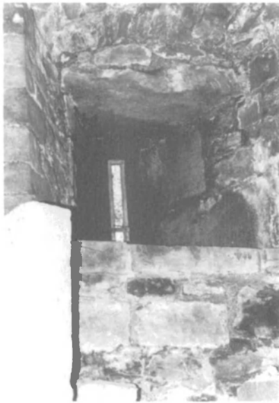
Fig. 48. Prise de jour dans la montée vers les étages supérieurs. Lors de la restauration de 1370 les rayères ont été refaites et des dalles ont été appliquées contre les voûtains. Photo Marg. Sansen.
