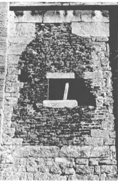
Fig. 41. L'entrée surélevée du donjon d'Ath. Les vestiges de l'entrée, encore en place, permettent une estimation assez précise des dimensions de l'ouverture. Photo Marg. Sansen.
