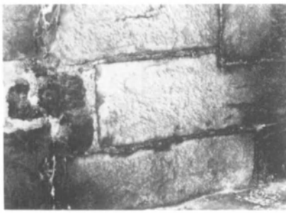
Fig. 19. Taille des pierres dans la restauration du XIV e siècle. Les bordures sont effectuées au ciseau et le surfacage à la pointe. Photo Marg. Sassen.
