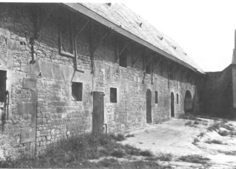
11. L'aile des étables depuis le nord. Au nord, l'angle de l'église.
