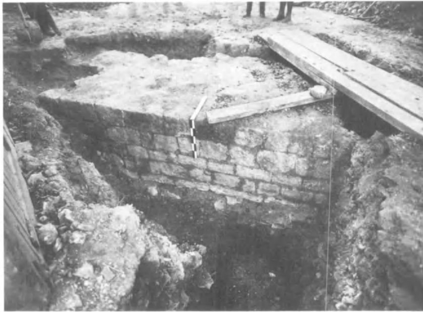
Fig. 90. Tronçon du mur de la chemise du donjon (N du plan d'ensemble des fouilles, fig. 15). Photo A.C.L.
