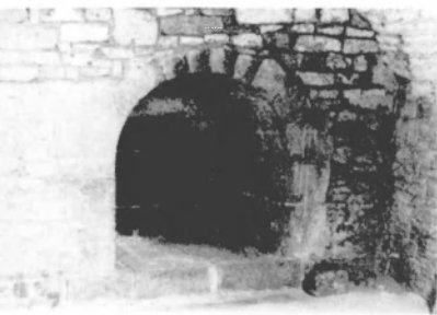
Fig. 79. Une meurtrière du château vers la campagne. Cet affaiblissement du mur, consenti en un point peu élevé de la forteresse, était compensé par l'adjonction d'un contrefort, lui-même traversé par les iseaux de la fente d'observation. Il n'existait d'ailleurs que trois de ces ouvertures à hauteur des celliers du château.
