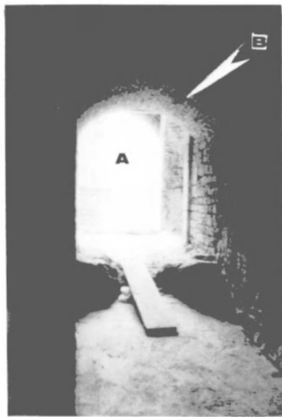
Fig. 82. Le couloir passant sous le pont-levis. A. La sortie vers les jardins du château B. La mince rainure par où passait une grille actionnée par le dessus. Photo Marg. Sansen.
