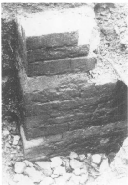
Fig. 85. Vestige d'un piédroit de l'entrée de la cour. Entrée simplifiée reconstruite vraisemblablement par Vauban en 1668. Photo A.C.L.
