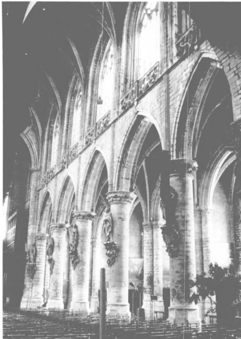
Figure 9. — Bruxelles, Notre-Dame de la Chapelle — Nef centrale. (Photo de l'auteur, 1981).
