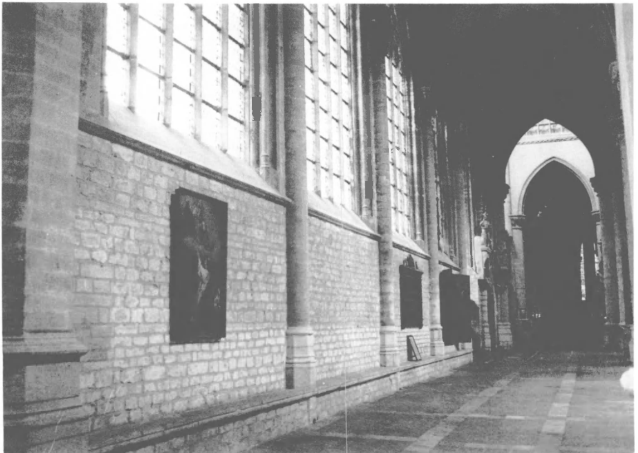
Figure 7. — Lierre, Saint-Gommaire – Bas-côté nord. (Photo de l'auteur, 1982).
