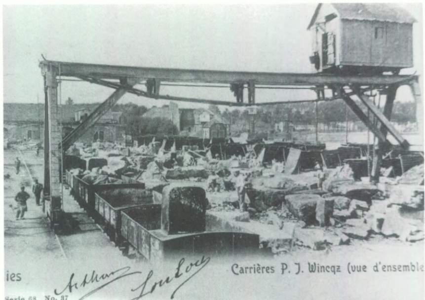
5. Vue du «grand chantier» de la carrière P.-J. Wincqz vers 1900 (avec pont-roulant). Carte postale d'époque.
