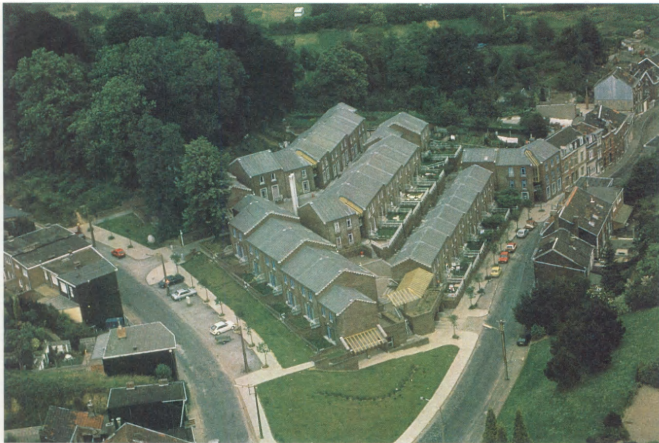
Logements sociaux à Bernalmont (Liège), arch.: Pierre Arnould et René Greisch.
