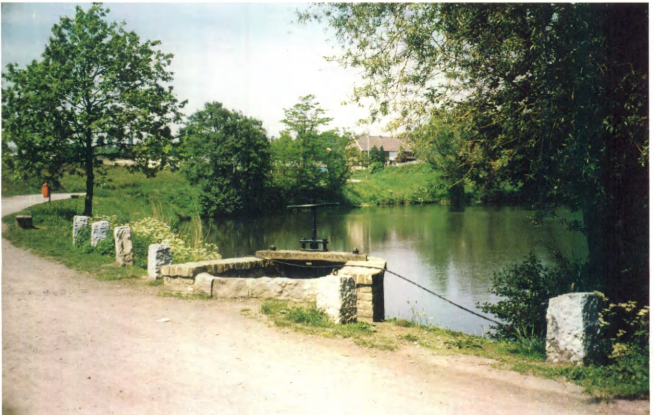
10) Casinoweihler, Wehr. Etang du Casino avec digue de barrage et ancienne vanne.
