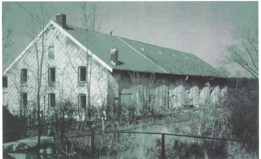
16) Bâtiment des anciens ateliers de la société de Membach à Perkits.
