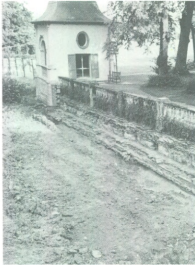
7) vue du mur de soutènement de la balustrade. © Direction des fouilles de la Région wallonne
