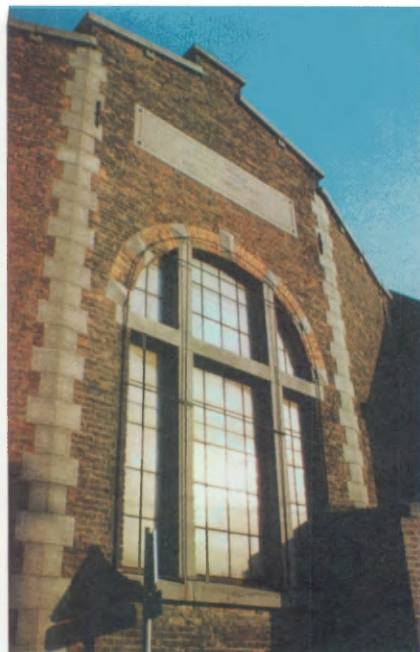
2. Façade de la centrale électrique Wincqz. Le fronton, au-dessus de la grande fenêtre caractéristique, porte le millésime 1894. Photographie G. BAVAY.
