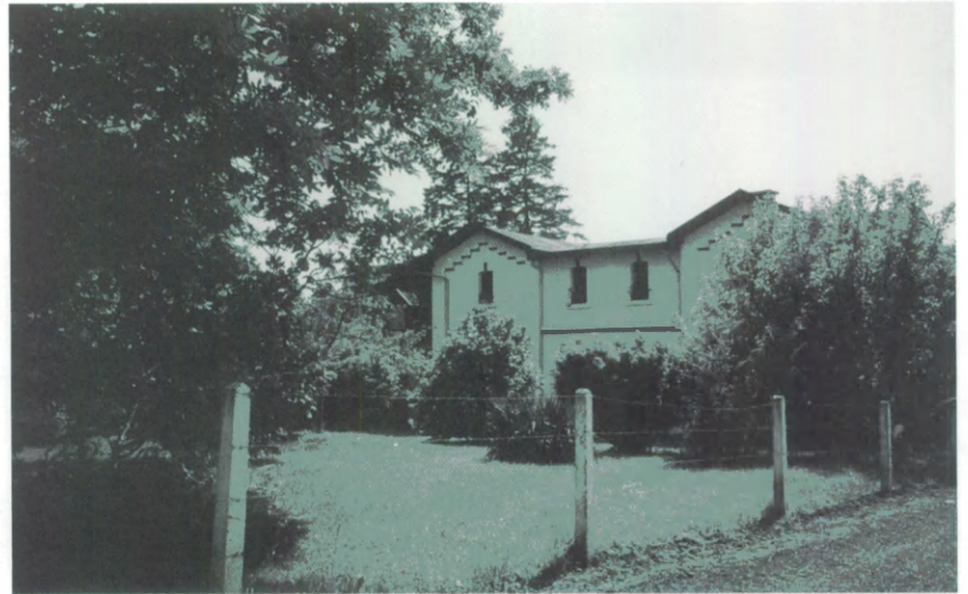
15) Bâtiment de l'ancien siège d'exploitation de Heggelsbruck
