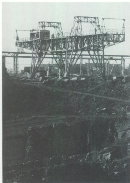
6. Pont-portique en bordure du siège d'extraction actuel de la carrière Gauthier-Wincqz. Photographie G. BAVAY.
