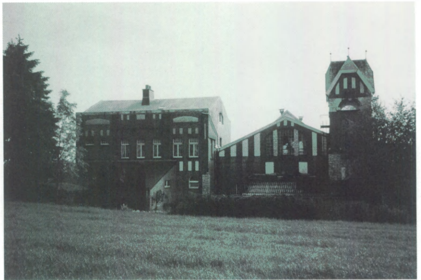
14) Bâtiment du siège d'exploitation de Lontzen.
