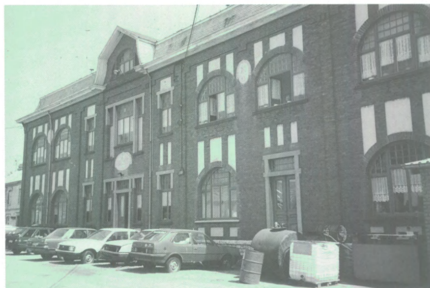
13) La Calamine. Façade principale (côté cour) du bâtiment de la Direction de l'agence de Moresnet (neutre).
