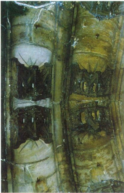
Fig. 20.- Tienen, baldaquins blancs (calcaire gréseux) et bruns (grès ferrugineux) en position de clefs de l'arcade du portail latéral gauche (1362-1363).
