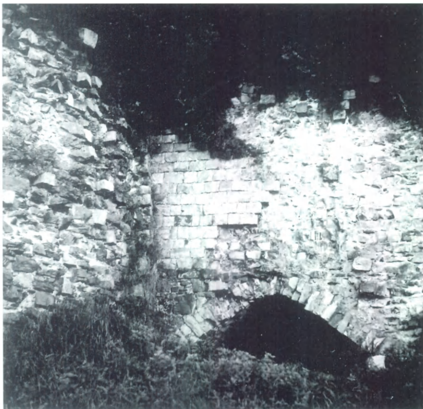
Fig. 12.- Vue ancienne du rempart de la Pépinière, qui repose sur de grands arcs brisés; le parement a été largement arraché au XIXème siècle pour en faire des pavés; la tour de gauche montre bien le système de boutisses à section carrée disposées régulièrement dans un blocage constitué essentiellement de grès et grès schisteux mal équarris; la plage de parement préservée à la jonction entre tour et courtine présente un appareillage très soigné, tout en grès de Bray, où les boutisses se fondent dans le moellonnage régulièrement assisé (cliché S. Brigode).
