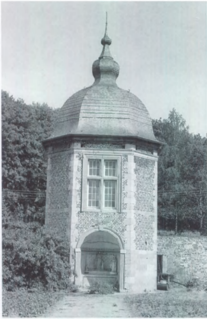
Fig. 24. - Pavillon du jardin de l'abbé; on distingue nettement les pierres bleues à patine claire, d'origine locale, des pierres bleues à patine sombre, petit granit portant des marques, utilisé pour les tours de baies et les cordons moulurés (cliché Fr. Tourneur, 1995).
