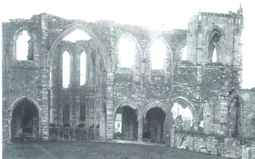
Fig. 19.- Vue générale du transept et du chœur de l'abbatiale, vers 1890; il subsiste très peu de traces des fenestrages qui seront restitués lors de l'intervention de L. Cloquet; à droite, le transept montre la maçonnerie hétérogène et peu soignée en grès des murs gouttereaux en net contraste avec le parement haut extérieur en appareil régulier de calcaire (cliché ACL 3211A, I.R.P.A.).
