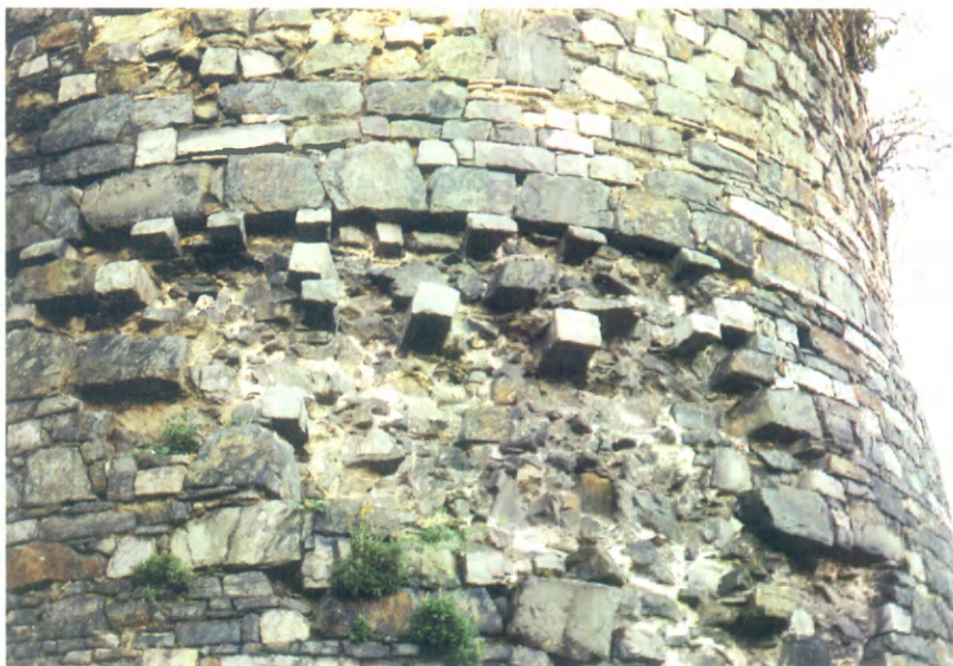
Fig. 15.- Grosse tour du rempart de Bon-Secours, en 1994; l'essentiel du parement et du blocage intérieur est constitué de grès un peu schisteux de couleur verte avec rares faces rouille, issu du Dévonien inférieur affleurant au sud de la ville; on notera la fréquence d'éléments de grande taille, ancrés en boutisses ou relevés en délit comme dans l'assise au-dessus du cordon; le grès clair de Bray est réservé à l'usage bien spécifique en boutisses à section carrée, irrégulièrement disposées, et au cordon biseauté à mi-hauteur; celui-ci est composé en alternance d'éléments étroits (disparus) et profonds, toujours solidement fichés dans le blocage (cliché Fr. Tourneur, 1994).
