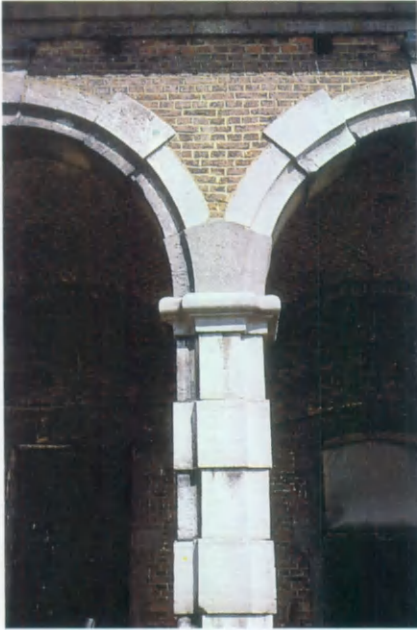
Fig. 30.- Détail des arcades de la ferme abbatiale; la pierre de départ des arcs est sensiblement plus foncée que les autres; ce seul élément de petit granit contraste avec les calcaires clairs d'origine locale (cliché Fr. Tourneur, 1995).
