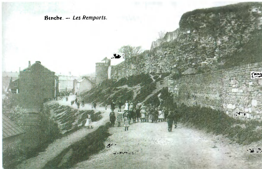
Fig. 13.- Rempart Saint-Ursmer au début du siècle; le parement a été presque intégralement arraché au XIXème siècle et seules les boutisses claires donnent encore une idée de l'alignement originel; la tour demi-ronde de l'arrière-plan a été remontée en briques et couronnée de créneaux néogothiques fantaisistes, simplifiés lors de la restauration de S. Brigode; la tour polygonale au premier plan droit a perdu presque tout son parement; noter le profil des terrées, modifié ensuite par le tracé du "boulevard" (carte postale PhoB, collection Fr. Tourneur).
