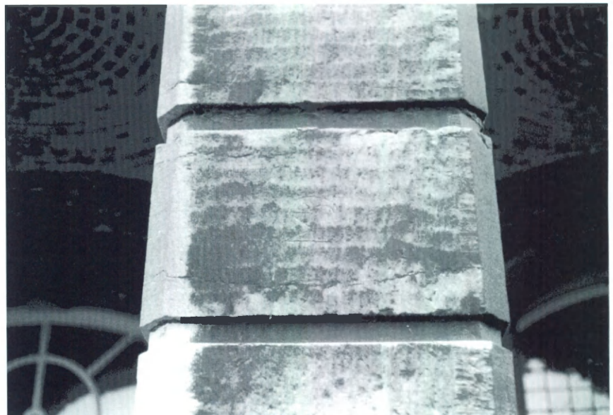
Fig. 29.- Détail d'un pilier à refends du second palais abbatial; élément de petit granit portant en plein milieu la grande marque lapidaire MBD (cliché Fr. Tourneur, 1995).
