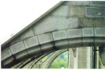
Fig. 47.- Arc-boutant du flanc nord du chœur, remonté au XIXème siècle en petit granit et retouché récemment dans la même matière; finitions variées, ciselée ou avec champ central bouchardé et palette périphérique ciselée (cliché Fr. Tourneur, 1996).
