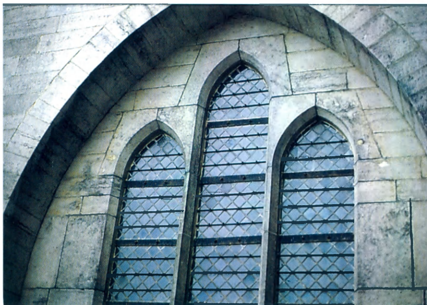
Fig. 52.- Fenêtre haute sur le flanc nord du chœur; le petit granit est très régulièrement appareillé, taillé sur des surfaces sciées, et la mise en oeuvre des pierres autour du triplet n'a probablement plus rien à voir avec les tracés médiévaux antérieurs; le résultat est bien sûr d'une grande sécheresse (cliché Fr. Tourneur, 1996).
