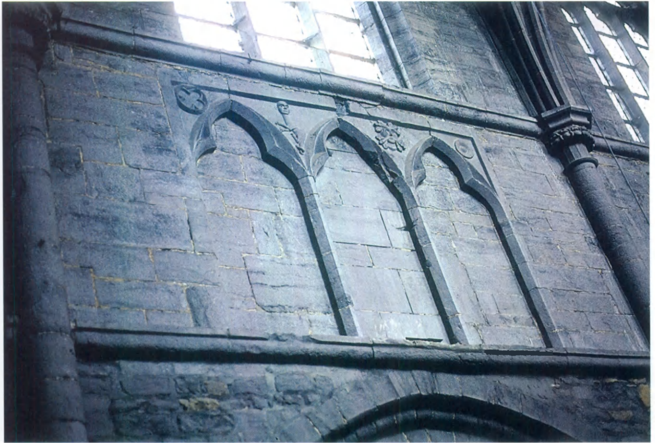
Fig. 54.- Faux triforium sur le flanc nord de la nef; l'appareillage très régulier et l'exécution sèche témoignent d'une large reprise au siècle dernier sous les fenêtres hautes, avec procédure en deux temps, terminée par le bouchage de l'arcature centrale (cliché Fr. Tourneur, 1996).
