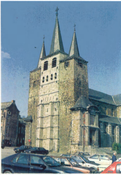
Fig. 35.- Avant-corps occidental de la collégiale vu du sud-ouest; on perçoit bien les limites de la schématisation des figures 33 et 34 : la partie supérieure de la tour sud, à l'avant-plan, est manifestement une reprise en matériau différent (cliché Fr. Tourneur, 1994).
