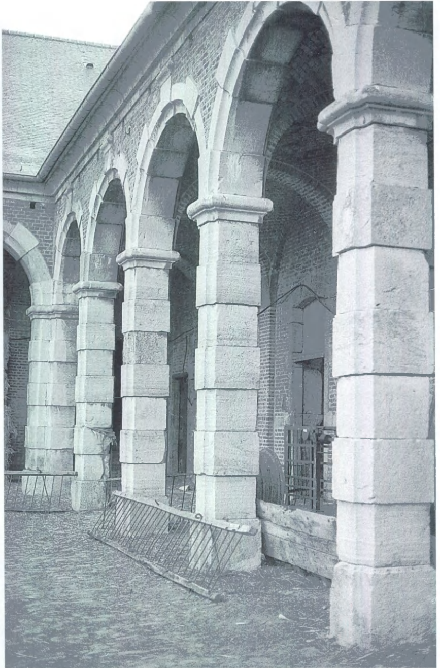
Fig. 31.- Arcades de l'aile occidentale de la ferme abbatiale en grands éléments de pierres bleues (cliché Fr. Tourneur, 1995).
