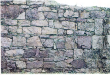
Fig. 17.- Intérieur du mur dans le bas-côté nord de l'abbatiale médiévale, correspondant à la figure 18a; moellons hétérogènes, mal équarris et peu assisés, mêlant grès clair, grès rouge et vert (cliché Fr. Tourneur, 1995).
