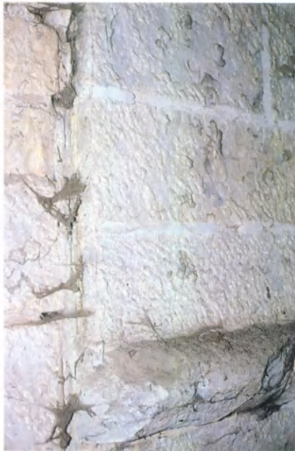
Fig. 48.- Basilique de Walcourt; un des rares parements médiévaux conservés, sur la face orientale de la tour, sous les combles de la nef; surface sommairement aplani à la pointe, sans palette (cliché Fr. Tourneur, 1996).
