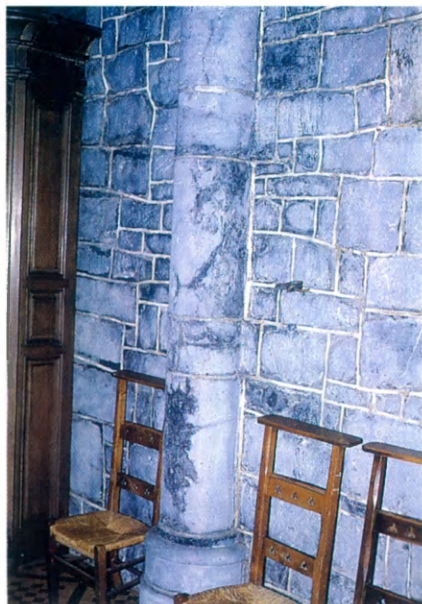
Fig. 53.- Colonne engagée du déambulatoire; les pierres médiévales ont été respectées bien que leur épiderme ait été perturbé par un décapage agressif suivi d'un bouchardage généralisé et de plusieurs campagnes de jointoiment; on notera l'appareillage de la colonne, avec alternance de courts tambours en lit ancrés dans la maçonnerie et de tambours plus hauts en délit (cliché Fr. Tourneur, 1996).
