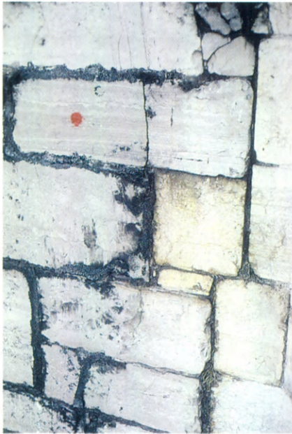
Fig. 41.- Couture entre le parement médiéval en calcaire de Meuse gris bleuté, à gauche, et calcaire dévonien légèrement beige, à droite, près de l'angle nord-ouest de la face septentrionale de la grosse tour (cliché Fr. Tourneur, 1996).
