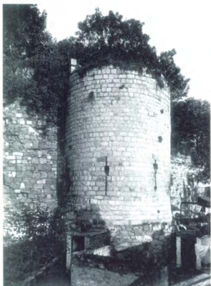
Fig. 10.- Tour dite "du cimetière", à l'angle sud-ouest des remparts; en contraste marqué avec les courtines voisines (à gauche, section dite "du Phénix"), la tour est entièrement revêtue de grès de Bray au-dessus d'un soubassement hétérogène; les moellons soigneusement équarris s'ordonnent en assises régulières, où les boutisses carrées se fondent dans l'ensemble; seuls les tours d'archères sont taillés dans un grès clair, légèrement verdâtre, non identifié (cliché ACL 88B, I.R.P.A.).
