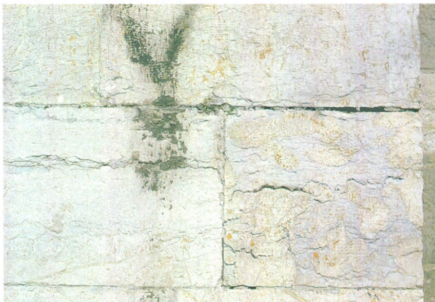
Fig. 39.- Détail d'un contrefort appuyé contre la tour centrale, en calcaire dévonien localement riche en fossiles coralliens (en bas à droite) et en poches de dolomie ferrifère orangée; le matériau est parcouru de nombreuses terrasses argileuses, qui se creusent par l'altération (cliché Fr. Tourneur, 1994).
