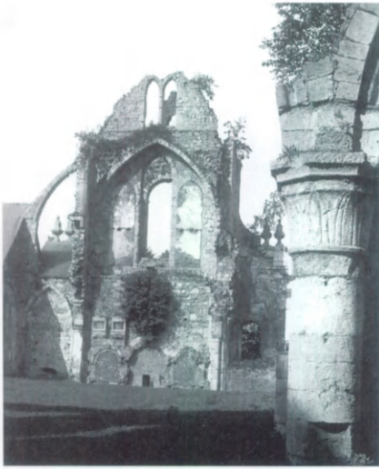
Fig. 20.- Ruines d'Aulne, pignon occidental de l'abbatiale médiévale, vu de l'intérieur en 1894, juste avant l'effondrement de la partie haute; le bas de la façade porte encore des traces importantes du décor marbrier baroque; à l'avant-droit, la colonne surmontée du chapiteau en grès clair aux feuilles sommairement sculptées; le niveau du sol est considérablement surhaussé par les déblais provenant de la destruction de l'église (cliché ACL 3213A, I.R.P.A.).
