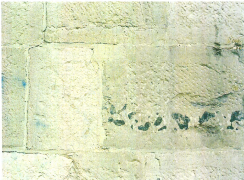
Fig. 38.- Détail du parement de la tour centrale, en calcaire de Meuse de patine variée, comportant localement des cherts, nodules siliceux noirs; la surface est régulièrement piquetée à la pointe avec une large palette mal délimitée, ce qui représente probablement un retraitement tardif (cliché Fr. Tourneur, 1994).
