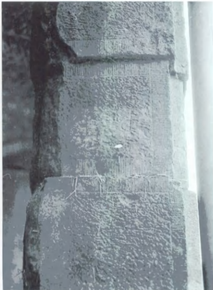
Fig. 32.- Détail d'un élément de petit granit des arcades de la ferme, portant, à l'envers, la grande marque PCT (cliché Fr. Tourneur, 1995).
