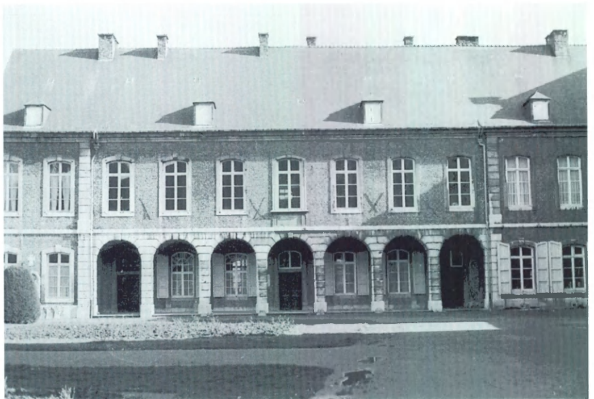
Fig. 28.- Vue générale de la même façade; malgré les salissures, les différences de patine restent perceptibles, les éléments de petit granit apparaissant plus foncés (cliché Fr. Tourneur, 1995).
