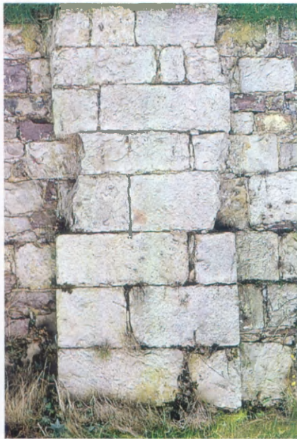
Fig. 22.- Pilastre scandant le mur intérieur du bas-côté sud de l'abbatiale médiévale; il est entièrement constitué de grès clair en éléments soigneusement équarris et bien appareillés, avec des retours latéraux liant le pilastre à la maçonnerie voisine (cliché Fr. Tourneur, 1995).
