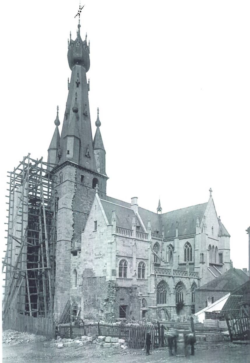
Fig. 46.- Basilique vue du sud-ouest en 1896; la restauration entamée presque un demi-siècle plus tôt s'achève sous la direction de P. Langerock; la photographie montre bien la façon de procéder : la face sud de la tour a conservé son parement médiéval, ainsi que la partie inférieure de la salle capitulaire au premier plan; le corps de l'église a déjà reçu son habit neuf et régulier, et l'on voit l'écorce nouvelle recouvrir petit à petit la surface ancienne; on en profitera pour rectifier le tracé des baies en l'homogénéisant (cliché ACL 4824M; I.R.P.A.).
