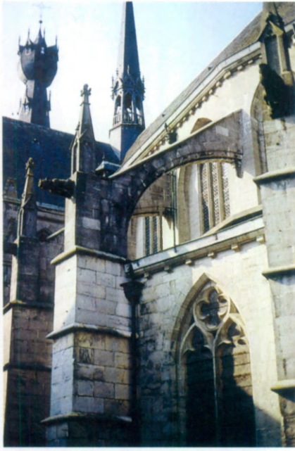
Fig. 51.- Choeur vu du sud-est, avec les premiers arcs-boutants refaits vers 1850 en calcaire dévonien et partiellement repris lors de la restauration générale en petit granit à la fin du siècle (cliché Fr. Tourneur, 1996).
