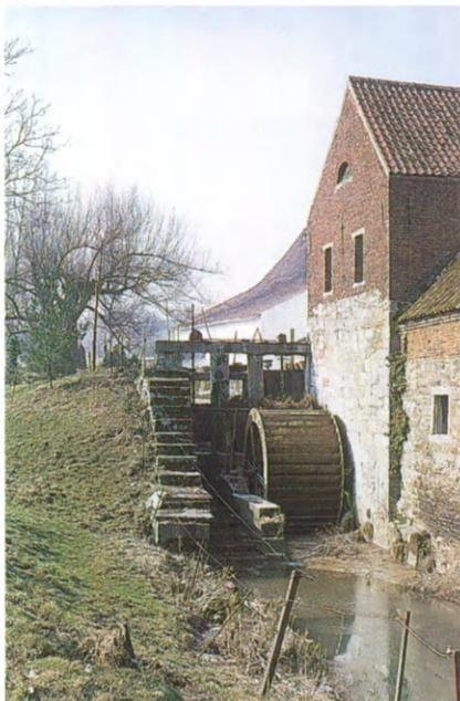
*Fig. 4.- Au Moulin de Combreuil à Ecaussinnes d'Enghien, la roue et la vanne de régulation s'associent pour former l'articulation privilégiée, organique et fonctionnelle entre le moulin et le cours d'eau. © G. Bavay, mars 1987.*
