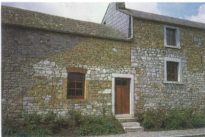
Fig. 6.- Maillen (Condroz). Bâtiment traditionnel du Condroz, construit ici en moellons de grès (jaune) et de calcaire (blanc). Encadrement des ouvertures en pierres de taille.
