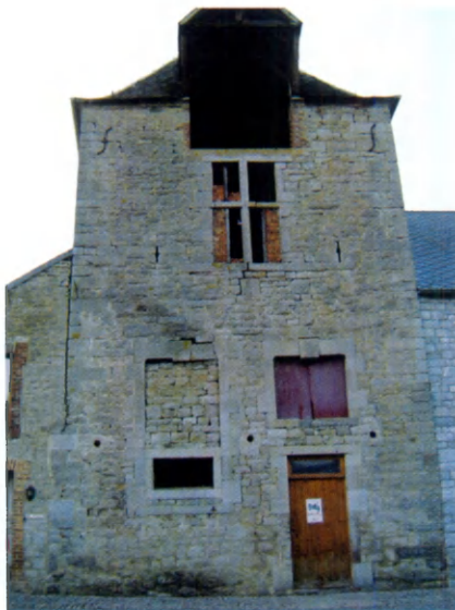
Fig. 18. - Vue du mur est. © Clémence Mathieu, 2006.
