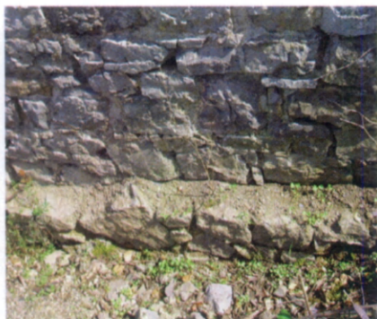
Fig. 15. - Vue de la base du mur ouest en ressaut.
