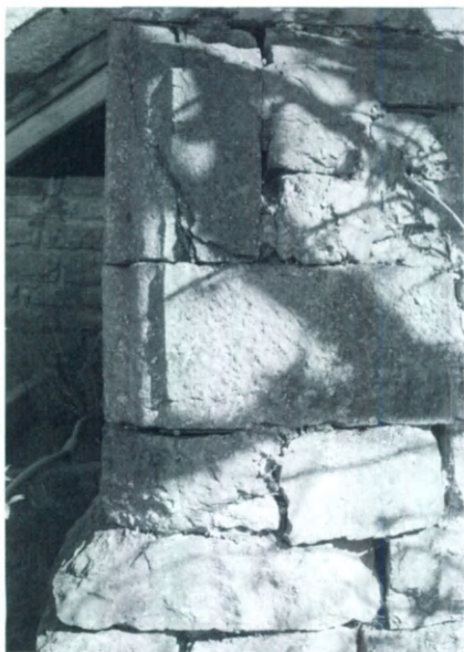
Fig. 10. - Structure A, façade sud : retombée de la moulure de l'angle sud-ouest. © Benjamin Vanieuwenhove.
