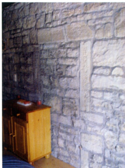
Fig. 30. - Vue depuis l'intérieur de l'annexe sud-est, de la partie supérieure de la baie à traverse occupant l'étage du mur sud de la structure A. © Clémence Mathieu, 2006.
