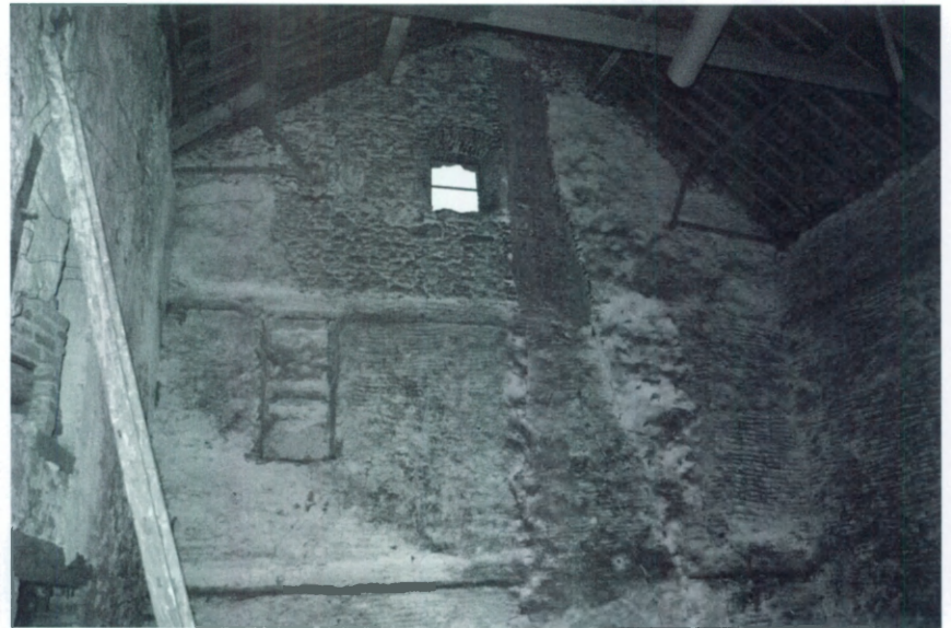
Fig. 27. - Structure A, façade nord, intérieur : vue générale. © Benjamin Vanieuwenhove.
