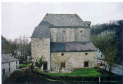
Fig. 20. - Vue d'ensemble du mur sud. © Clémence Mathieu, 2006.
