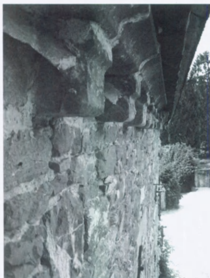
Fig. 14. - Structure A, façade ouest : modillon, côté sud de la suture (A1).
