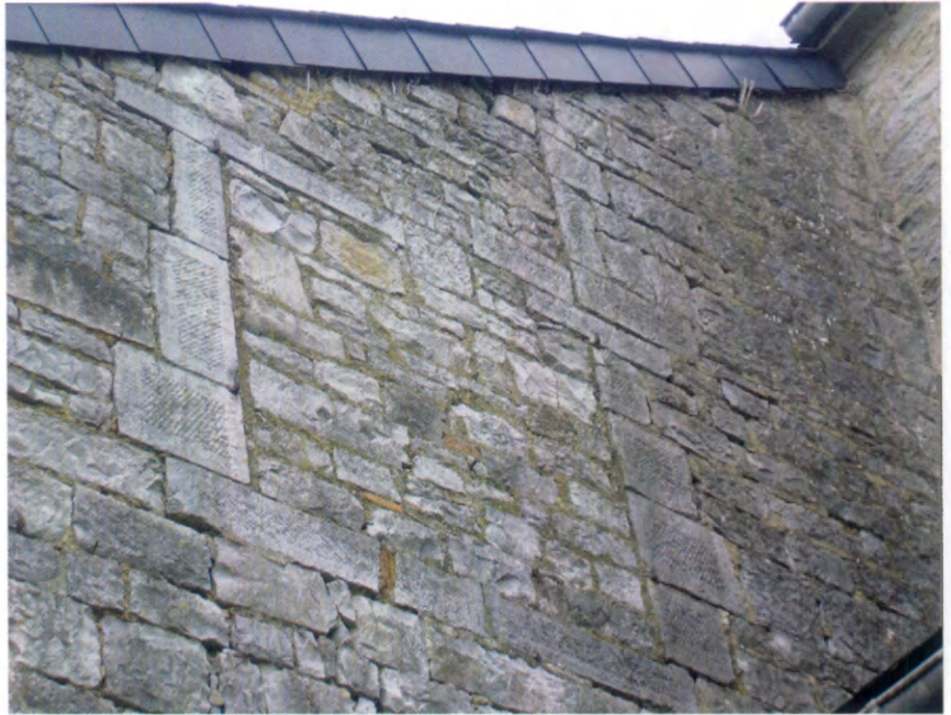
Fig. 32. - Vue de la baie occupant la partie supérieure du mur est de la structure B. © Clémence Mathieu, 2006.
