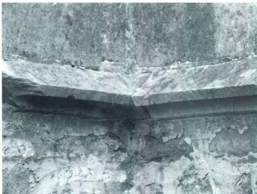
Fig. 12. - Jonction « tourelle » C - tour B : larmier taillé en angle. © Benjamin Vanieuwenhove.
