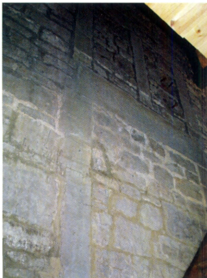
Fig. 29. - Vue depuis l'intérieur de l'annexe sud-est, de la porte et de la baie en imposte occupant la partie intérieure du mur sud de la structure A. © Clémence Mathieu, 2006.
