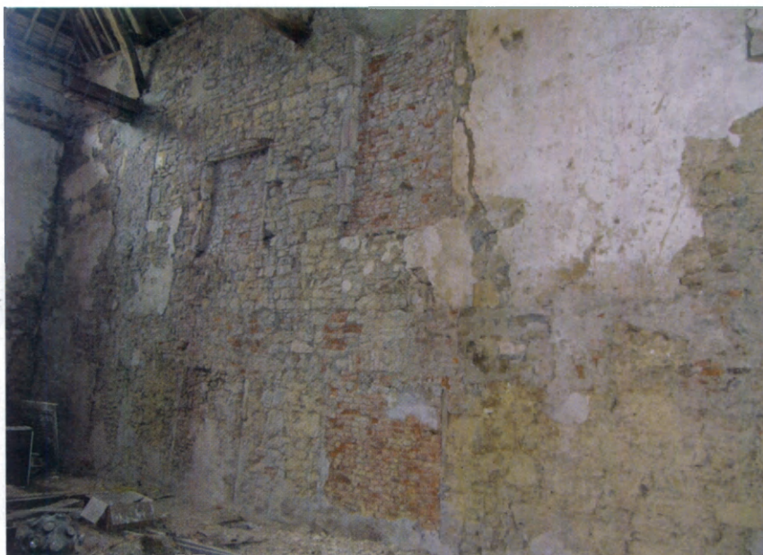
Fig. 26. - Vue générale du mur sud de la structure A à l'étage. © Clémence Mathieu, 2006.
