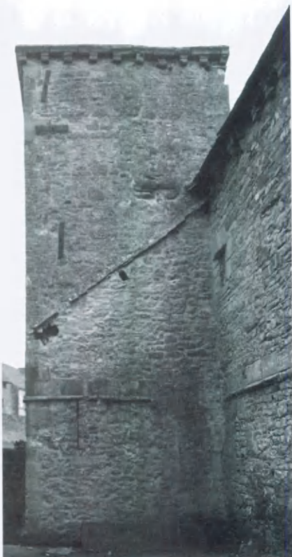
Fig. 13. - Tour B, façade sud : vue générale.
