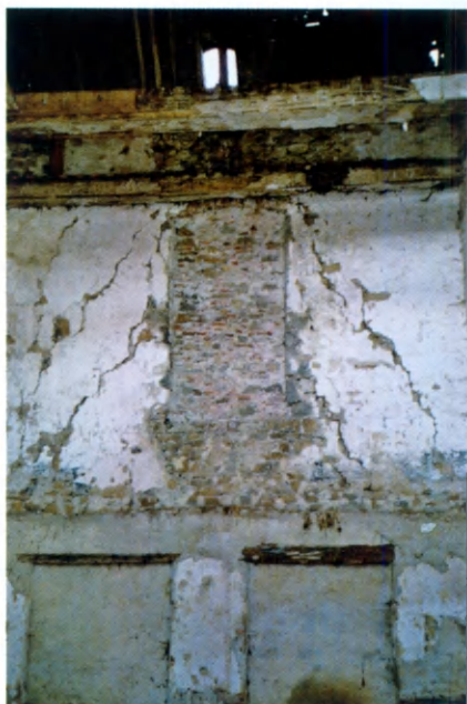
Fig. 23. - Vue générale du mur ouest de la structure A à l'étage. © Clémence Mathieu, 2006.
