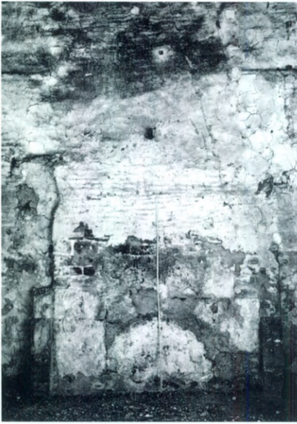
Fig. 28. - Structure A, façade nord, intérieur : cheminée. © Benjamin Vanieuwenhove.
