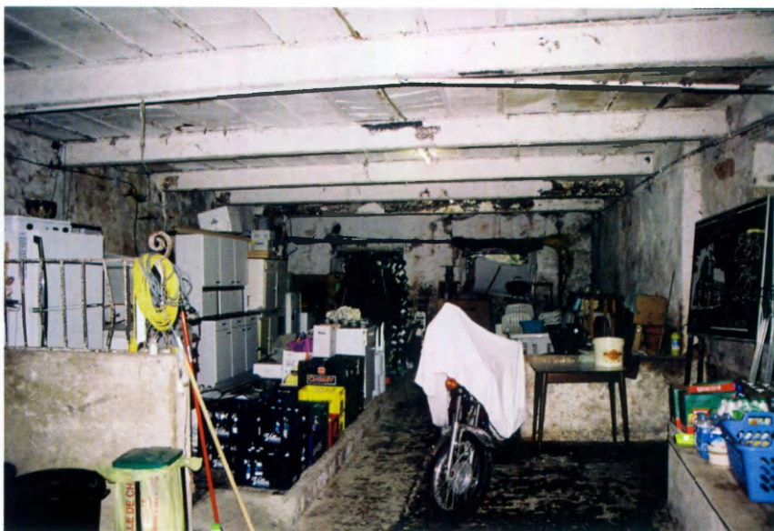
Fig. 22. - Vue générale du rez-de-chaussée de la structure A. © Clémence Mathieu, 2006.
