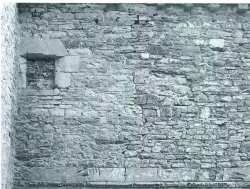
Fig. 31. - Structure A, façade ouest : détail de la suture.
