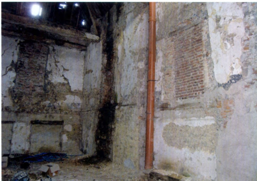
Fig. 24. - Vue générale du mur nord de la structure A vers l'est. © Clémence Mathieu, 2006.
