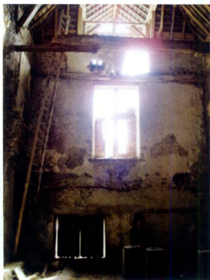
Fig. 25. - Vue générale du mur est de la structure A à l'étage. © Clémence Mathieu, 2006.
