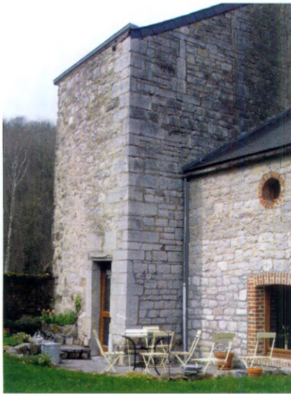
Fig. 27. - Vue de la structure B, murs est et sud.
