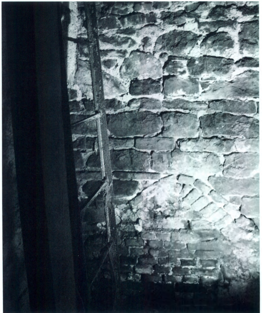
Fig. 24. - Structure A, zone intérieure sud : détail de l'arc rebouché de briques dans le mur \beta .
