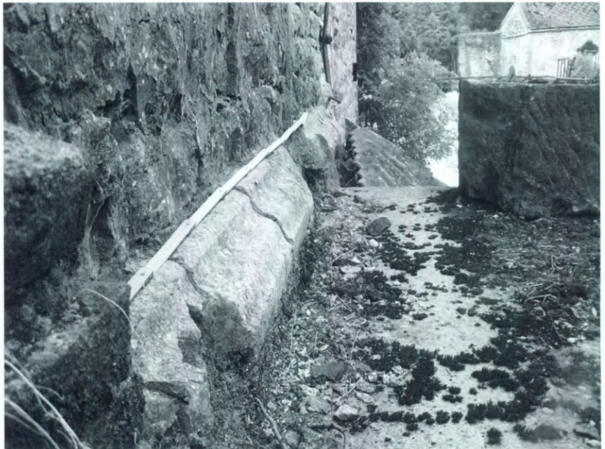
Fig. 6. - Structure A, façade ouest : moulure du soubassement, côté sud du joint montant (A1).
