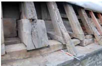
Fig. 9.- Pied de toiture occidentale de la chapelle, après retrait de la partie inférieure de la couverture. À droite, about d'entrait conservé ; à gauche, blochets assemblés sur une sablière double et une lambourde jointe à tenon-mortaise dans l'entrait.
