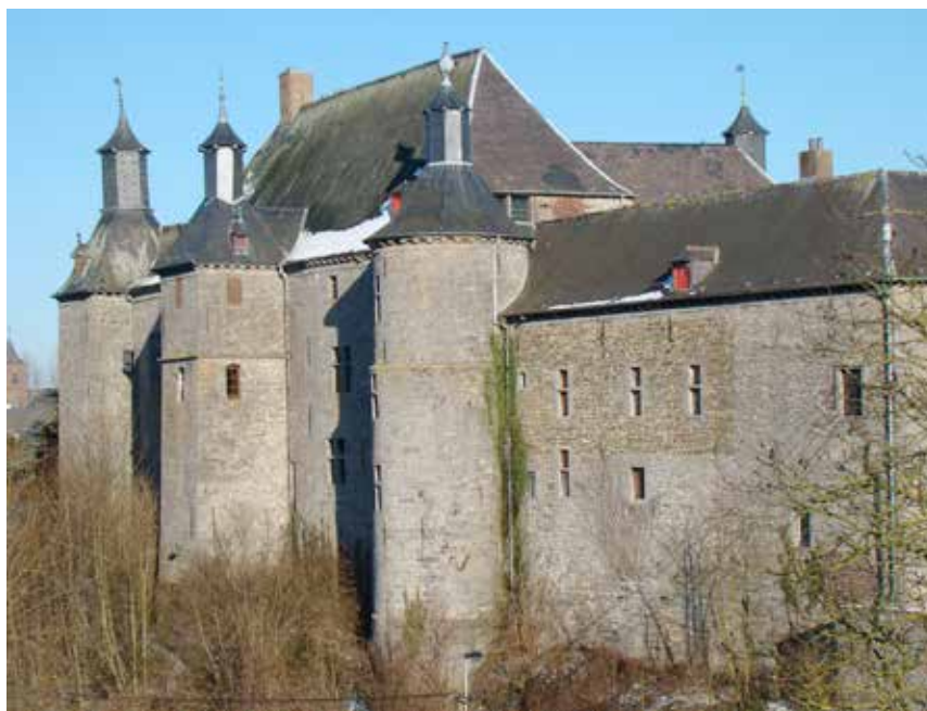
Fig. 1.- Vue générale de l'aile occidentale avant les travaux de restauration. © Gérard Bavay, février 2010.
