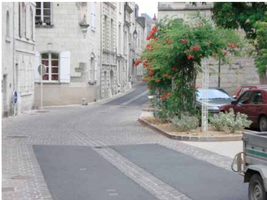
Fig. 23.- France, Saumur : un intéressant compromis entre fonctionnalité et respect de l'identité des lieux est créé par deux bandes de circulation en asphalté qui s'effacent au profit de la seule pierre naturelle là où les micro-contextes patrimoniaux et/ou urbanistiques l'exigent ; il fallait, dans ce centre ancien, éloigner la circulation motorisée de la Place du Marché. Outre la bande centrale, deux trottoirs en pierres naturelles assurent la liaison avec les façades en pierre des hôtels de maître des XIV e , XV e et XVI e siècles notamment. © Maurice Lorenzi.
