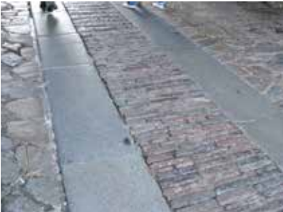
Fig. 21.- Italie, Bergamo, Città alta : deux bandes constituées de longues pierres naturelles forment des « rails » pour les pneus des véhicules automobiles ; des briques au centre et des pierres de forme irrégulière posées en opus incertum complètent la planéité de la voirie en permettant une circulation piétonne confortable sur l'ensemble de l'espace. © Maurice Lorenzi.
