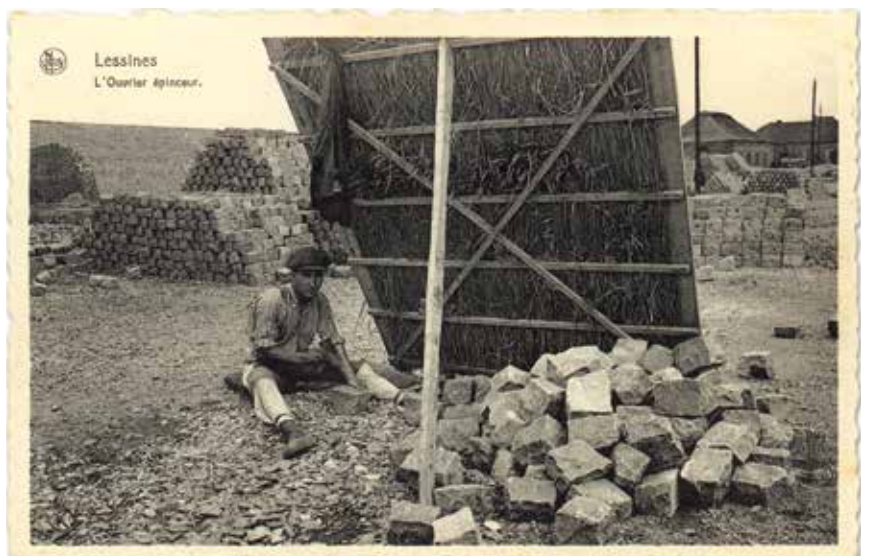
Fig. 5.- Lessines, l'ouvrier épincieur : le geste traditionnel de la retouche des pavés de gros format avec l'épincette, sous l'abri rudimentaire mais efficace, qui protège des ardeurs du soleil et de la pluie. On notera sur les tas bien ordonnés de pavés prêts à l'expédition à l'arrière-plan que chacun porte un point (sans doute à la peinture) sur toutes les faces destinées à ne pas être vues, pour orienter le travail du paveur en aval. Carte postale ancienne, Nels. Collections a.s.b.l. « Pierres et Marbres de Wallonie ».
