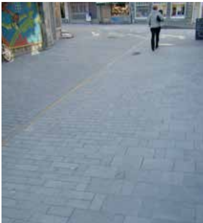
Fig. 14.- Tournai, rue piétonne au revêtement récemment aménagé : le principe est ici d'un sol uniforme de façade à façade, couvert d'éléments étirés transversalement par rapport à l'allongement de la rue. Le calepinage implique des dimensions croissantes du centre vers les bords, l'axe est marqué par une languette métallique, « fil d'or » tissé à travers la ville.
