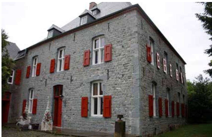
Fig. 28.- Maison seigneuriale de Monceau-Imbrechies, façades avant et latérale (après restauration).
