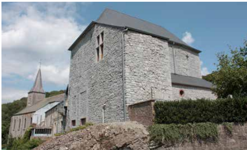
Fig. 5.- Maison haute du domaine seigneurial de Lompret, façades arrière et latérale (après restauration). © Clémence Mathieu, 2011.
