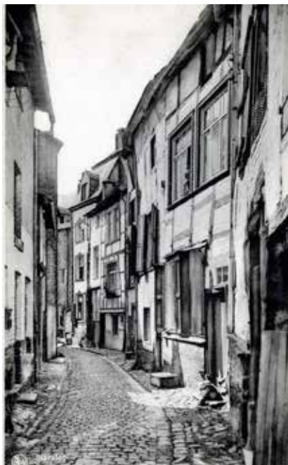
Fig. 35.- Stavelot, rue de la Fontaine : cette étroite voie pittoresque, bordée des traditionnelles maisons en pans de bois, est marquée au centre par un pavage en lignes à joints alternés, bordé de larges filets d'eau en deux pavés affrontés. Il n'y a pas de trottoirs à proprement parler mais un mince espace le long des soubassements, encombré de marches, perrons et autres chasse-roues.
