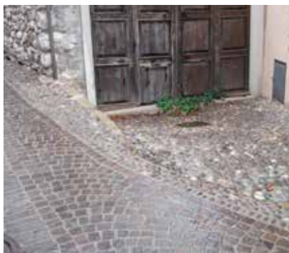
Fig. 16.- Italie, Brentino Belluno : des pierres naturelles clivées composent les deux bandes de circulation et le filet d'eau central ; le raccord avec les façades, entrées cochères, entrées de cave, escaliers, plans inclinés... est constitué de galets. La transition, ainsi assurée avec souplesse, permettant une liaison parfaite entre la voirie et son contexte immédiat, est dotée d'une texture intéressante, en dialogue avec des murs de galets visibles dans le village. © Maurice Lorenzi.
