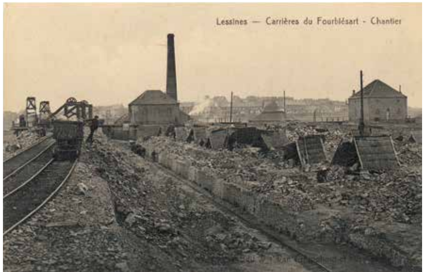
Fig. 4.- Lessines, carrières du Fourbiésart : le chantier d'une exploitation de porphyre en pleine activité avec les installations techniques des machines à vapeur et du chemin de fer interne à la carrière, et les huttes intemporelles des épincieurs. Carte postale ancienne, édit. V re Van Cromphout et Fils. Collections a.s.b.l. « Pierres et Marbres de Wallonie ».
