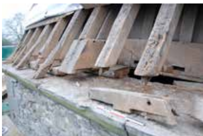
Fig. 10.- Pied de toiture orientale de la chapelle et dépose d'un blochet dont on voit les assemblages à demi-queue d'aronde.
