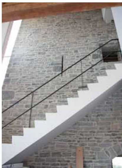
Fig. 25.- Ancien mur extérieur de la tour, intégré au XVI e siècle dans la maison (après restauration). © Clémence Mathieu, 2011.
