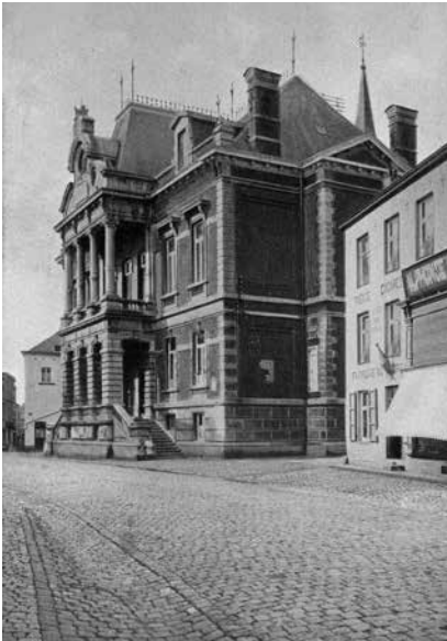
Fig. 37.- Ciney, hôtel de ville : le sol de la rue est entièrement couvert de pavés, une très large ornière cernée de pavés oblongs alignés, sur la gauche de l'image, servant à l'évacuation des eaux.
