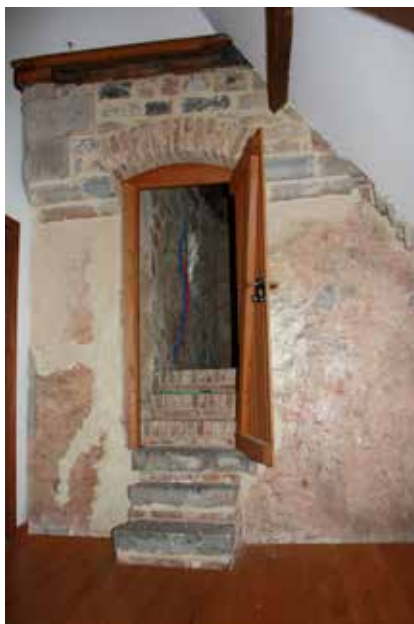
Fig. 22.- Enduit conservé sur le mur du dernier étage de la tour carrée adjacente à la maison Polchet à Macon. © Clémence Mathieu, 2011.
