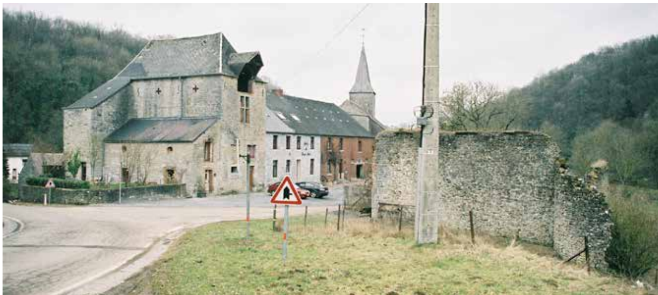
Fig. 16. - Habitat seigneurial de Lompret, depuis la route (avant restauration de la maison). © Clémence Mathieu, 2008.
