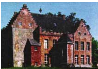
Fig. 27.- Maison seigneuriale du Quesnoy à Pottes, façade arrière (avant restauration, en 1997).
