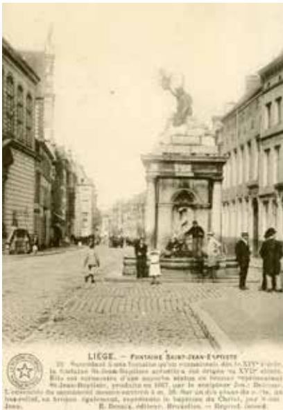
Fig. 43.- Liège, en Hors-Château, fontaine de saint Jean-Baptiste : à part les bordures en pierre bleue qui marque la saillie du trottoir, les sols sont entièrement couverts de pavés aux formes et formats divers, probablement en grès. L'ancienne chapelle des Ursulines, aujourd'hui disparue, marque le bord gauche du cliché. Carte postale ancienne, E. Desaix éditeur Bruxelles. Collections a.s.b.l. « Pierres et Marbres de Wallonie ».
