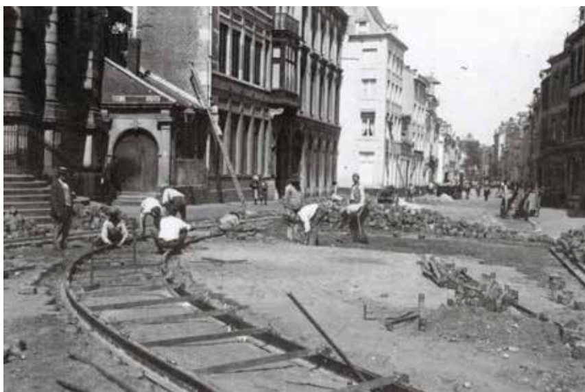
Fig. 24.- Liège, chantier du tram vers 1900 : on aperçoit à gauche la façade de l'église des Rédemptoristes, qui localise bien le cliché au milieu d'Hors-Château. Les équipes de paveurs sont occupées à poser les revêtements autour des rails du tram déjà installés. Cette cohabitation métal / pierre, délicate à gérer, a toujours fait l'objet de soins particuliers de mise en œuvre. Cliché ancien. Collections a.s.b.l. « Pierres et Marbres de Wallonie ».
