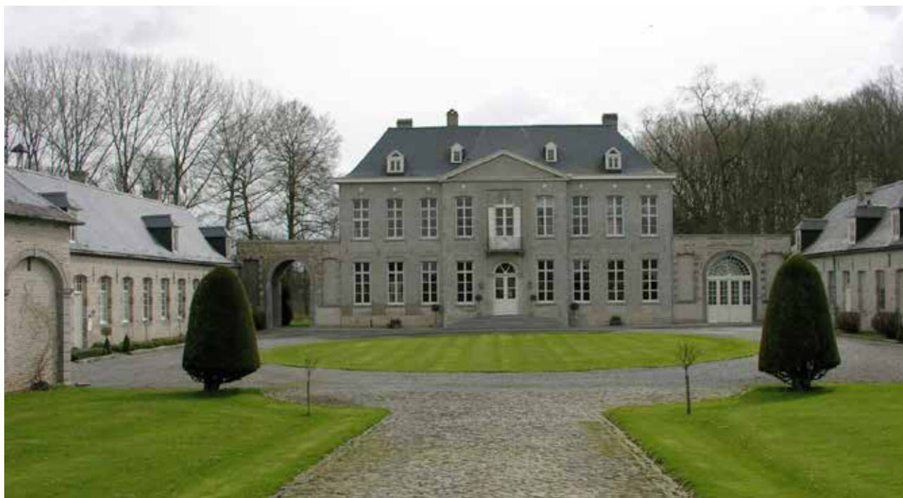
Fig. 4.- Maison entre cour et jardin de la Catoire à Blicquy, façade avant. © Clémence Mathieu, 2011.
