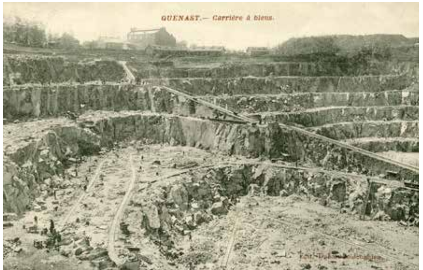
Fig. 3.- Quenast, « carrière à bleus » : exploitation en gradins d'un gisement de porphyre, avec rampe pour les rails du chemin de fer industriel. Les ouvriers, qui apparaissent comme des fourmis, donnent une idée de l'ampleur des fronts. Carte postale ancienne (cachet de 1911), édit. Dubois-Boidenghein. Collections a.s.b.l. « Pierres et Marbres de Wallonie ».
