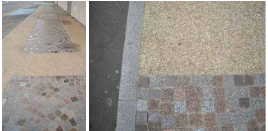
Fig. 19-20.- France, Wissant : la juxtaposition des matériaux de nature différente permet de marquer les zones dans leur fonctionnalité. Le jeu des tonalités entre matériaux nobles et bruts permet de conserver le continuum de fonction tout en minimisant les coûts. © AAVT sc/sprl, Liège.
