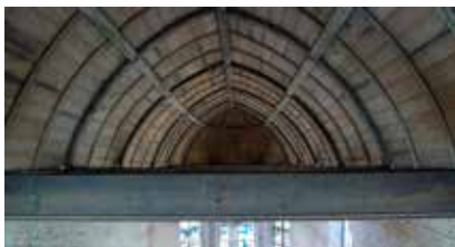
Fig. 8.- La charpente lambrissée de la chapelle.
