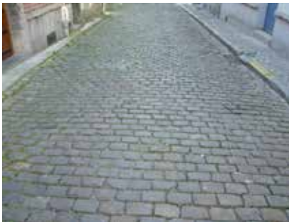
Fig. 13.- Tournai, rue du centre ville ayant conservé son revêtement ancien : la voie circulée est traitée en pavés disposés en lignes à joints alternés ; les bordures en pierre bleue flanquées d'un filet d'eau également en pavés alignés longitudinalement, délimitent d'étroits trottoirs en platines de grès. L'espace de façade à façade est ainsi clairement structuré en zones bien délimitées pour les différents usagers.
