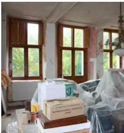
Fig. 30.- Une pièce du rez-de-chaussée de la maison seigneuriale de Monceau-Imbrechies (en cours de restauration). © Clémence Mathieu, 2011.
