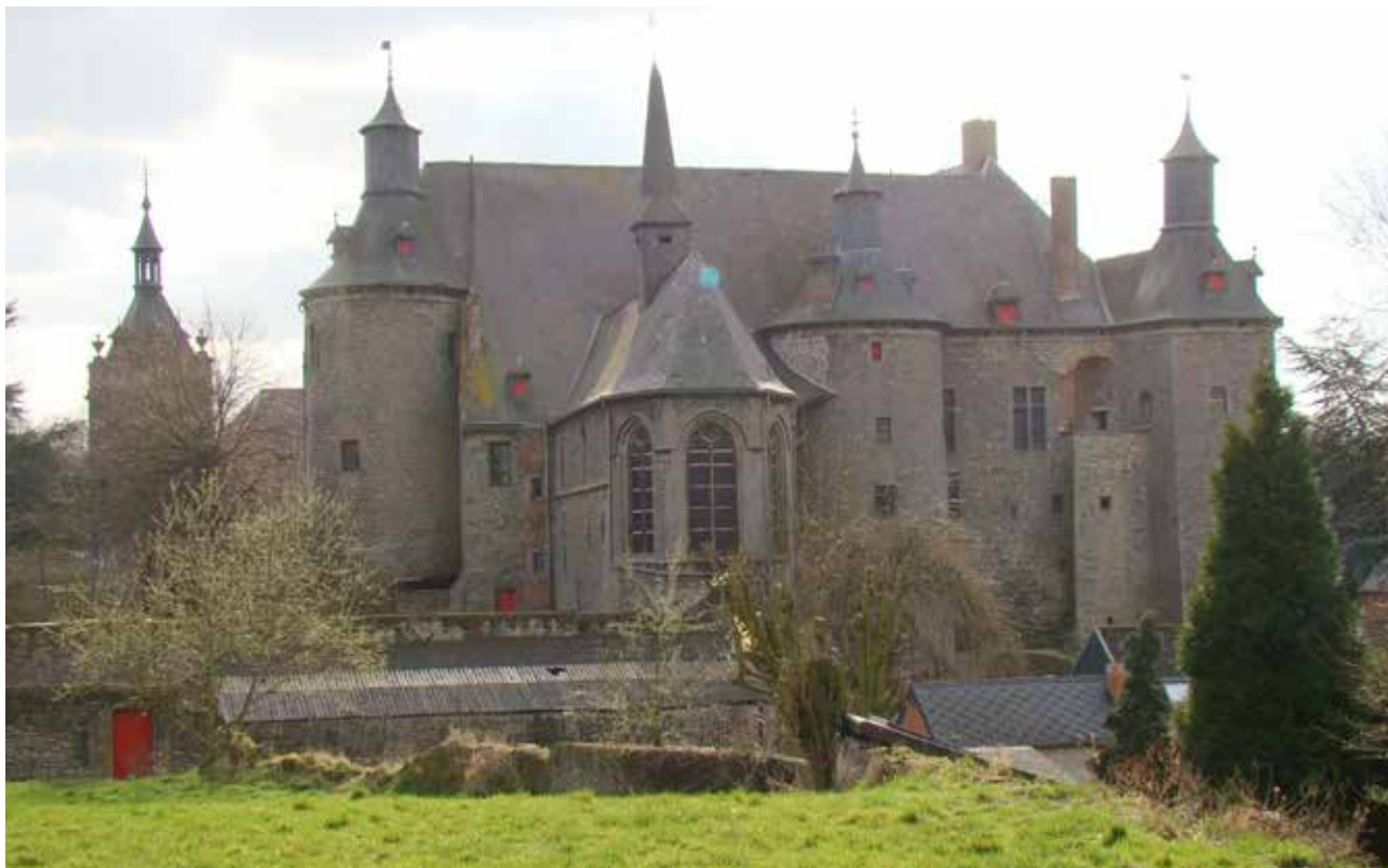
Fig. 2.- Vue générale de l'aile septentrionale avant les travaux de restauration. © Gérard Bavay, février 2010.
