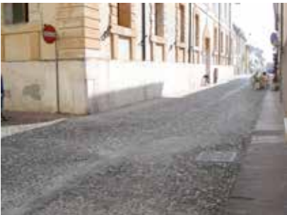
Fig. 22.- Italie, Sabbioneta : la chaussée, constituée de galets avec un filet d'eau central large de deux pavés, est liaisonnée aux soubassements crépis des immeubles contigus par des trottoirs de briques. © Maurice Lorenzi.
