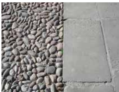
Fig. 15.- Italie, Bergamo, Città alta : l'aspect très minéral de la ville médiévale est souligné par des espaces carrossables en galets, tandis que les trottoirs, constitués de larges pierres plates, permettent une circulation piétonne sûre et confortable. © Maurice Lorenzi.
