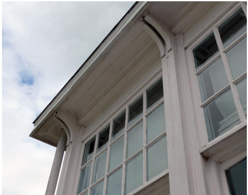
Fig. 49.- Demeure d'Artaize/Camion, détail de la liaison entre les poteaux et la corniche de la véranda.
