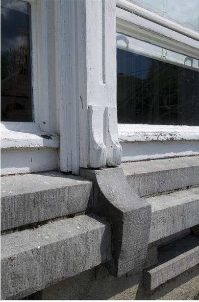
Fig. 48.- Demeure d'Artaize/Camion, détail de la liaison entre le soubassement et les poteaux de la véranda.
