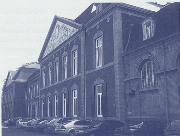
La façade à rue avec les nouveaux châssis oscillo-battants et les volets extérieurs au rez-de-chaussée
