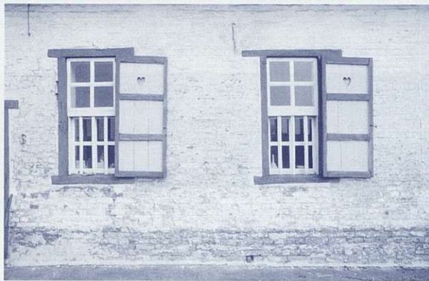
Fenêtres à châssis portants caractéristiques des campagnes hainuyères, Pétrieu à Béclers, XVIII e siècle. Ce modèle à traverse comprend un jour fixe dans la partie supérieure et un ouvrant barrcadé de bois dans le jour inférieur. État en 1986.
