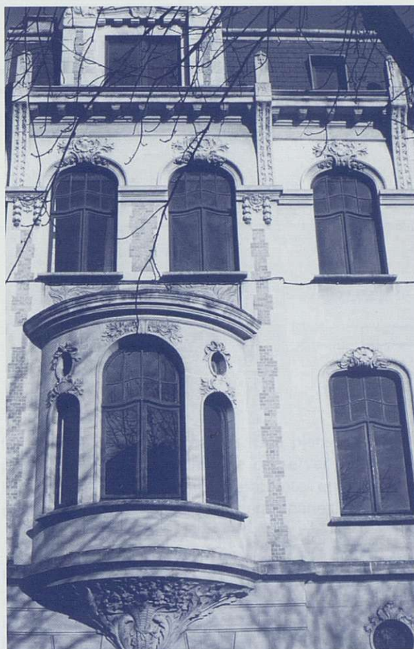
Une façade de style « Beaux-Arts » à Charleroi
