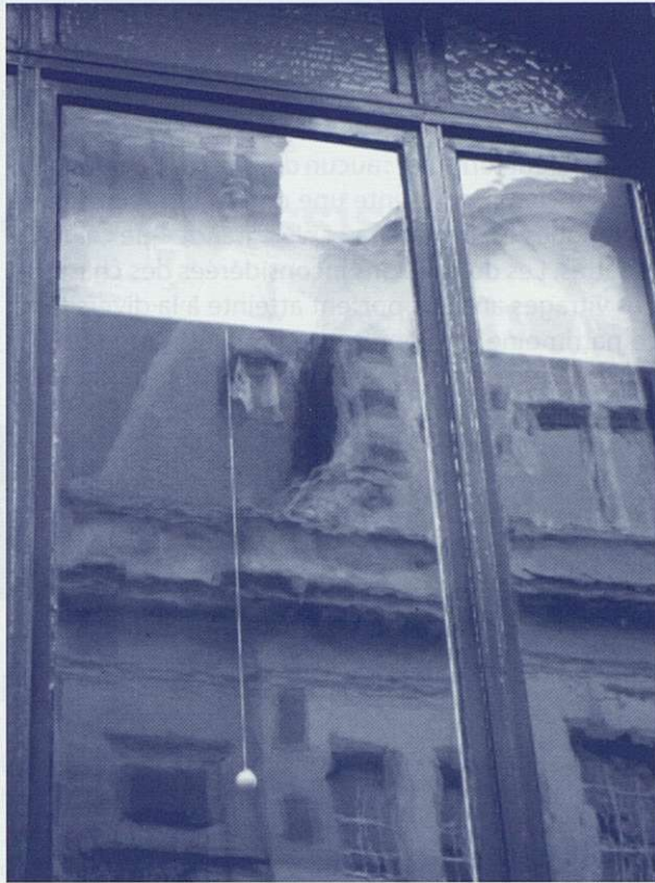
La texture incomparable du verre étiré-soufflé contribue à la valeur patrimoniale de cet immeuble datant de la fin du XIX e siècle, rue de Savoie à Saint-Gilles.
