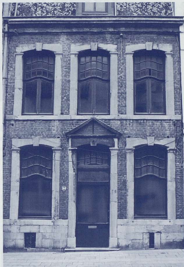
La façade avant restauration
