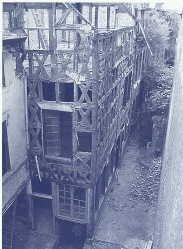
Colombages, Mont Saint-Martin à Liège – Photo DGATLP, SALg
