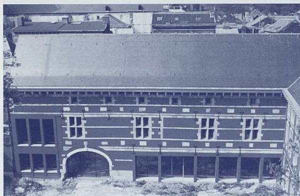
La résidence Curtius en cours d'aménagement, avril 2003 – Photo CRMSF
