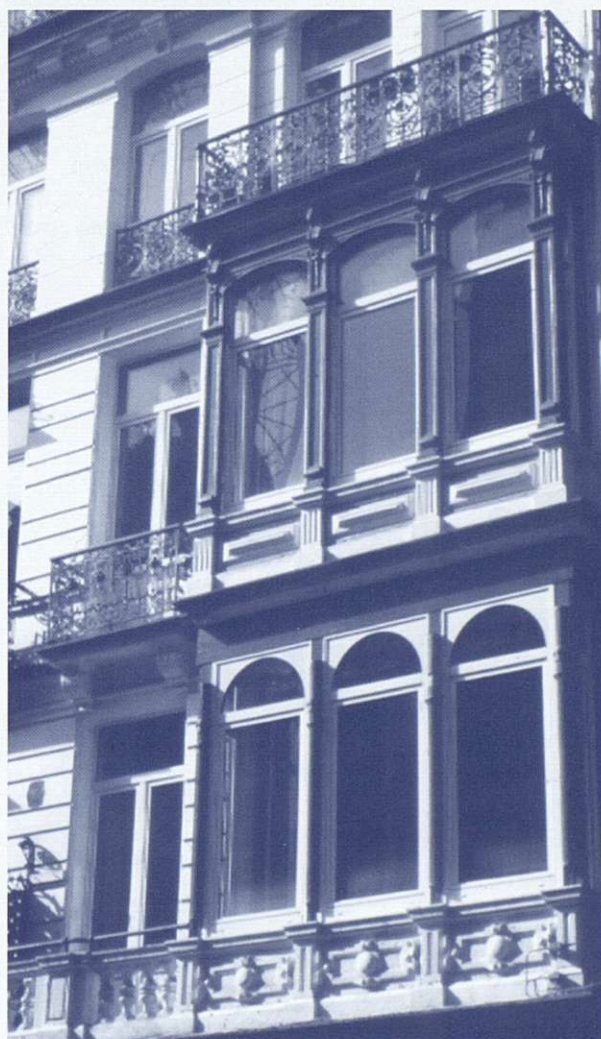
Immeuble à appartements datant de 1892, rue Antoine Dansaert à Bruxelles, défiguré par la pose de châssis à doubles vitrages. Les châssis en place ne posaient pourtant aucun problème de restauration.
