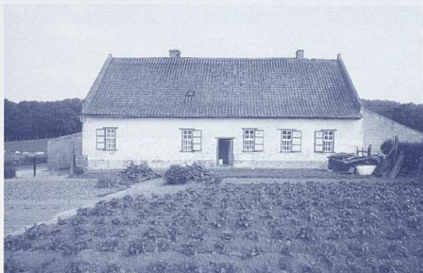
Les mêmes fenêtres, dans leur contexte, révèlent toute l'importance des ouvertures et de leurs châssis dans la cohérence de l'ensemble.
