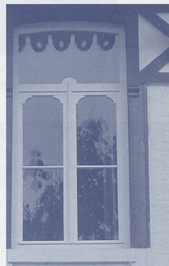
Châssis d'origine du Chalet du Parc
