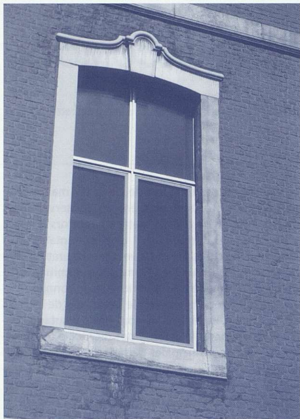
Un des nouveaux châssis en aluminium au « Château » du Val Saint-Lambert
