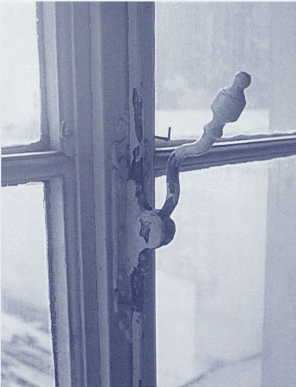
Crémone et châssis d'origine d'un immeuble datant de la fin du XVIII e siècle, rue du Poinçon à Bruxelles. De telles crémones sont devenues d'une exceptionnelle rareté.
