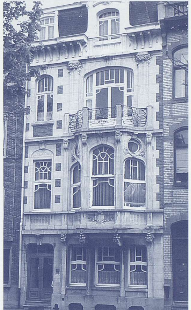
Immeuble construit vers 1925, avenue Broustin à Ganshoren. Le caractère raffiné de cette façade est porté essentiellement par le dessin subtil et incomparable des châssis.
