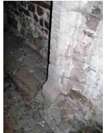
Fig. 12.- Détail de la base d'un piédroit et de l'âtre de la cheminée. Celui semble avoir été dallé de pierre.
