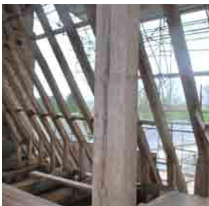
Fig. 21bis.- Traces d'échelons dans un poinçon.
