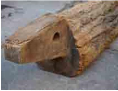
Fig. 12.- Détail d'une panne faîtière (nef centrale). Dans ce cas, le tenon est taillé dans la partie supérieure de la faîtière (voir photographie suivante).
