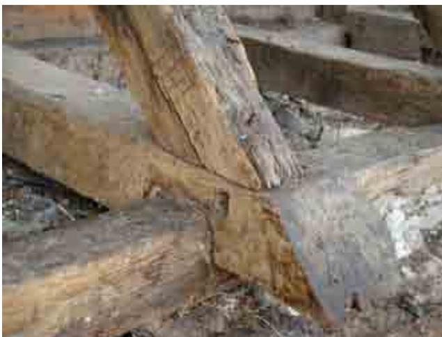
Fig. 19.- Détail de marquage de charpentier (IIII) à la base d'un chevron-arbalétrier.
