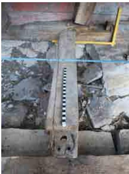
Fig. 26.- Détail de l'« échelon » reliant la sablière intérieure (en haut de la photographie) et la sablière extérieure (en bas de la photographie) (bas-côté sud). La sablière extérieure ayant été remplacée, on distingue dans le tenon correspondant de l'« échelon », le percement destiné à la cheville ainsi que deux trous correspondant aux clous plantés lors du remplacement de la sablière extérieure.
