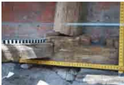
Fig. 27.- Détail de l'« échelon » reliant la sablière intérieure (au centre de la photographie) et la sablière extérieure (vers la gauche) (bas-côté sud). L'« échelon » est fixé à la sablière intérieure (vers le fond) par le biais d'un tenon fixé grâce à une cheville. Vers la droite, on distingue dans la sablière une encoche d'assemblage à mi-bois à queue d'aronde. La même forme, en positif, se trouve dans le blochet placé au-dessus de cette encoche.
