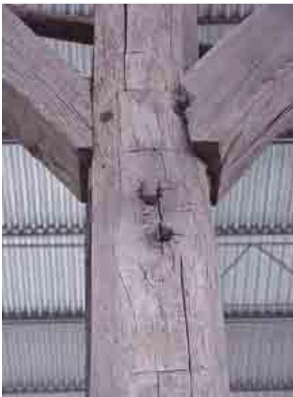
Fig. 11.- Détail d'assemblage : poinçon et deux contrefiches soutenant la sous-faîtière. Découpe adaptée autour de la base du tenon. L'extrémité inférieure de la contrefiche a été taillée de manière à épouser la partie rentrante du poinçon.
