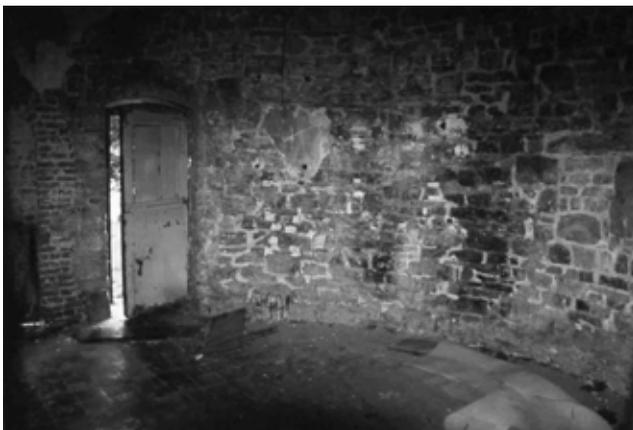
Fig. 35.- Intérieur du premier niveau. À gauche, insertion en brique de la cheminée des XIX<sup>e</sup>-XX<sup>e</sup> siècles ; à droite, armoire murale bouchée.
