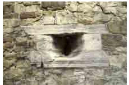
Fig. 39.- Extérieur de la seule canonniers intacte.
