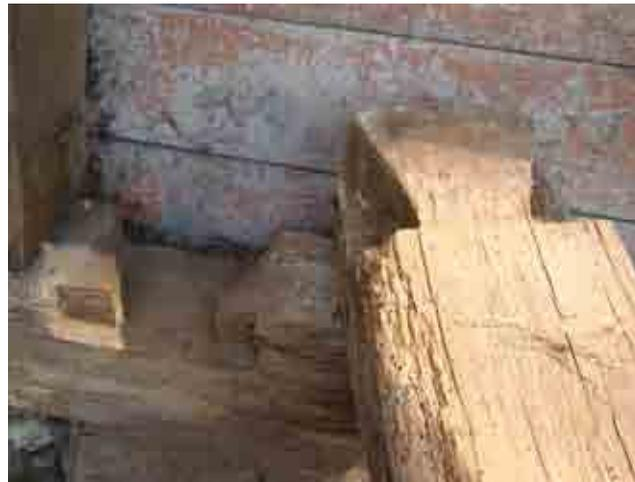
Fig. 18.- Détail de l'assemblage à queue d'aronde (empreinte en négatif sur la sablière intérieure) et positif (à l'extrémité du blochet) (bas-côté sud, avant renouvellement des charpentes).
