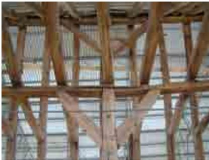
Fig. 6.- Entre les poinçons de la nef, les sous-faîtières soutiennent les faux-entrails (simplement posés) (avant restauration).
