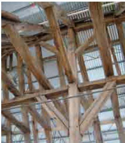
Fig. 21.- Le poinçon et les divers assemblages qui lui sont associés (charpente de la nef).
