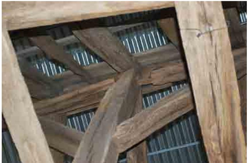
Fig. 16.- Détail de la partie supérieure d'un poinçon dans son état originel.
