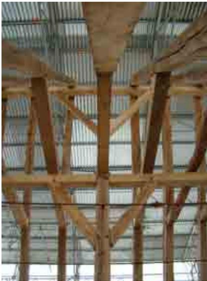
Fig. 10.- Détail de la partie supérieure de la charpente de la nef illustrant le fait que la plupart des pièces utilisées pour cette charpente sont de section comparable, sinon identique.
