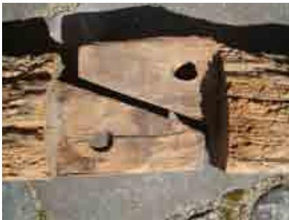
Fig. 14.- Simulation de l'assemblage de deux faîtières au point de jonction avec le poinçon.
