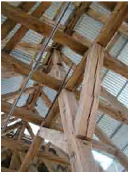
Fig. 24.- Détail d'assemblage : poinçon et deux contrefiches. Une cale particulière (traversante) est insérée sous le point de jonction des deux contrefiches avec le poinçon.
