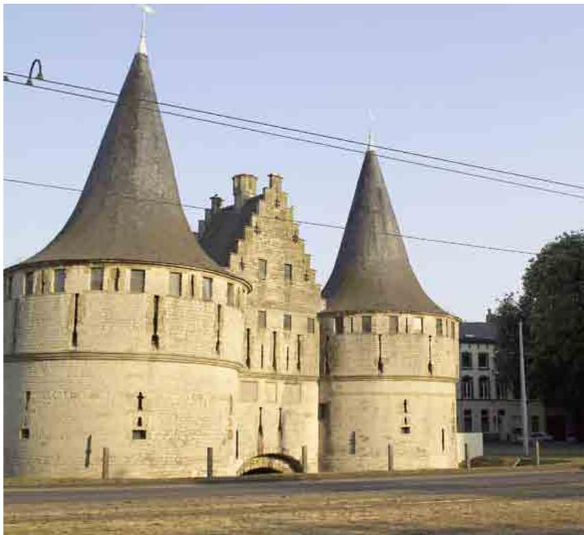
Fig. 47.- Détail d'une tour du Rabot, montrant les trois niveaux d'ouvertures de tir.
