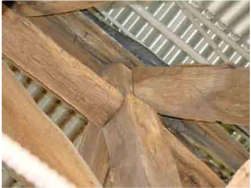
Fig. 15.- Détail de la partie supérieure des poinçons et de la liaison avec les chevrons-arbalétriers. Ces derniers sont terminés par des tenons qui sont engagés dans des mortaises symétriques creusées juste en dessous du sommet du poinçon. Situation avant travaux montrant la faîtière de section triangulaire.
