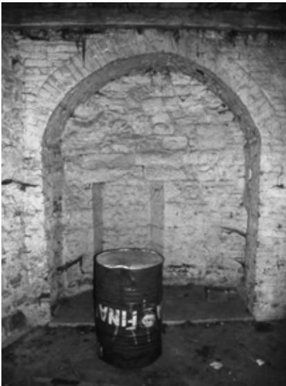
Fig. 10.- Vue intérieure du premier niveau dans l'axe de la porte ; une archère-canonnière obturée s'ouvre dans une niche.
