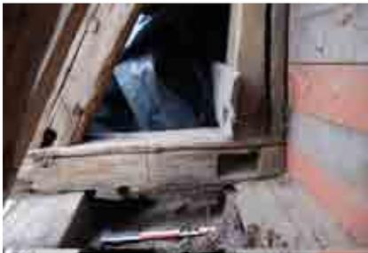
Fig. 30.- Trace de rainure dans un blochet (pour un ancien plafond ?) dans une pièce de remploi de la charpente du chœur, côté sud.
