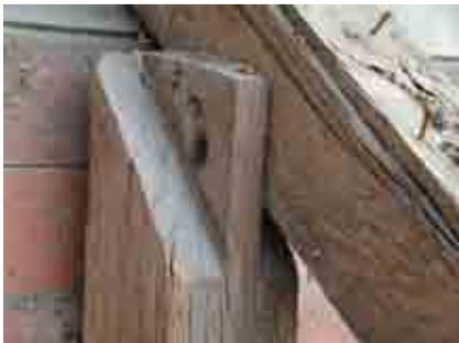
Fig. 25.- Détail de la jonction de la jambette et d'un chevron-arbalétrier (bas-côté sud). Situation avant restauration. Ce détail montre que la charpente avait fait l'objet de transformations. L'une de celles-ci avait abouti à désolidariser la jambette du chevron-arbalétrier. Toutefois, cette même jambette était encore sommairement utilisée comme appui du chevron-arbalétrier.
