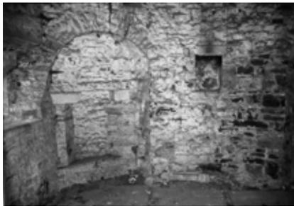
Fig. 14.- Paroi sud-ouest du deuxième niveau (premier étage), avec une archère-canonnnière obturée dans une niche et, à gauche, une armoire murale ou « niche à lumière ».
