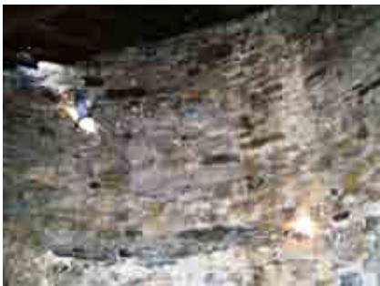
Fig. 37.- Intérieur obturé de la troisième canonniers, au niveau supérieur. L'encadrement de pierre de taille est totalement conservé, contrairement à l'extérieur.
