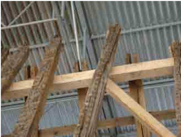
Fig. 17.- Assemblage à enfourchement des chevrons-arbalétriers en prenant appui sur la faîtière de la nef principale.
