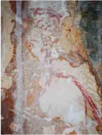
Le mur nord du bas-côté ouest présente une stratigraphie complexe qui est difficile à déchiffrer. Un mortier rosé est appliqué sur la maçonnerie. Un second mortier blanc est appliqué par-dessus et couvert de la couche picturale à faux appareil ocre jaune. Quelques fragments de polychromie ocre rouge y sont observables.
