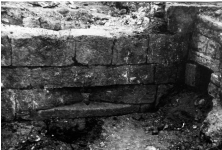
Fig. 29.- Vue intérieure de la même canonnière avec son bouchon de fermeture en pierre.
