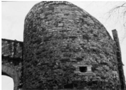
Fig. 33.- Face sud de la tour Joyeuse, avec les trois canonniers en place. La flèche indique le seuil extérieur conservé de celle du niveau supérieur.
