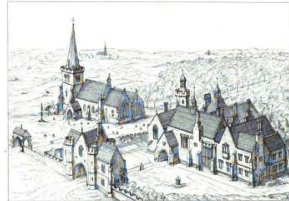
ANCIENNE MAISON DE CAMPAGNE
